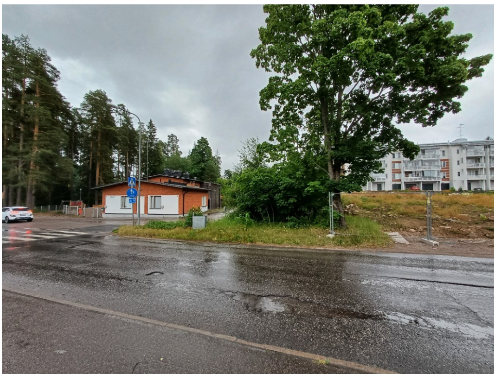
Suunnittelualueen pohjoisosasta purettiin päiväkotirakennus (kuvassa vasemmalla oleva tiilirakennus) syksyllä 2025. Eteläosassa on aloitettu, sittemmin keskeytetyn, kerrostalohankkeen maatyöt (kuvassa oikealla). Kuva on kesältä 2024.
