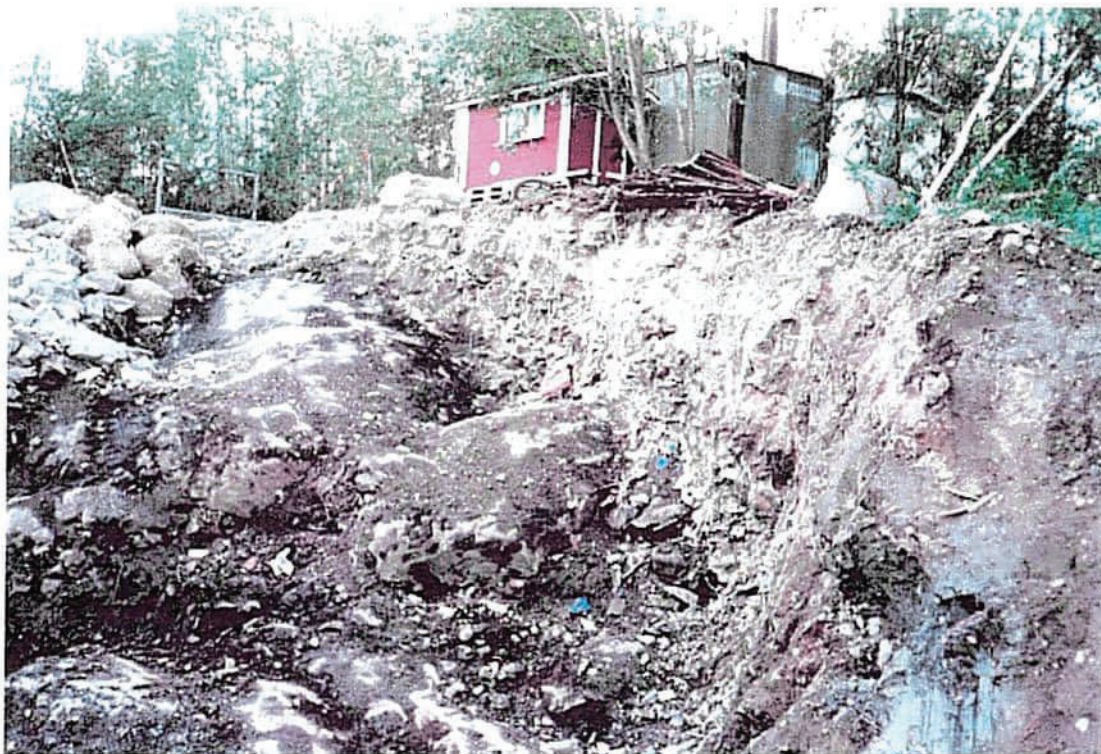
Kuva 3. Kaivannon maston puoleinen seinä
