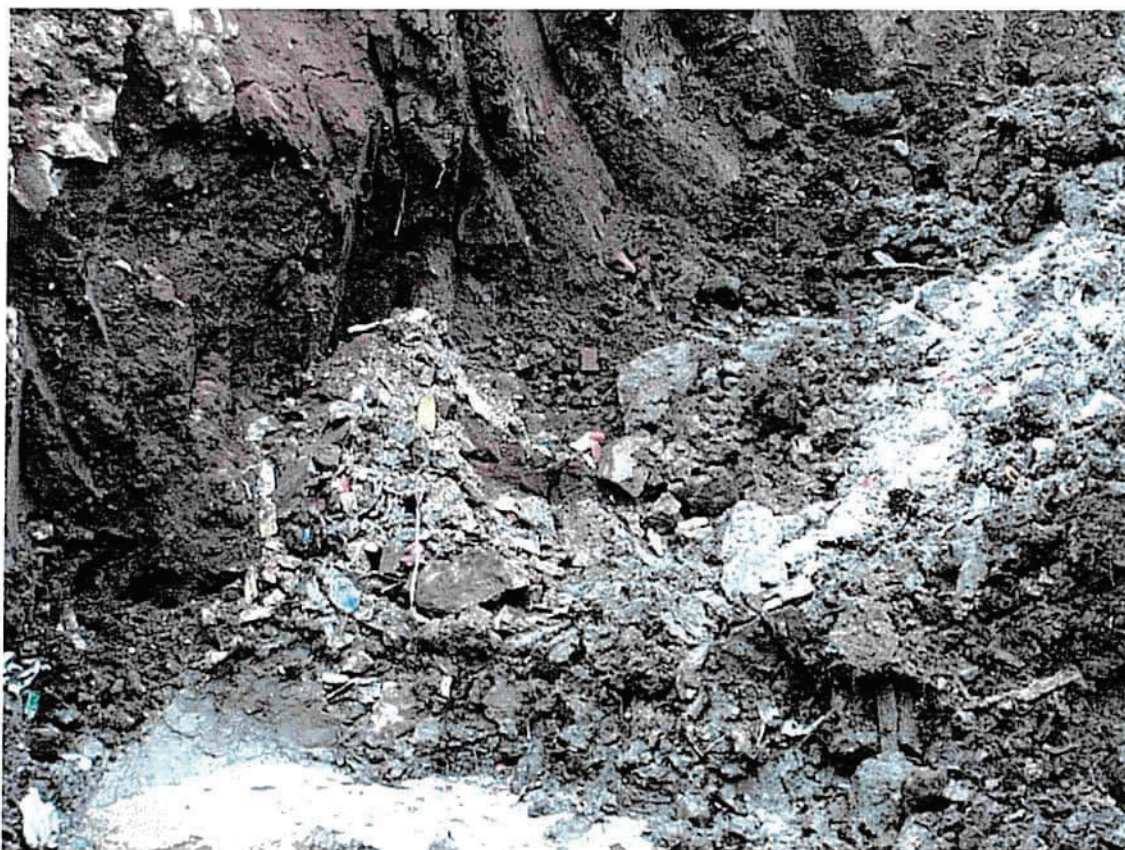
Kuva 7. Roskainen kerros kaivannon pohjalla
