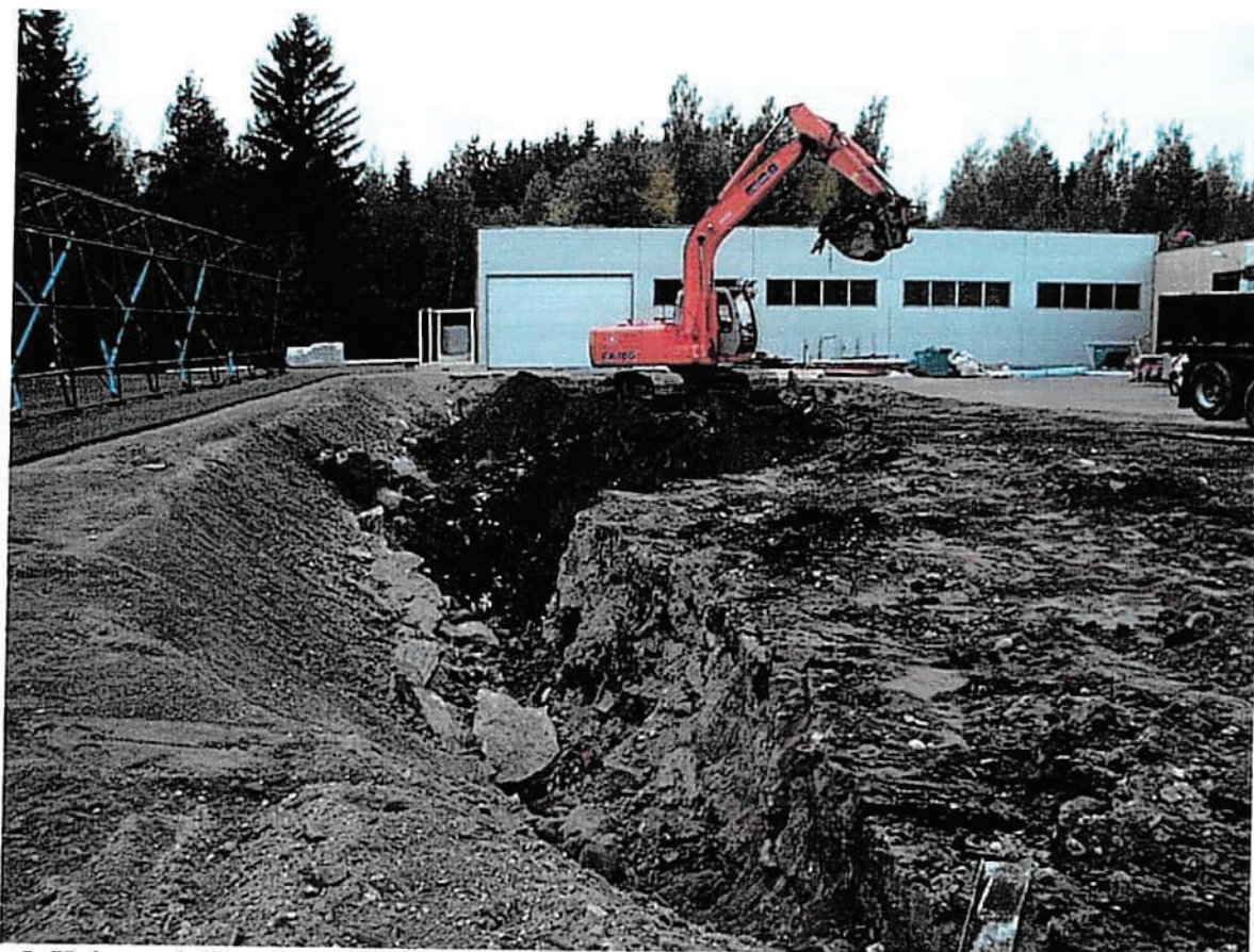
Kuva 5. Kaivun aloittaminen pihan keskeltä
