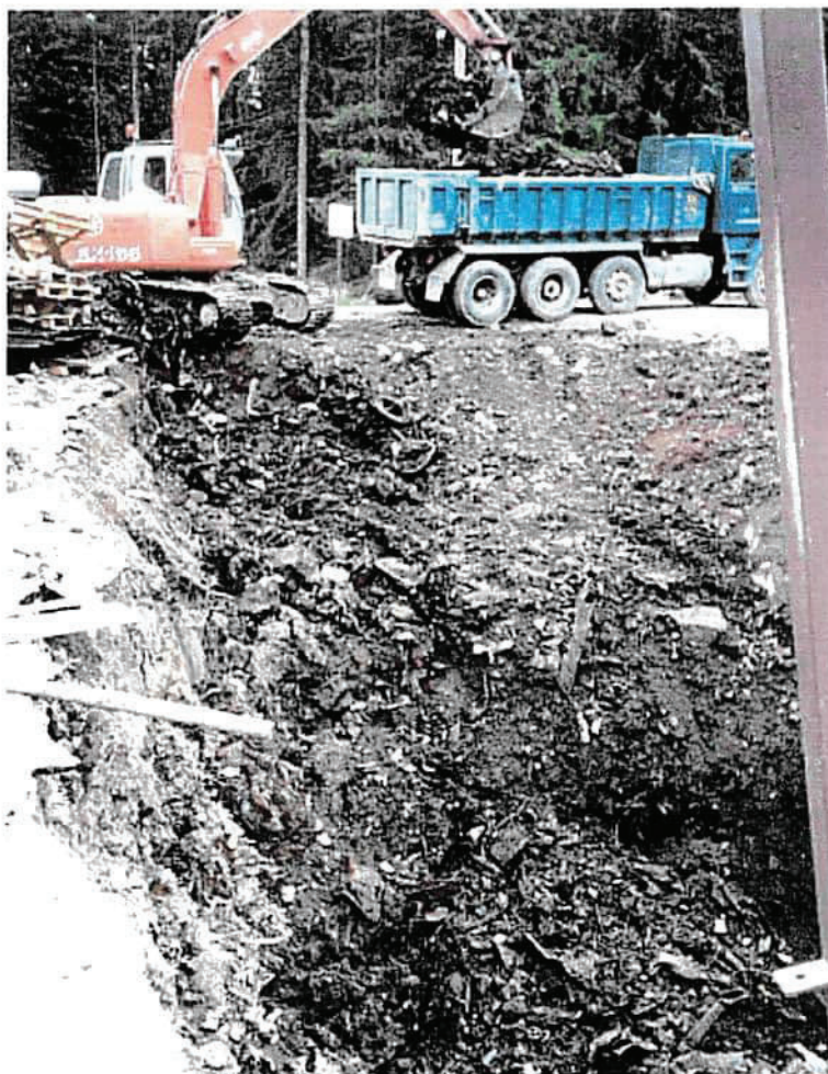
Kuva 2. Kaivannon Teollisuustien puoleinen pääty
