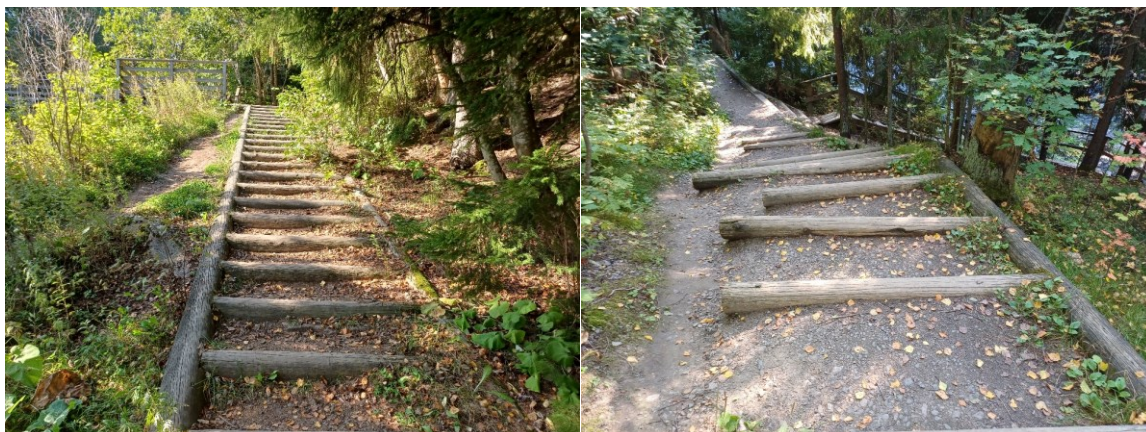
Kuva 15. Siippoontien eteläpuolisen osan tukkiportaikkoja.
