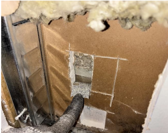
Kuva 96 VS2. Keittiön vastaista väliseinää.
