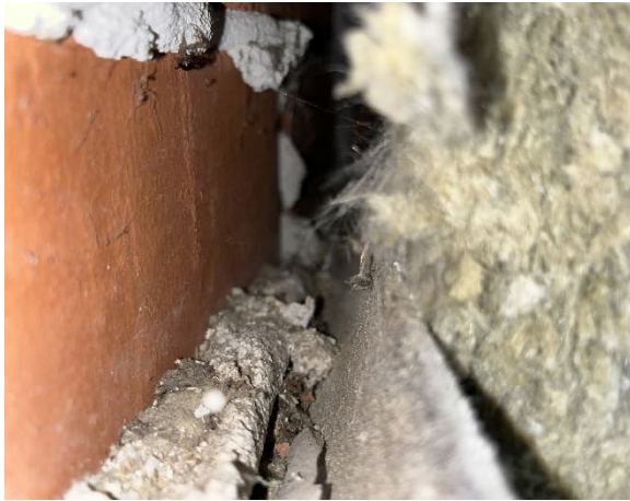
Kuva 45 US1. Tuuletusrakoa.
