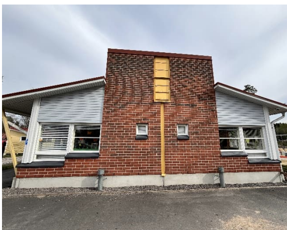
Kuva 38 Rakennuksen pohjoispuolen päätyseinää.
