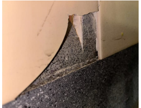
Kuva 97 VS2. Keittiön puolelta. Vahnaa lattiapinnoitetta laatan alla.
