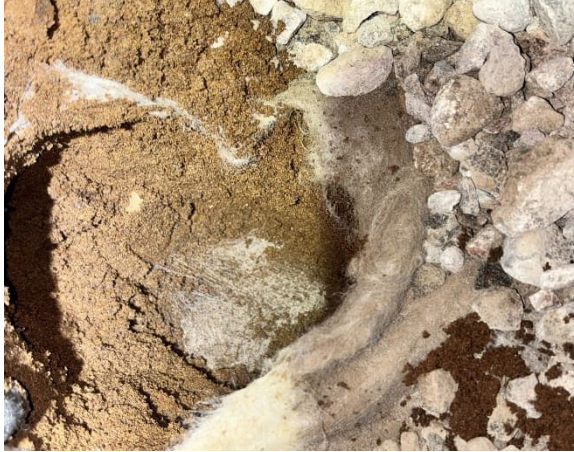
Kuva 27 Alapohjan täyttöä. Sepelin alla on kangas ja hieno hiekkakerros.
