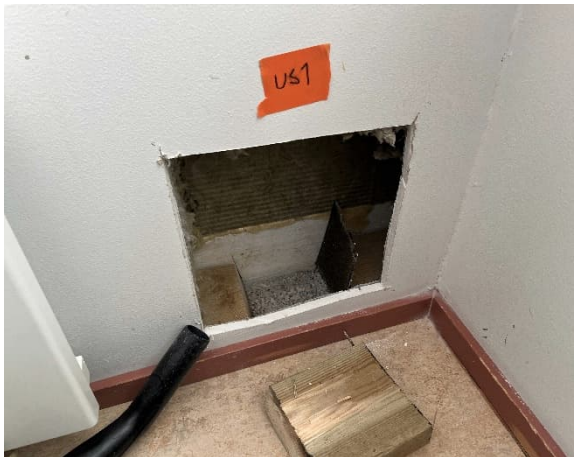
Kuva 43 US1. Rakenneavaus tehtiin ulkonurkkaan.
