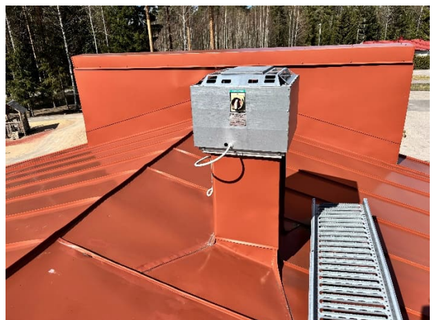
Kuva 113. Poistoilmapuhallinta.
