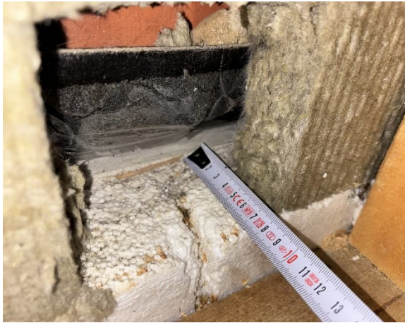
Kuva 67 US6. Sokkelihalkaisun EPS-eriste n. 80 mm.
