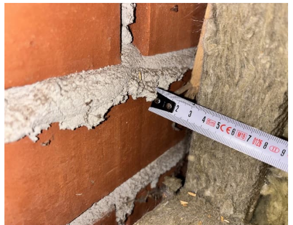
Kuva 72 US7. Tuuletusrakoa.
