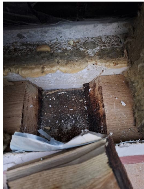
Kuva 79 US11. Alaohjauspuun alla bitumikermi.
