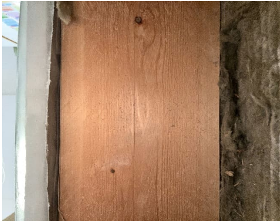
Kuva 73 US7. Puurakenteissa ei havaittu kosteus- tai vauriojälkiä.
