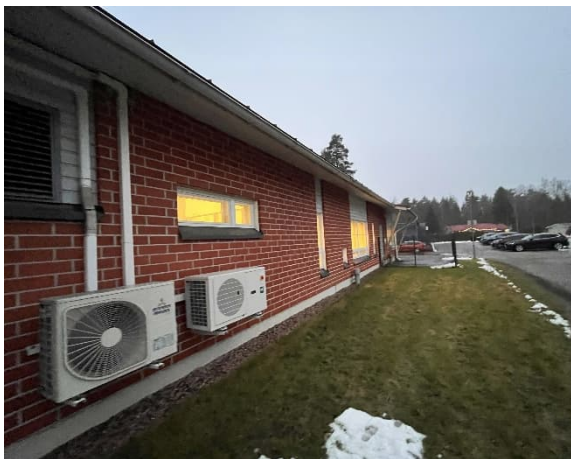
Kuva 36 Ulkoseinää, keittiön sisäänkäynnin puolelta.
