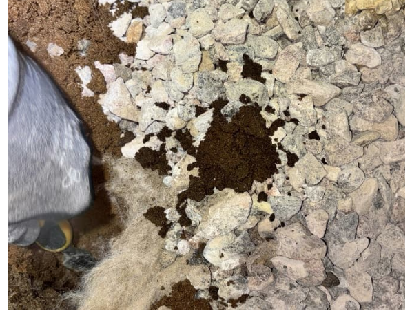
Kuva 28 Hienon hiekkakerroksen alla on kangas ja märkä perusmaa.
