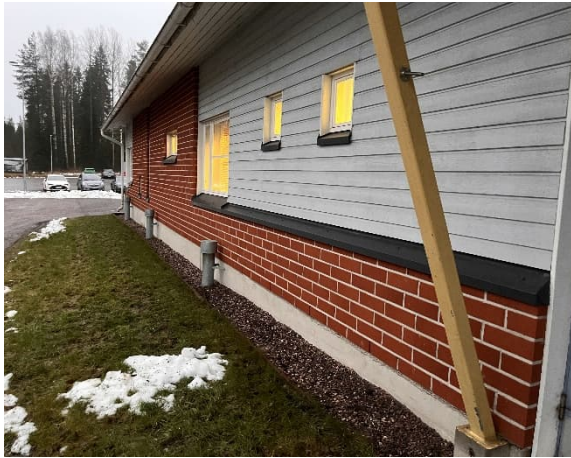
Kuva 34 Rakennuksen ulkoseinä on tiili- ja puuverhoiltua.
