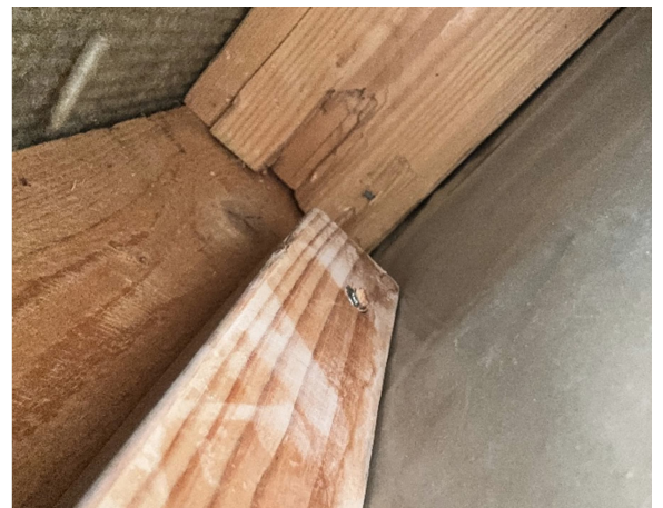
Kuva 64 US5. Ikkunan alapuolisissa puurakenteissa ei havaittu vauriojälkiä.
