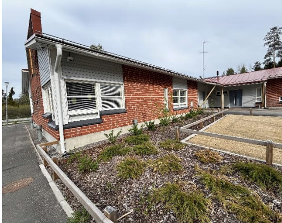
Kuva 17 Rakennuksen vierustaa ja sadevesien ohjausta.
