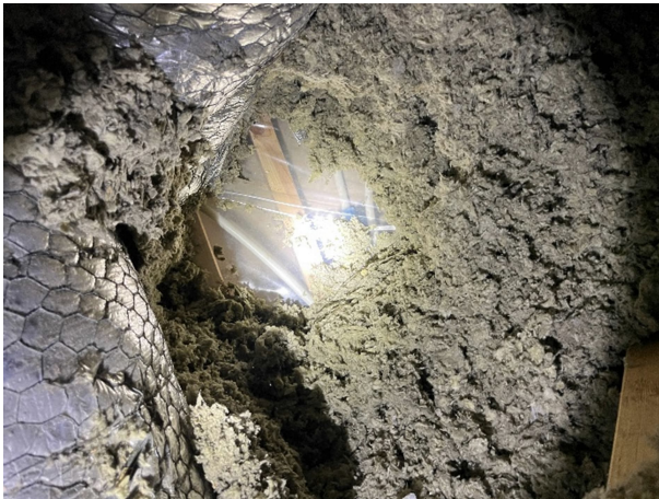
Kuva 122. Puhallusvillan alla muovi.
