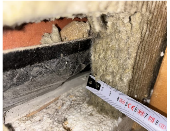
Kuva 68 US6. Tuulensuojavilla 50 mm.
