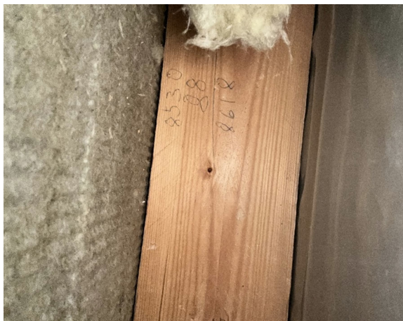
Kuva 63 US5. Ikkunan alapuolisissa puurakenteissa ei havaittu vauriojälkiä.
