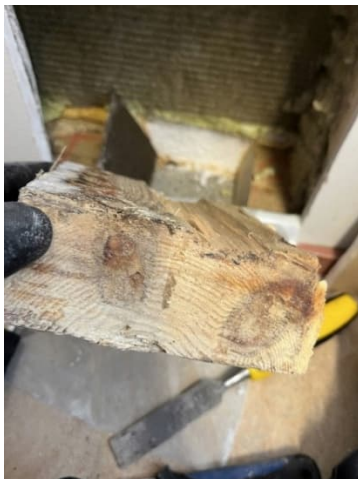
Kuva 51 US2. Alaohjauspuut ovat kuivia.
