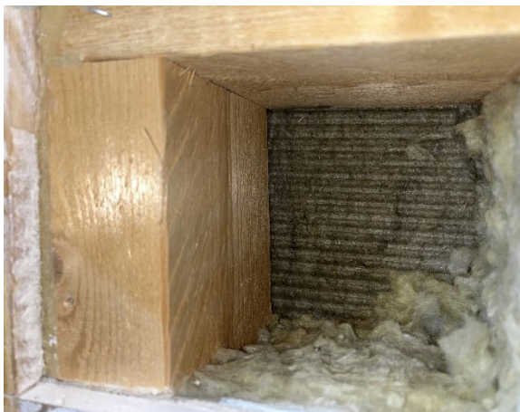
Kuva 59 US4. Ikkunan alla ei havaittu valumajälkiä.
