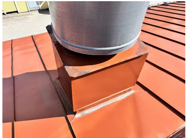
Kuva 111. Läpivienneissä ei havaittu puutteita.
