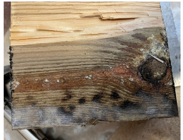
Kuva 52 US2. Alaohjauspuuta. Puussa oli vanhoja jälkiä arviolta rakennusajalta.
