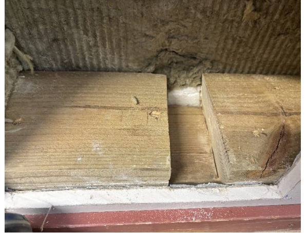
Kuva 62 US5. Ulkoseinärakennetta. Ylempi alaojhauspuu vajaa metrin pituinen.
