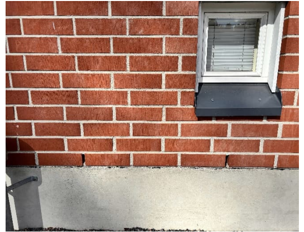
Kuva 35 Tiilimuurauksessa tuuletusraot.
