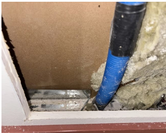
Kuva 94 VS1, rakenneavaus tehtiin pesuhuoneen vastaisen seinän alaosaan.
