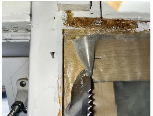
Kuva 58 US4. Höyrinsulkua on irtonainen.
