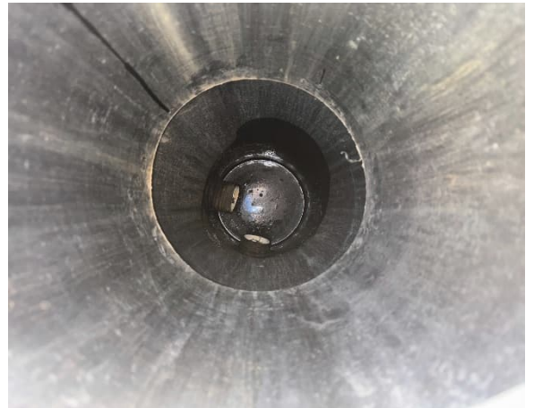
Kuva 14 Salaojan tarkastuskaivo.
