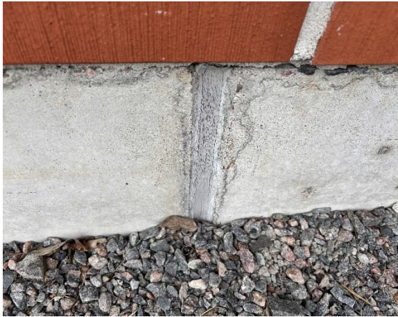
Kuva 41 Sokkelin elementtisaumaa.
