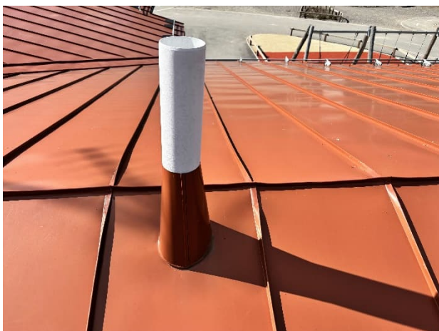
Kuva 112. Viemärin tuuletusputkea.
