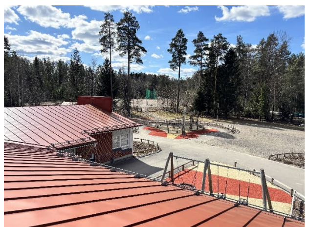
Kuva 115. Yleiskuvaa katolta. Lumiesteet on asennettu sisäpihan puolelle.
