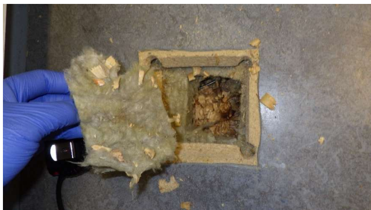
Kuva 8. Rakenneavaus RA1 tilassa 125.
