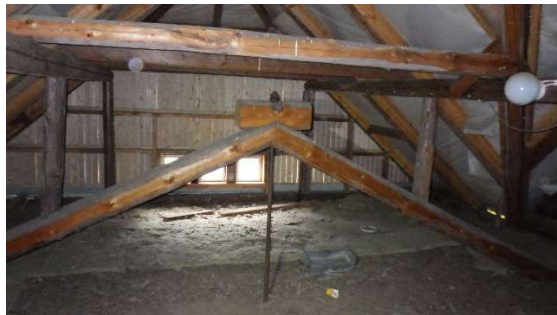
Kuva 38a-b. Vesikattorakenne on paikoin hyvin yksinkertainen. Vanhat aluskatteet on viilletty paikoin ilmeisesti tarkoituksellisesti auki (oikea kuva).
