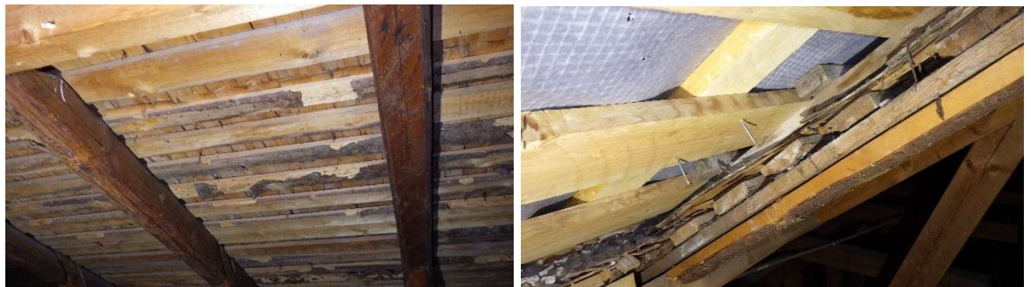
Kuva 37a-b. Uusi vesikate on asennettu paikoin vanhan pärekaton päälle.
