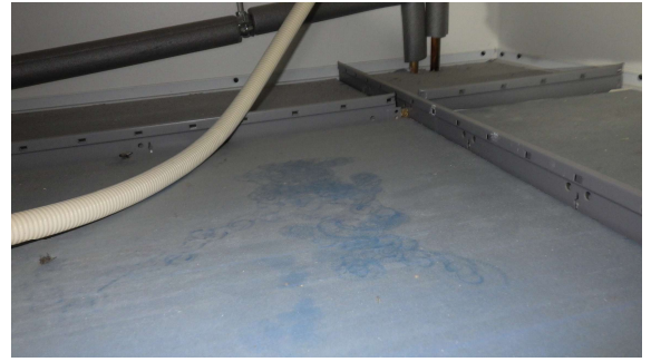
Kuva 35b. Pölyä alaskun AL3 yläpuolisessa tilassa.
