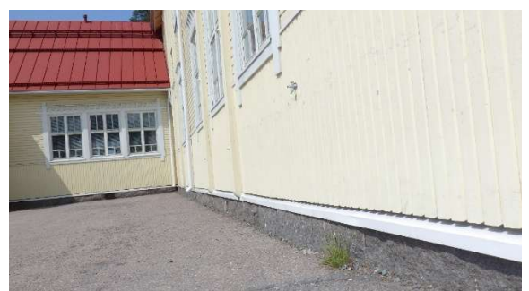
Kuva 48. Sadevedenohjauksessa ei havaittu puutteita. Asfaltin kaato ohjaa syöksytorvista vedet rakennuksesta poispäin.
