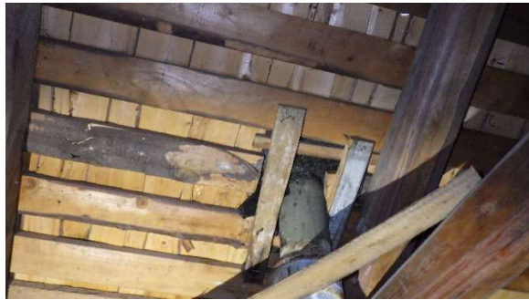
Kuva 40a-b. Esimerkkejä vesikaton läpivienneistä.
