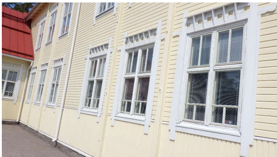
Kuva 22. Julkisivut on uusittu vuonna 2020 ja ne ovat hyvässä kunnossa.
