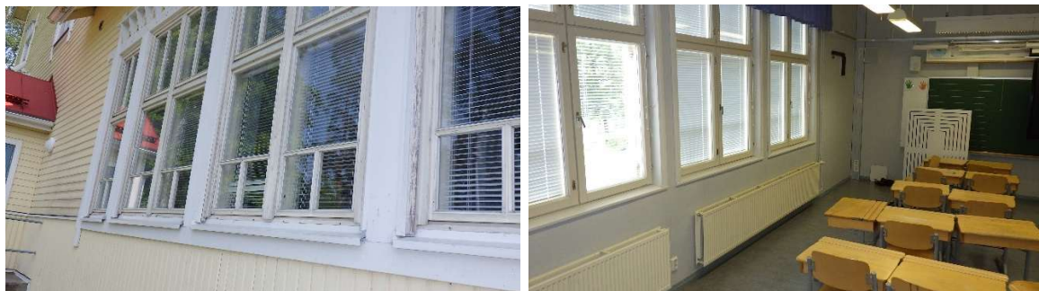
Kuva 23a-b. Ikkunat ovat sisäpuolelta hyvässä kunnossa ja ulkopuolelta vähintään välttävässä kunnossa. Ikkunoiden ulkopintojen maaleissa havaittiin paikoin rappeutumista.
