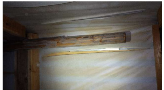
Kuva 38a-b. Vesikattorakenne on paikoin hyvin yksinkertainen. Vanhat aluskatteet on viilletty paikoin ilmeisesti tarkoituksellisesti auki (oikea kuva).
