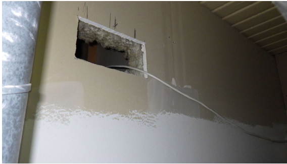
Kuva 35a. Läpivienti ja avointa mineraalivillaa 1. kerroksen siivouskomeron (AL3) alaslasketun katon yläpuolisessa tilassa.
