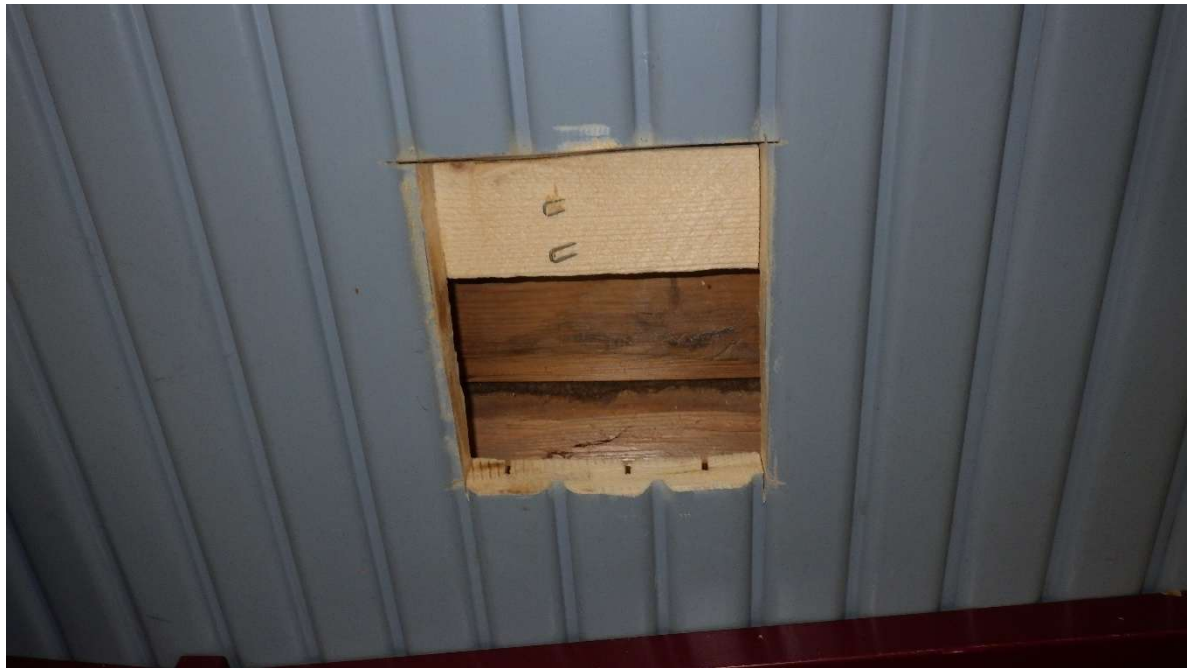
Kuva 30. Väliseinän rakenneavaus tilassa 113 (RA22).
