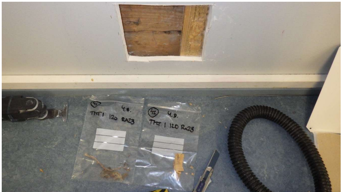
Kuva 31. Väliseinän rakenneavaus tilassa 120 (RA23). Rakenneavaus tehtiin WC:n käsienvesualtaan kohdalle luokkatilan puolelle.
