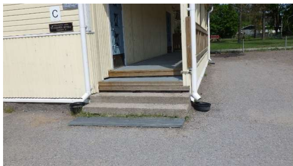
Kuva 48. Sadevedenohjauksessa ei havaittu puutteita. Asfaltin kaato ohjaa syöksytorvista vedet rakennuksesta poispäin.
