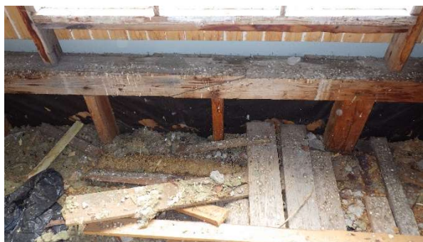
Kuva 43a-b. Yläpohjatilassa on runsaasti epäpuhtauksia.
