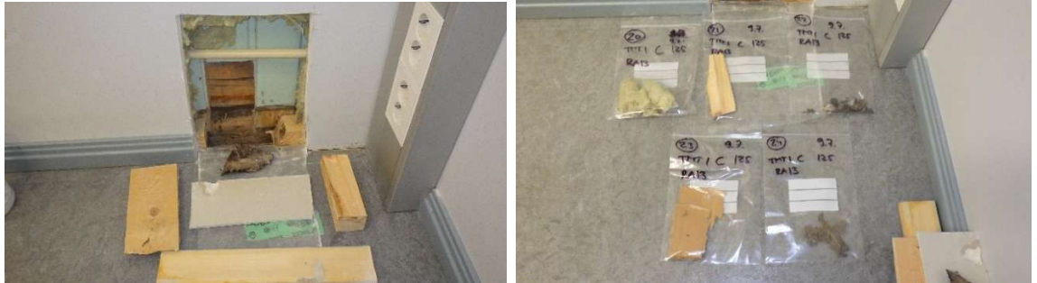
Kuva 26a-b. Esimerkkikuvat hirsirunkoisen ulkoseinän rakenneavauksesta ja materiaalinäytteistä (tila 125, RA13).
