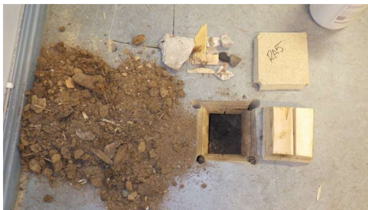
Kuva 20. Rakenneavaus RA5 tilassa 204.
