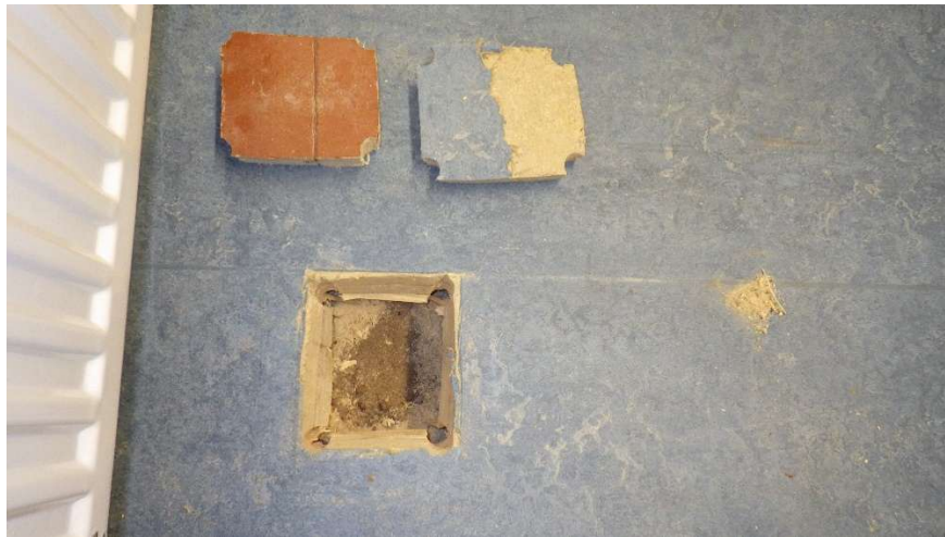
Kuva 9. Rakenneavaus RA2 tilassa 120.
