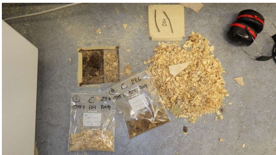
Kuva 11. Rakenneavaus RA4 tilassa 104.
