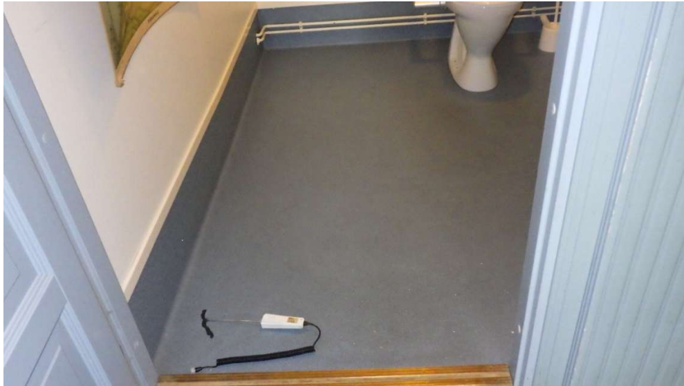
Kuva 5. Märkätilan muovimatto (inva-WC).
