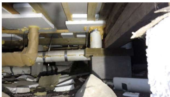
Kuva 11a-b. Rakennusjätettä ryömintätilassa.
