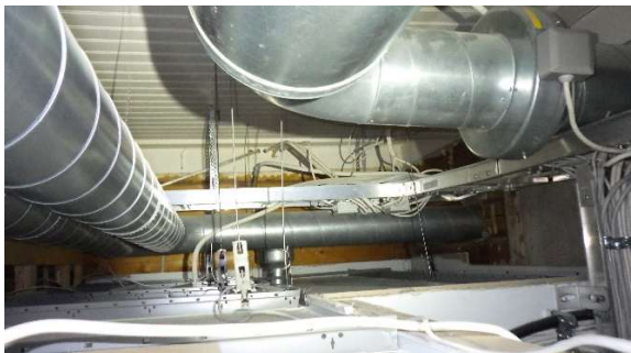
Kuva 27a. Tilan 14, eteinen, alaslasketun katon yläpuolista tilaa (AL2).
