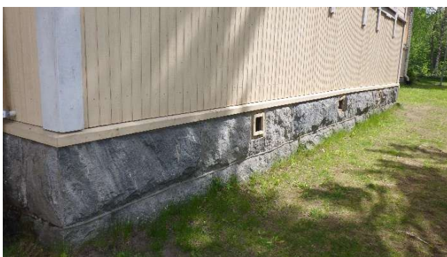
Kuva 15a-b. Luonnonkivisokkeli. Sokkelin tiiveydessä on paikoin puutteita.
