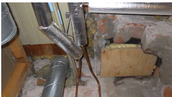
Kuva 28c. Paikkaus yläpohjan suuntaan (AL3).
