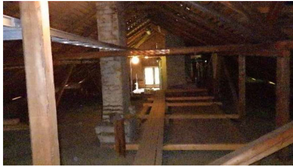
Kuva 34a-b. Yläpohjatilassa on reilu ilmatila ja ilma vaihtuu aistinvaraisesti arvioituna hyvin. Räystäällä oleviin ilma-aukkoihin on asennettu pieneläinverkot.
