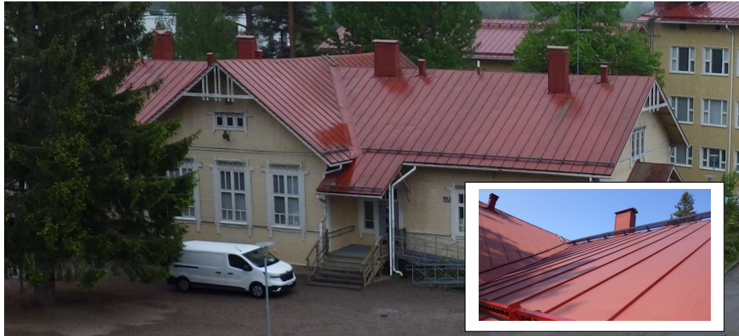
Kuva 30a-b. Vesikaton yleiskunto on hyvä.
