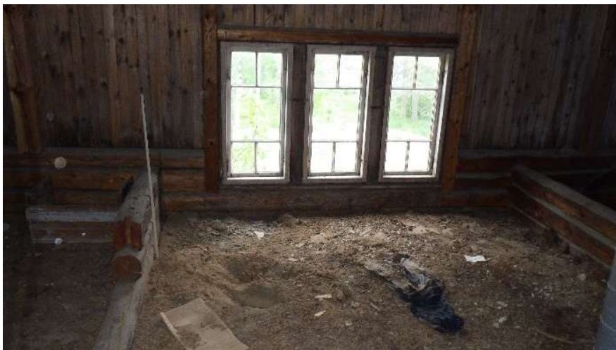
Kuva 17. Ullakon ikkunoita ei ole uusittu peruskorjauksen yhteydessä.
