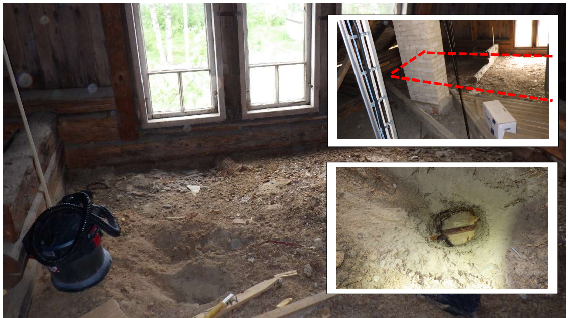
Kuva 35a-c. Ullakon molemmissa päädyissä on vanhat eristeet.
