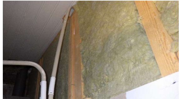
Kuva 28f. Avointa mineraalivillaa (AL3).
