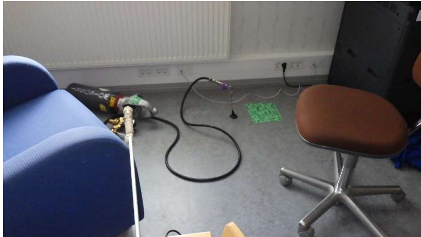
Kuva 8. Tilassa 13 havaittiin yksittäinen pistemäinen vuotokohta alapohjarakenteen ja ulkoseinän liitoksessa. Rakenne oli tutkimuksen perusteella muilta osin tiivis.
