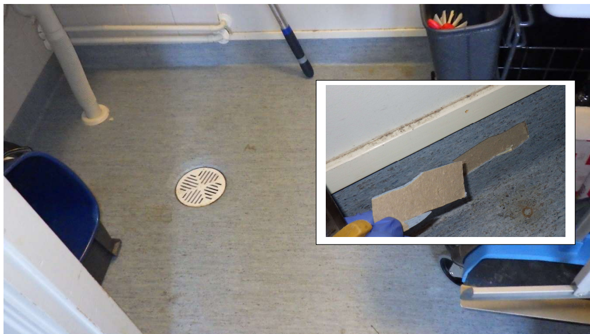
Kuva 5a-b. Märkätilan muovimatto (tila 18).
