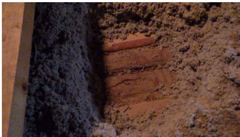
Kuva 36. Ullakon keskiosan eristeet on vaihdettu puhallusvillaan (ekovilla).
