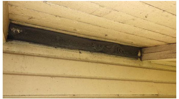
Kuva 34a-b. Yläpohjatilassa on reilu ilmatila ja ilma vaihtuu aistinvaraisesti arvioituna hyvin. Räystäällä oleviin ilma-aukkoihin on asennettu pieneläinverkot.
