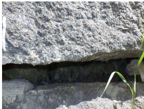
Kuva 15a-b. Luonnonkivisokkeli. Sokkelin tiiveydessä on paikoin puutteita.
