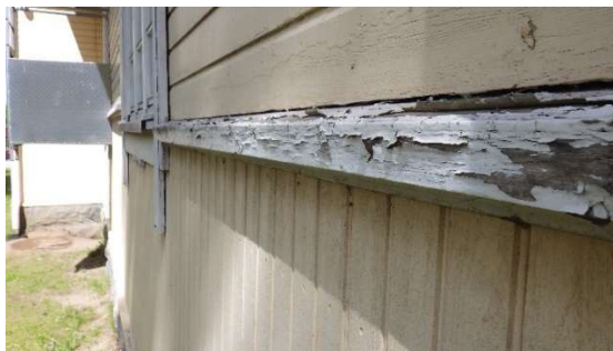
Kuva 14a-b. Yleiskuva julkisivusta. Julkisivumaalissa havaittiin paikoin rappeutumista.
