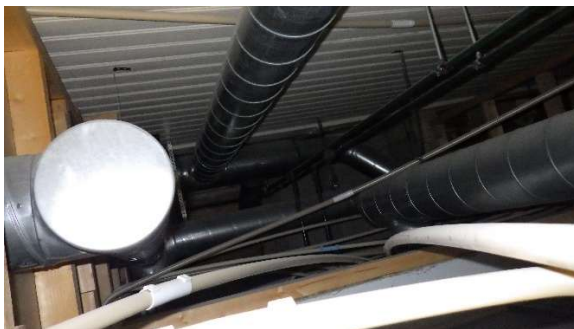
Kuva 26a. Tilan 10 WC (AL1) alaslasketun katon yläpuolista tilaa .
