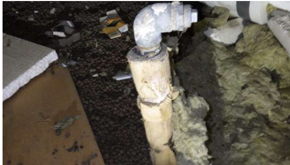
Kuva 12a-b. Vanha aaltopahvipintainen eriste saattaa sisältää asbestia ja rikkoutunut tuulensuojalevy.
