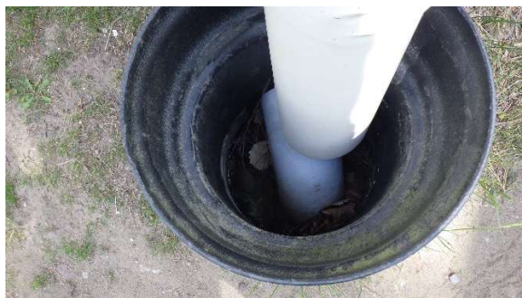
Kuva 37a-d. Sadevedenohjauksessa havaittiin paikoin puutteita (oikeanpuoleiset kuvat).
