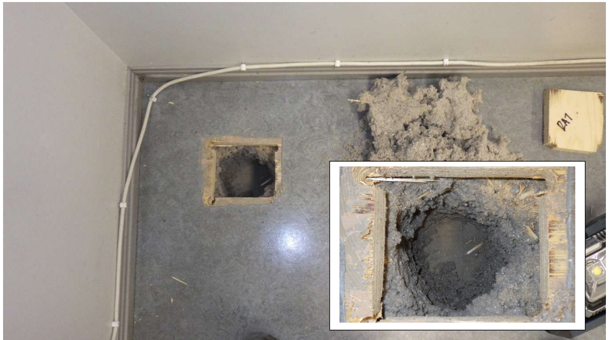
Kuva 7a-b. Esimerkkikuvat rakenneavauksesta (tila 03, RA1).
