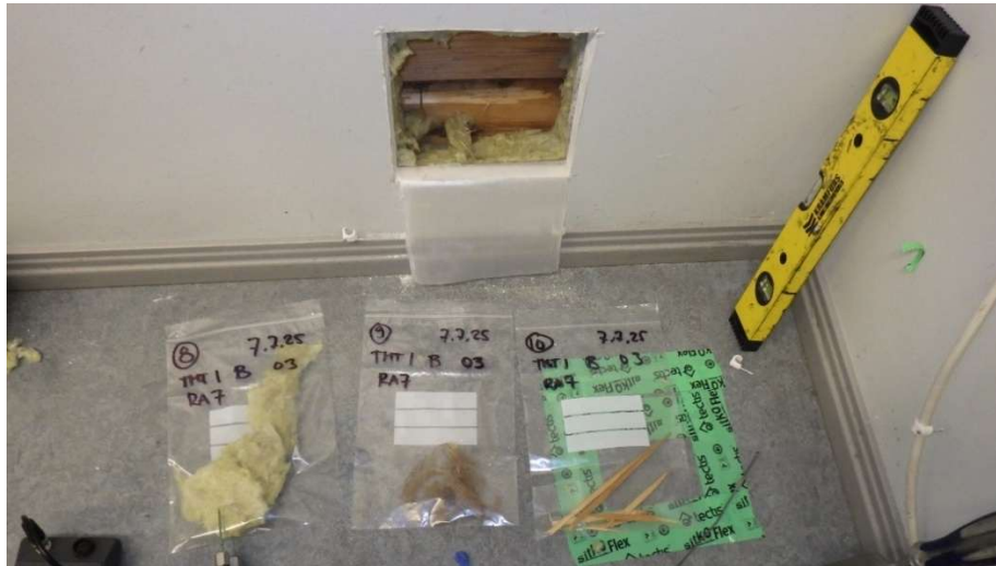
Kuva 19. Esimerkkikuva ulkoseinän rakenneavauksesta ja materiaalinäytteistä (tila 03, RA7). Ulkoseinärakenne oli samankaltainen kaikissa rakenneavauskohdissa.
