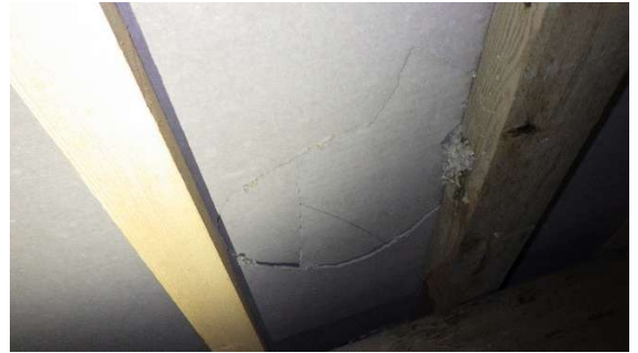
Kuva 12a-b. Vanha aaltopahvipintainen eriste saattaa sisältää asbestia ja rikkoutunut tuulensuojalevy.
