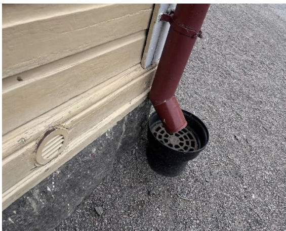
Kuva 7 Sadevedet on johdettu rännikaivoihin.
