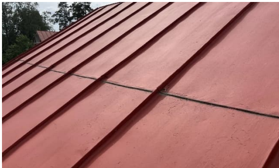
Kuva 62 Peltikatteen pystysaamaa ja lappeen suunnassa kulkevaa hakasaamaa.
