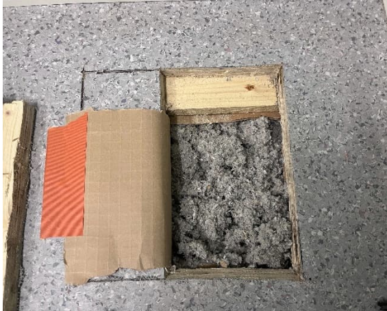
Kuva 16 Rakenneavaus AP1 tehtiin tilaan 04.
