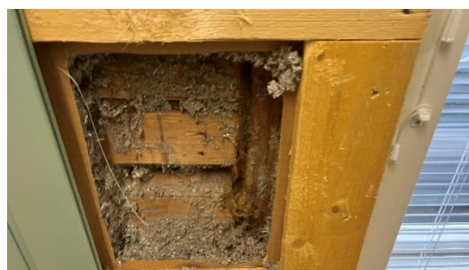
Kuva 39. Ulkoseinän rakenneavaus.
