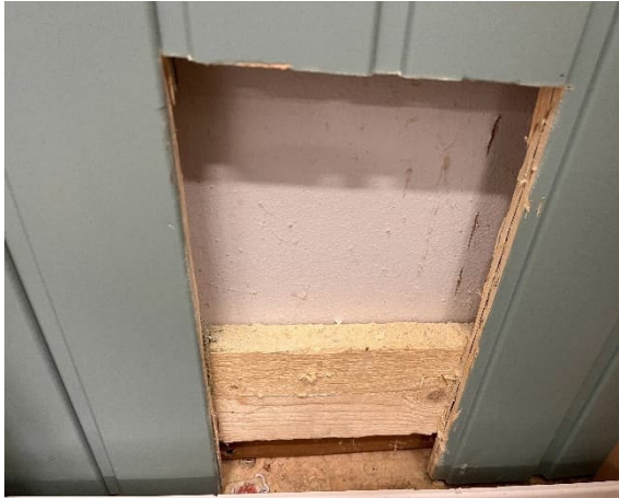
Kuva 52. VS4 tehtiin tilaan 06.
