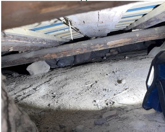
Kuva 24 Ryömintätilaa, etelän puoli.
