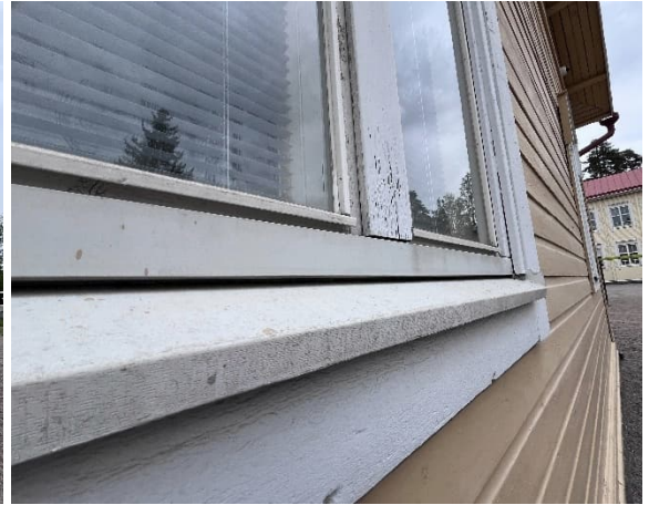
Kuva 31. Ikkunat on uusittu arviolta peruskorjauksen yhteydessä.
