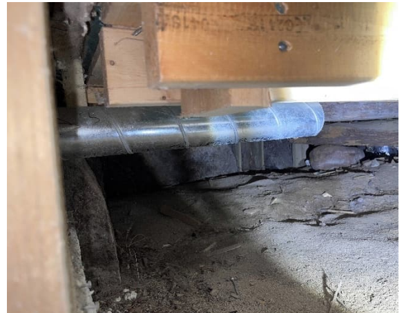
Kuva 25 Ryömintätilan tuuletusta.
