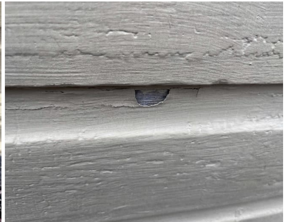
Kuva 33. Maalipinnan lohkeilua.
