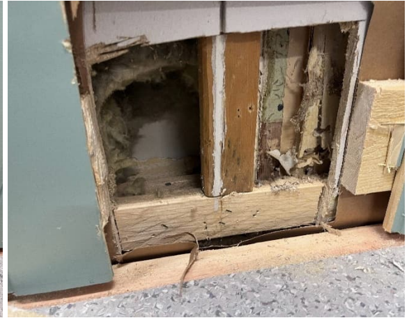
Kuva 43. VS1. Rakenteessa havaittiin puurunko sekä hirsirunko. On mahdollista, että rakenteessa on vanha oviaukko. Rakennetta ei tutkittu pidemmälle.
