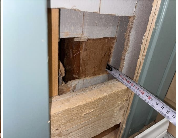
Kuva 53. VS4. Hirsirunko.
