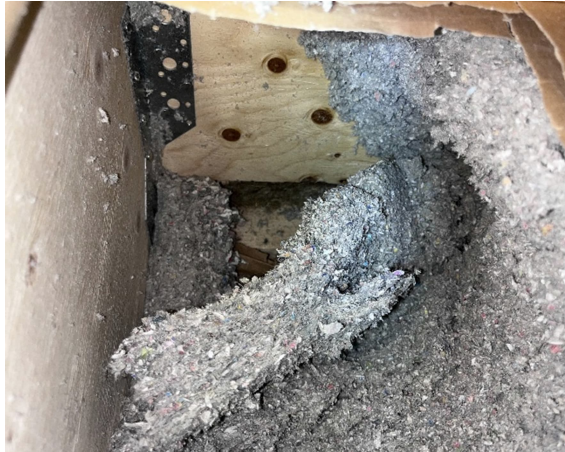
Kuva 18 AP1. Rakenteen alaosassa on selluvillamatto. Ulkoseinän vierustalla on vanerilevytyks.
