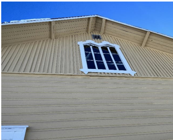
Kuva 66 Yläpohjatilan tuuletusta.
