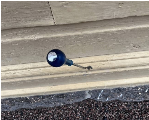
Kuva 32. Puuverhouksen alimman listan alueella havaittiin paikoin pintalaha.
