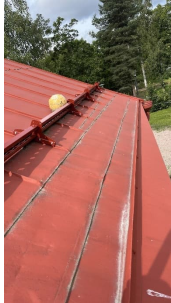
Kuva 65 Lumiestettä ja pystykourua.
