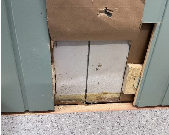
Kuva 42.VS1. Puolipaneelin takana on sisäverhouslevy.
