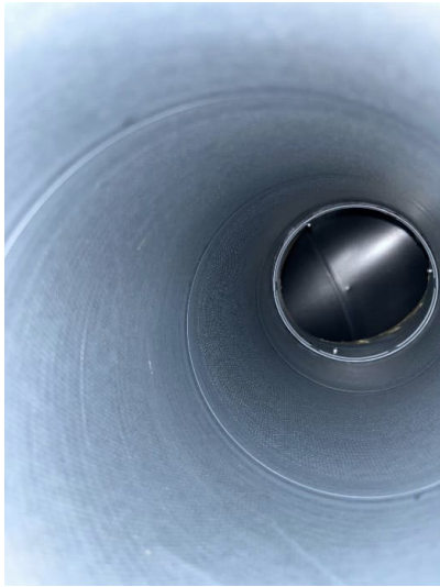
Kuva 77 Tuloilmakanavaa tilassa 05. Kanavassa ei havaittu runsasta pölykertymää.
