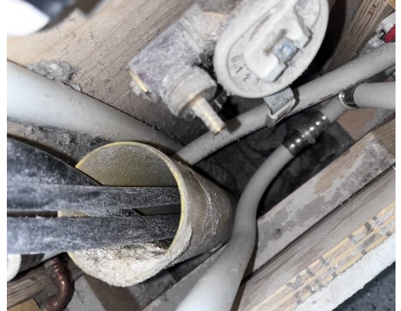
Kuva 55 Läpiviennit auki alapohjaan.
