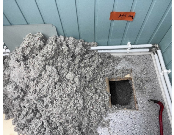
Kuva 17 AP1. Lämmöneristeenä alapohjarakenteessa on selluvilla.
