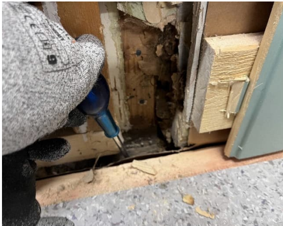
Kuva 44.VS1. Rakenteesta yhteys alapohjan eristetilaan.
