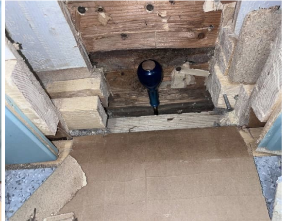
Kuva 49. VS2. Rakenteesta yhteys alapohjan eristetilaan.
