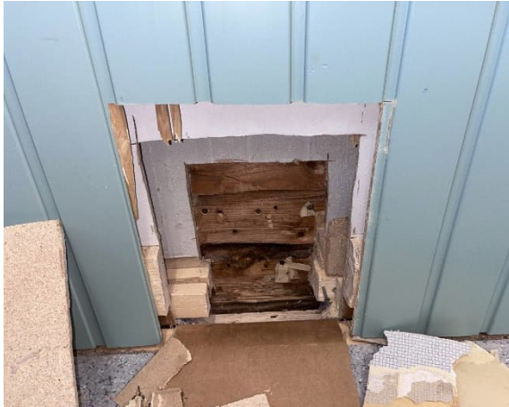
Kuva 48. VS2. Hirsirunko.
