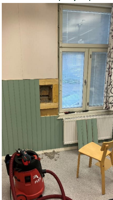
Kuva 38. Ulkoseinän rakenneavaus sisäpuolelta.
