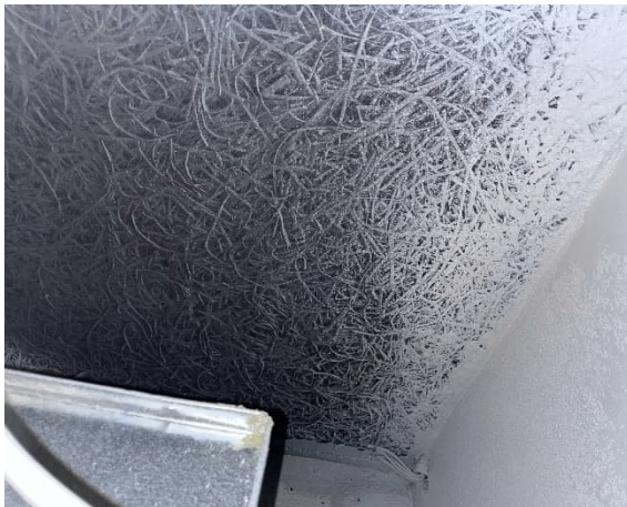
Kuva 90 Tojalevyä luokan K07 sisäkatossa.
