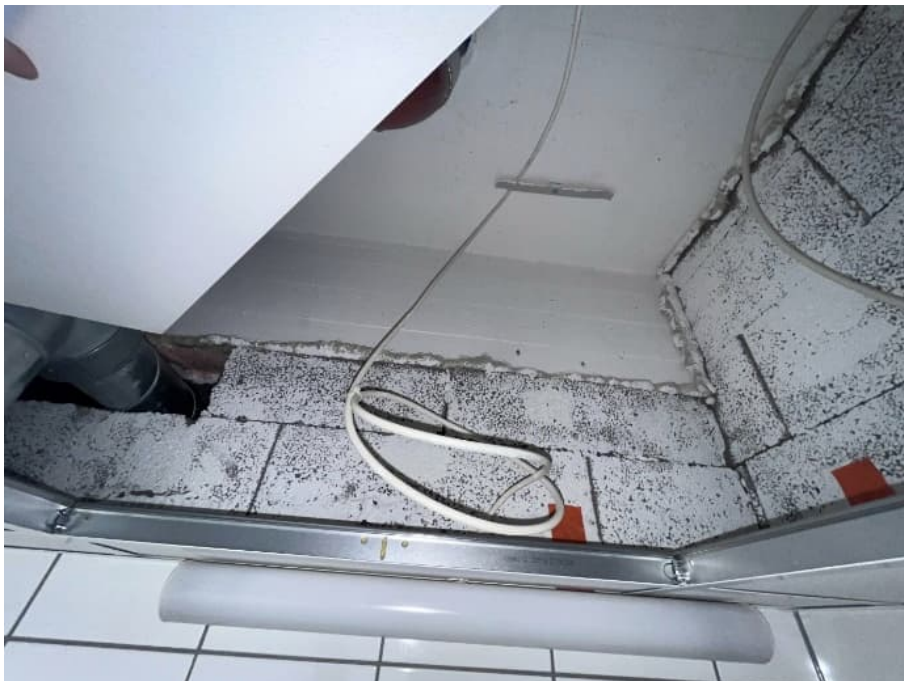
Kuva 74 Keittiössä osa väliseinistä on harkkomuurattuja ja laattapintaisia väliseiniä.
