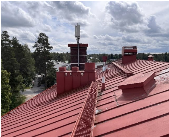
Kuva 113 Korkean osan vesikattoa, yleiskuva.
