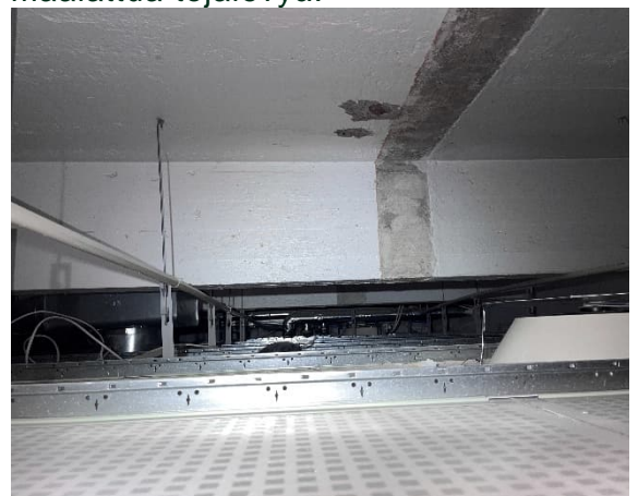
Kuva 99 Aulan K03 alaslaskun yläpuolista tilaa.
