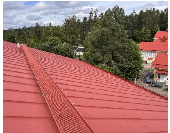
Kuva 114 Korkean osan vesikattoa, yleiskuva. Kulkusillat ja lumisteet kunnossa.
