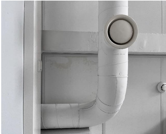
Kuva 106 Akustikkalevyssä havaittiin jo kuivuneita kosteusjälkiä, luokka 311.
