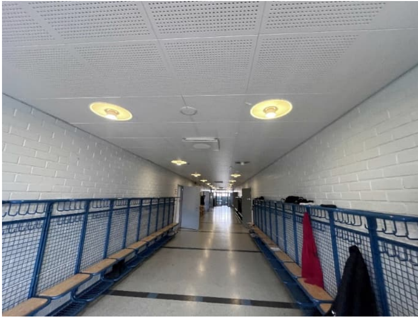
Kuva 71 Luokkatilojen ja käytävän väliset väliseinärakenteet ovat tiilimuurattuja kantavia väliseiniä.
