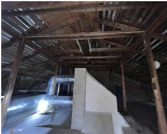
Kuva 137 Korkean osan yläpohjaa.
