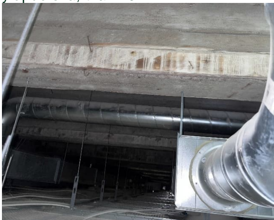
Kuva 80 Muottilautaa käytävän alueella.
