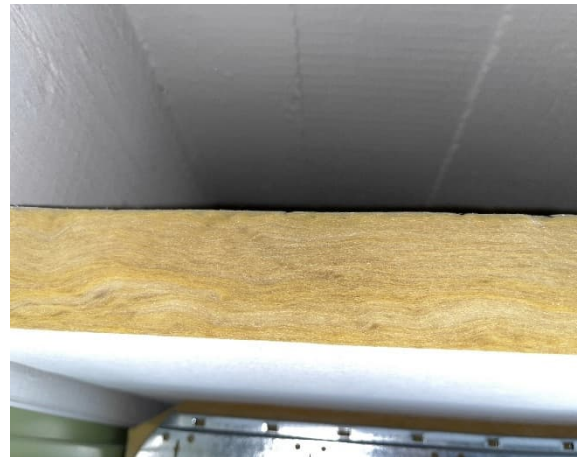
Kuva 91 Akustiikkalevyt ovat osin reunoiltaan pinnoittamattomia. Esimerkkikuva tilasta K18.
