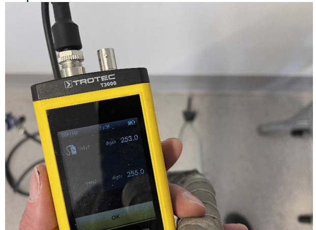
Kuva 149 Runsasta ilmavuotoa havaittiin väliseinä-lattialiittymän kautta.
