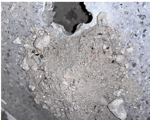
Kuva 63. VP2, tila 108. Sekatäyttö, joka pääosin hiekkaa/kiviainesta ja yksittäisesti puumateriaalia.
