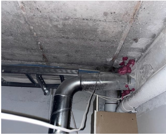
Kuva 88 Alaslaskun yläpuolista tilaa.
