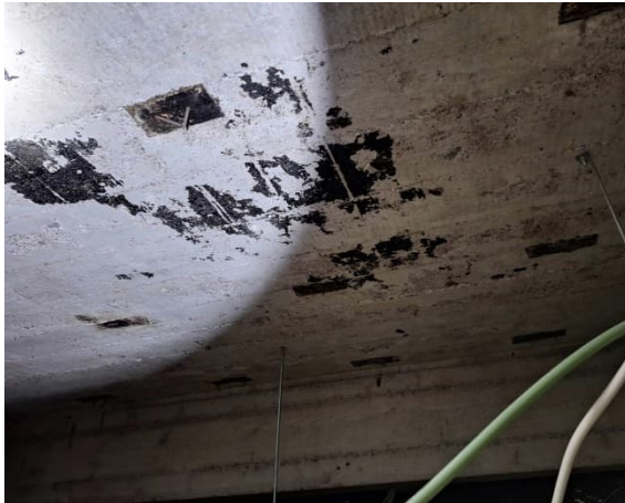
Kuva 78 Pikisivelyä sisäkaton yläpuolella, tila 143.
