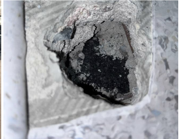
Kuva 66. Välipohjan rakenneavausta tilassa A209.
