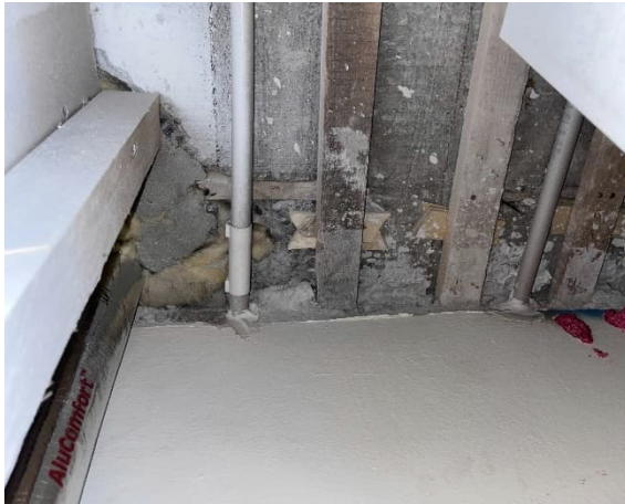
Kuva 94 Sisäkaton yläpuolista tilaa luokassa 106.
