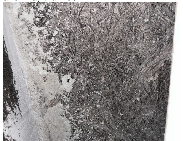
Kuva 105 Tojalevyä suihkutilan katossa (K25-K27).
