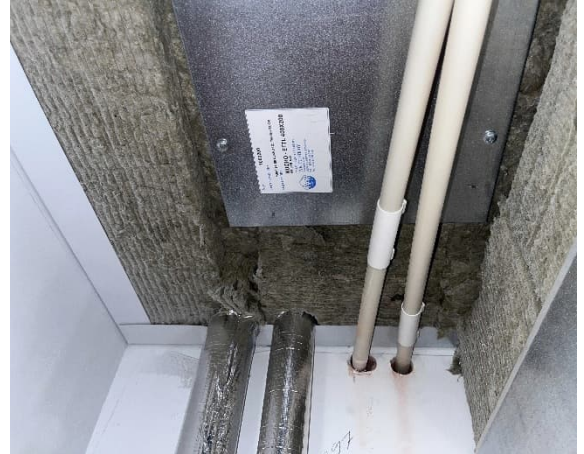
Kuva 83 Tyttöjen WC-tila 223. Avoimia mineraalivillapintoja.
