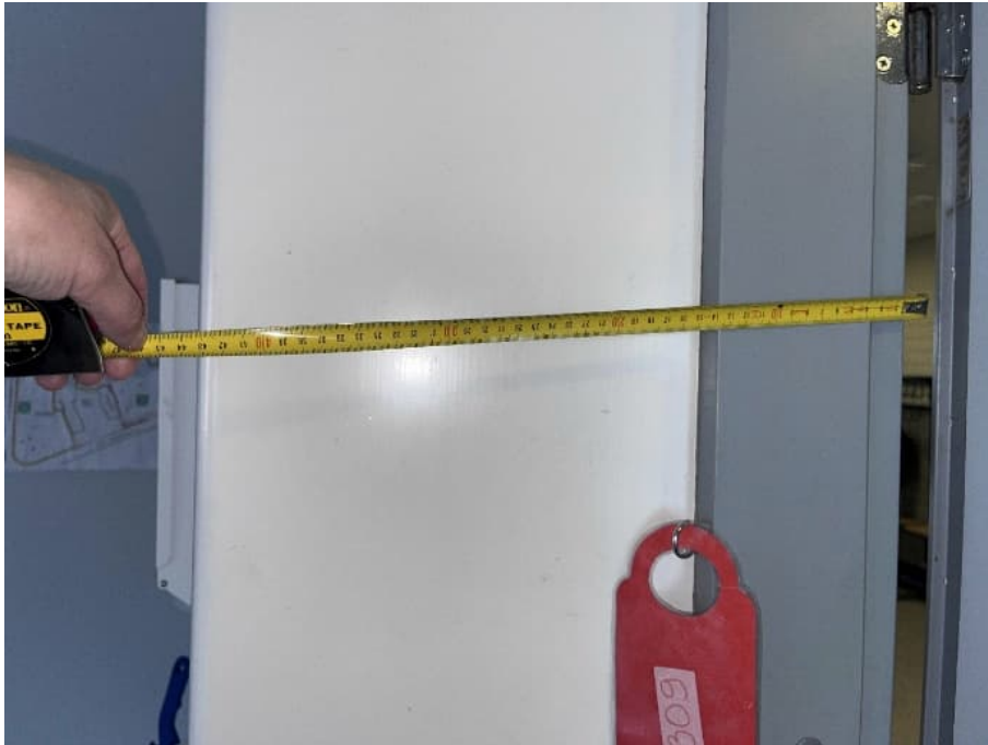
Kuva 73 Luokkatilojen ja käytävän väliseinien paksuus on noin 400-430 mm.
