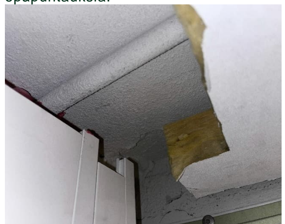
Kuva 87 Avoimia mineraalivillapintoja.
