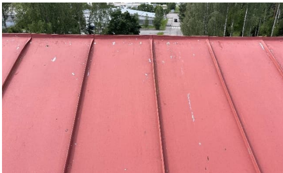
Kuva 115 Korkean osan vesikattoa.
