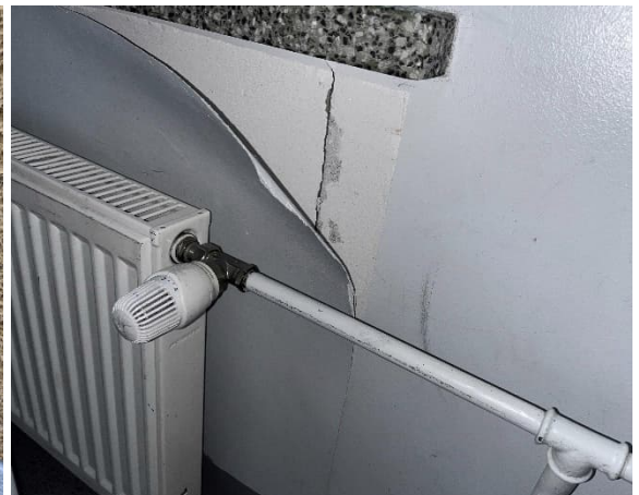
Kuva 48. Ulkoseinien sisäpinnoilla on lasikuitutapetti.
