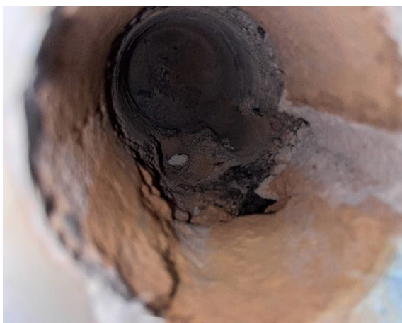
Kuva 49. SOK1, K01. tiilimuurauksen takana havaittiin korkkia ja pikisively.
