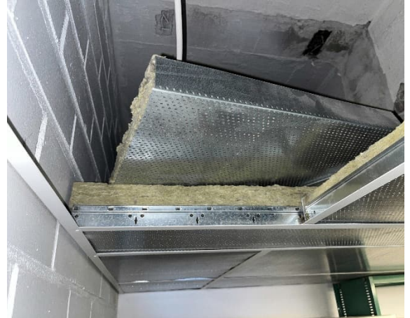
Kuva 101 Sisäkatto mineraalivillalla eristettyä reikälevyä, tila K11.
