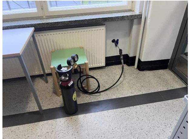
Kuva 157 Merkkiainekaasu laskettiin patterisyvennyksen alueelle ulkoseinän eristetilaan.
