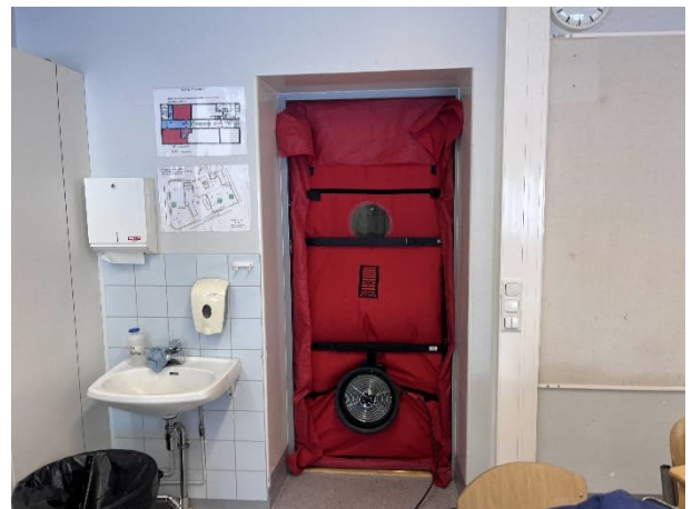
Kuva 147 Tutkittava tila alipaineistettiin ovipuhaltimella.
