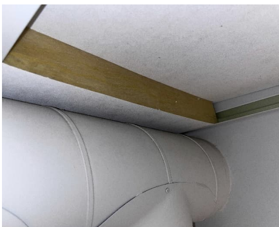
Kuva 86 Avoimia mineraalivillapintoja.
