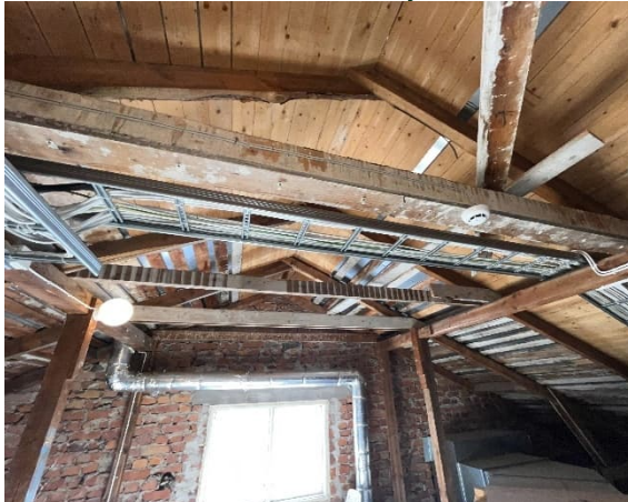
Kuva 131 Matalan osan yläpohjaa. Vesikatteen ruodelaudoituksia on uusittu jollain aikavälillä.
