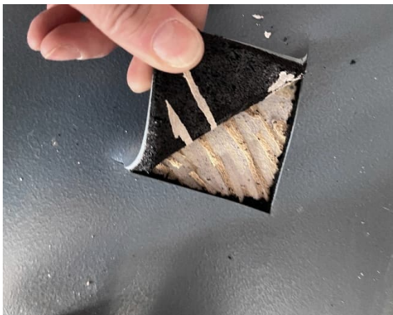
Kuva 67. Liikuntasalin lattiassa on massalattia (kumijoustinkerros alapinnassa).
