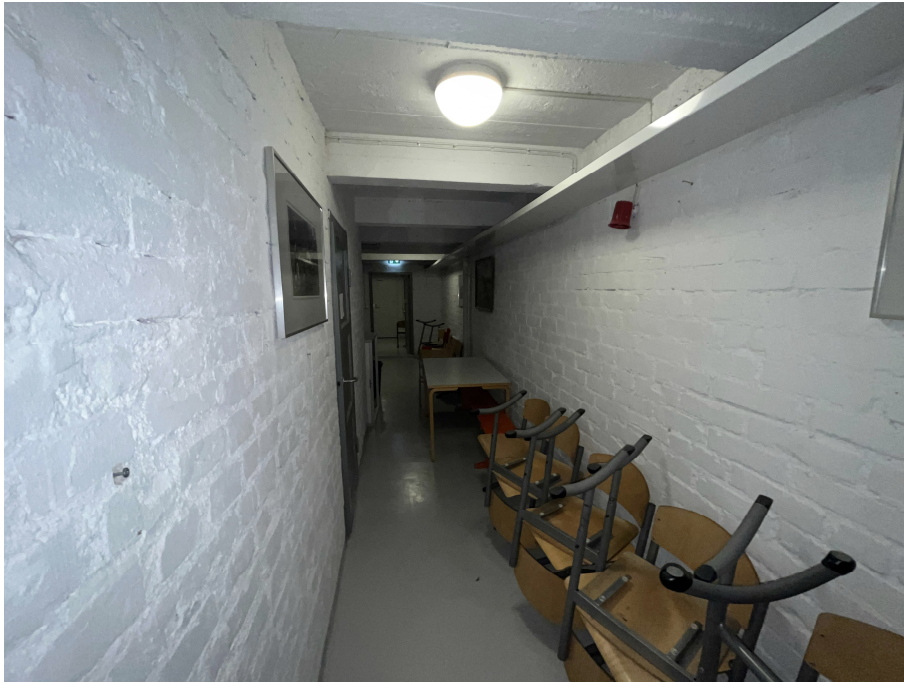
Kuva 75 Matalan osan kellarikerroksen väliseinät on tiilimuurattuja seiniä.
