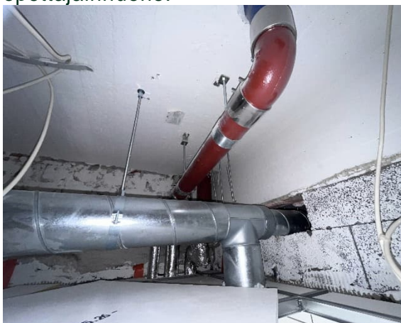
Kuva 98 Alaslaskun yläpuolista tilaa, keittiö.
