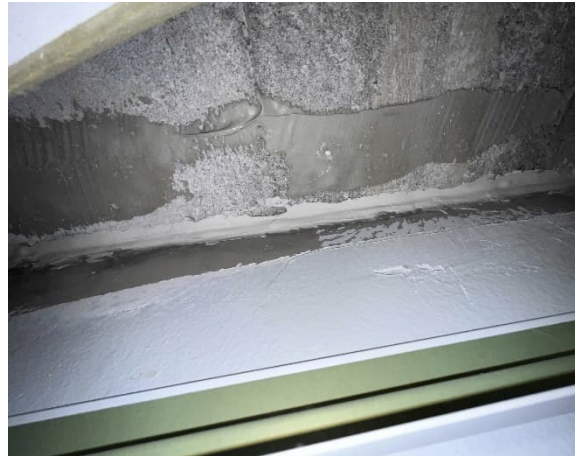
Kuva 107 Koteloinnin yläosaa tiivistetty, luokka 310.
