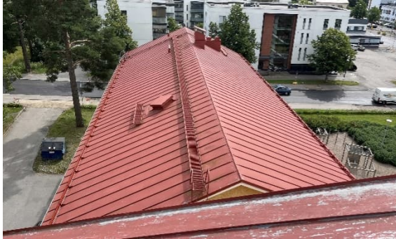
Kuva 123 Matalan osan vesikattoa.
