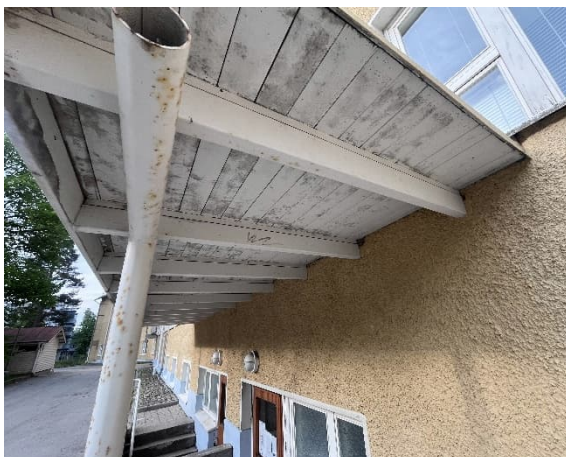
Kuva 21 Sisäpihan puoleista katosta.
