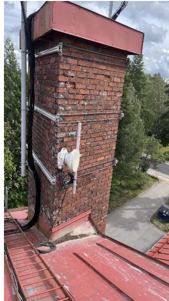
Kuva 120 Savupiipun alimmat tiilet rapautuvat kosteusrasituksesta /lumi kertyy piipun alueelle.
