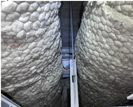
Kuva 84 Miesten WC-tila 218. Avoimia mineraalivillapintoja.
