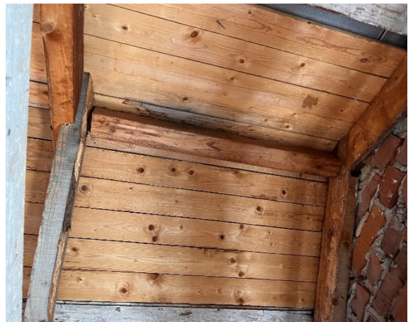
Kuva 128 Harjan umpilaudoitus on uusittu arviolta 2000-luvun alussa.
