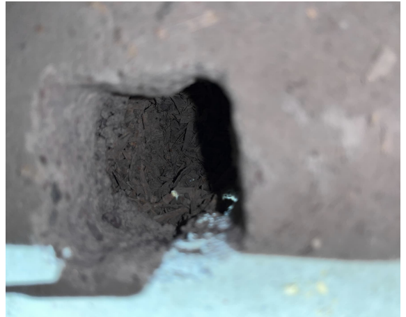
Kuva 142 Yläpohjan rakenneavausta. Rakenteessa on tojalevyä.
