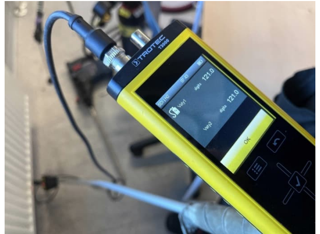
Kuva 151 Merkkiainekaasu laskettiin välipohjan eristetilaan. Ilmavuotoa havaittiin ulkoseinä-välipohjaliittymän kautta.
