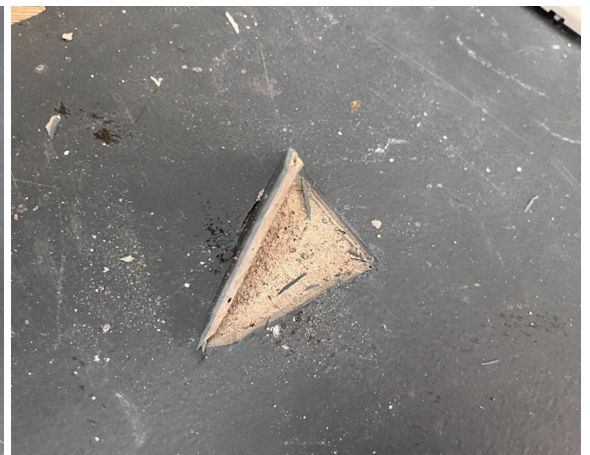
Kuva 68. Liikuntasalin viereisessä varastossa on arviolta polyuretaanipinnoite.
