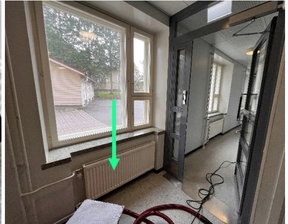
Kuva 52. US4. Patterisyyvennyksen alueella ulkoseinärakenteessa havaittiin korkkieriste.
