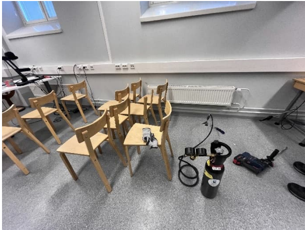
Kuva 156 Merkkiainekaasu laskettiin kanaaliin luokassa K18. Ilmavuotoa kanaalista sisäilmaan ei havaittu.
