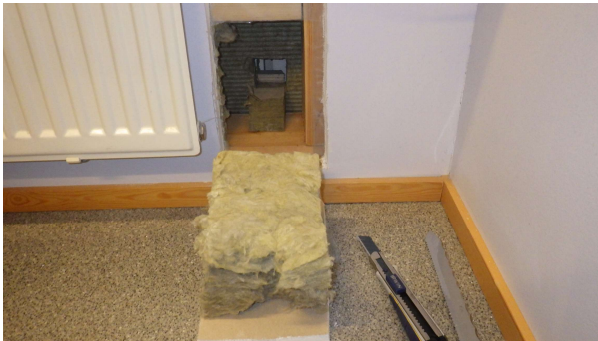
Kuvat 13-14. Ulkoseinärakenne syvyysuunnassa.
