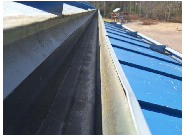
Kuvat 48-49. Yläpohjan höyrynsulku ei ole tiivis, sillä höyrynsulun limityksiä ei ole teipattu. Sadevesikourut olivat tarkastushetkellä puhtaat.
