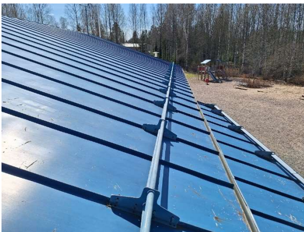
Kuvat 32-33. Yleiskuvaa lumiesteistä. Lumiesteissä on liian suuri ylitys.
