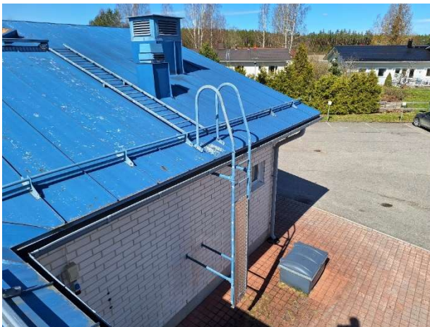
Kuvat 26-27. Vesikatolle kuljetaan seinätikkaita pitkin ja katolla kuljetaan lapetikkaita ja kulkusilloja pitkin.
