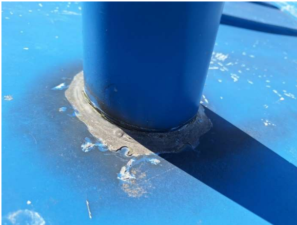
Kuvat 30-31. Tuuletusputken läpiviennin juuren tiivistysmassa on haurastunut, eikä tyvikartion ja putken välissä ole tiivistysmassaa.
