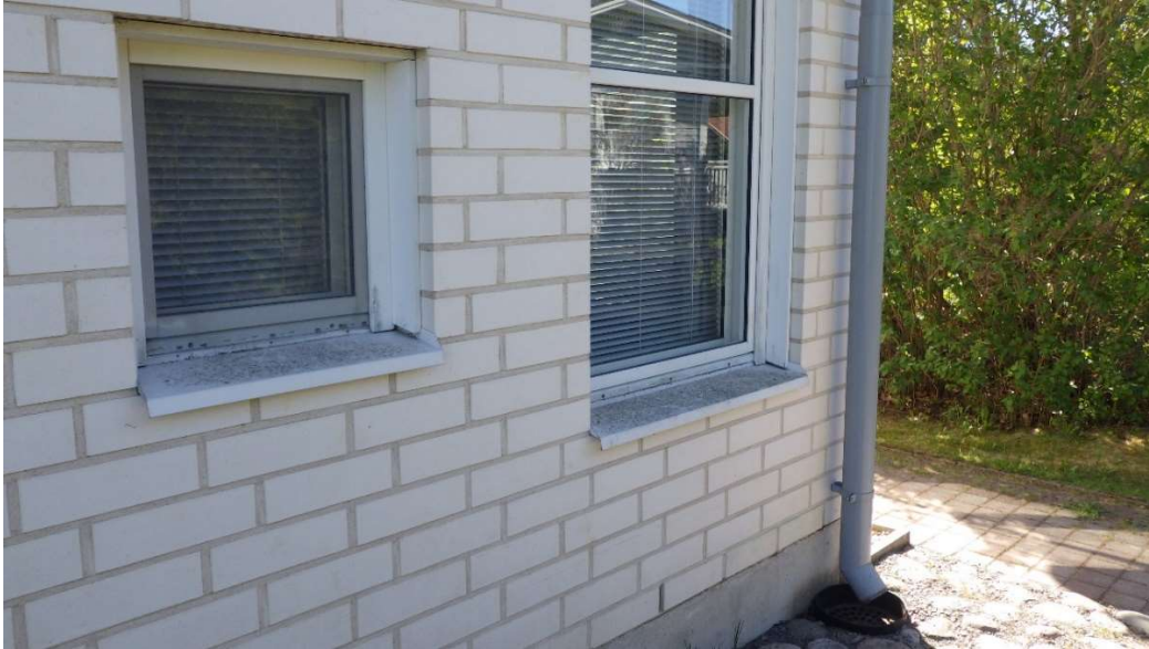
Kuva 6. Ikkunarakenteet ovat pääosin hyvässä kunnossa.
