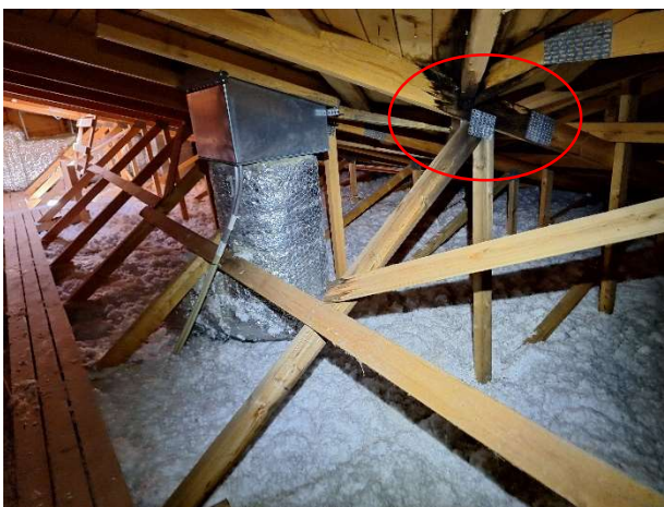
Kuvat 38-39. Kuvia jiirin alapuolelta. Kantavissa rakenteissa on lahovaurioita.
