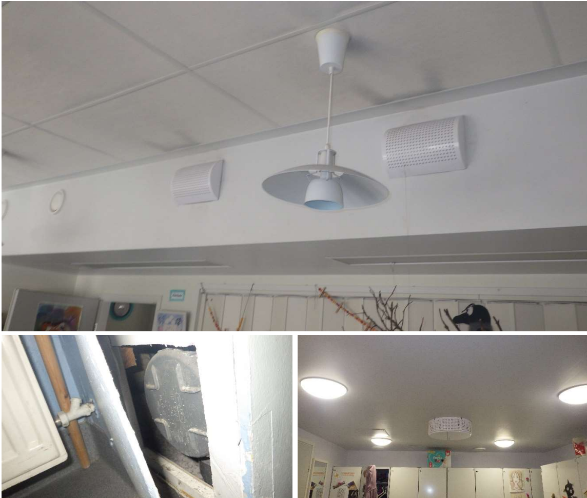
Kuvat 18-20. Alaslaskettuja kattoja ja koteloiteja tutkittiin pistokoemaisesti eri puolilta rakennusta.
