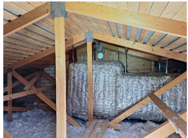
Kuvat 42-43. Viemärin tuuletusputken eristys on puutteellinen. Yläpohja tuulettuu räystäiltä ja päätykolmioiden tuuletusaukoista.
