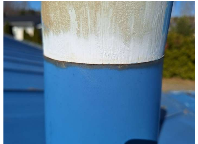
Kuvat 30-31. Tuuletusputken läpiviennin juuren tiivistysmassa on haurastunut, eikä tyvikartion ja putken välissä ole tiivistysmassaa.
