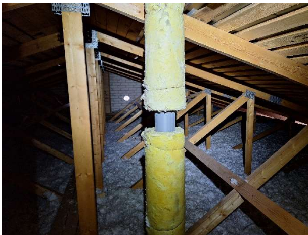
Kuvat 42-43. Viemärin tuuletusputken eristys on puutteellinen. Yläpohja tuulettuu räystäiltä ja päätykolmioiden tuuletusaukoista.
