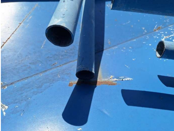
Kuvat 34-35. Lumiesteputki on naarmuttanut katetta ja se on taipunut lumikuormasta. Myös räystäspelti on vaurioitunut.
