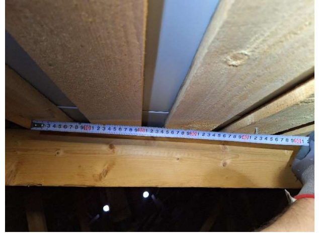
Kuvat 46-47. Yläpohjan palo-osastointi on toteutettu asianmukaisesti ja vesikatteen kiinnitysväli on riittävän tiheä (keskialueilla alle 45 mm).
