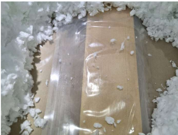
Kuvat 48-49. Yläpohjan höyrynsulku ei ole tiivis, sillä höyrynsulun limityksiä ei ole teipattu. Sadevesikourut olivat tarkastushetkellä puhtaat.
