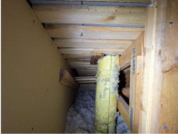
Kuvat 40-41. Vesivuotojälkiä viemärin tuuletusputken läpiviennin (kuvat 29-30) ympärillä.
