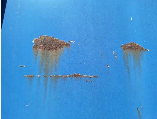
Kuvat 28-29. Vesikatteessa on runsaasti pinnoite- ja ruostevaurioita. Viemärin tuuletusputken taakse kertyy suuri lumikuorma ja se on suositeltavaa suojata lumiesteellä.
