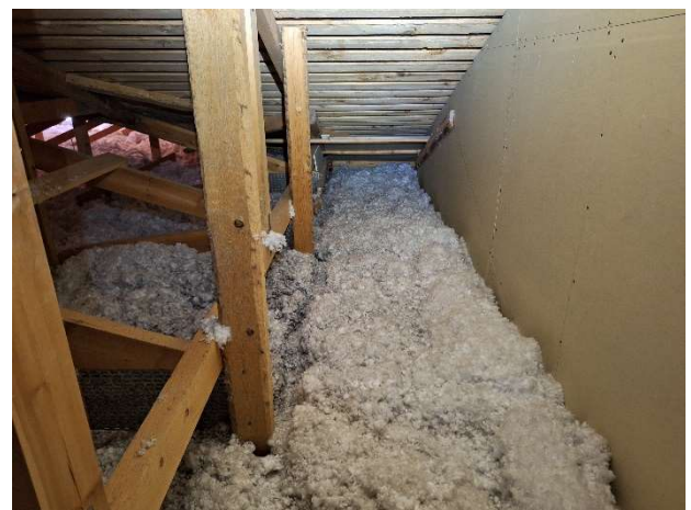
Kuvat 44-45. Yleiskuvaa yläpohjasta. Lämmöneristekerroksen pinnalla havaittiin viitteitä jyrssiöistä.
