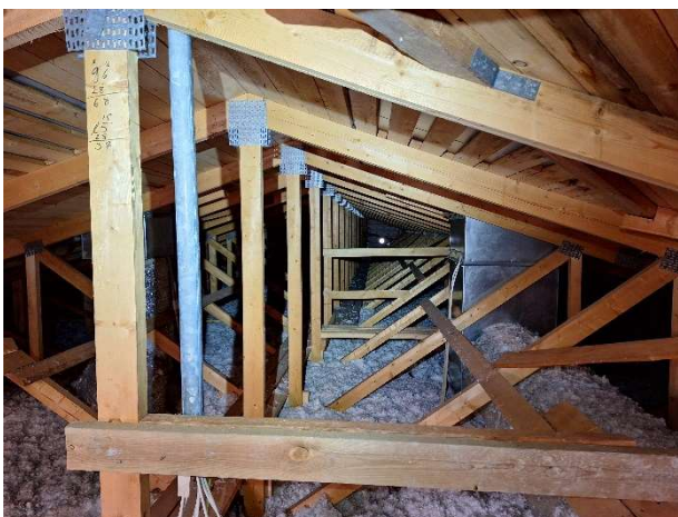
Kuvat 44-45. Yleiskuvaa yläpohjasta. Lämmöneristekerroksen pinnalla havaittiin viitteitä jyrssiöistä.
