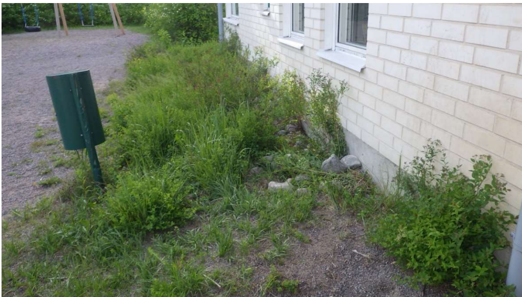
Kuva 5. Rakennuksen vieressä on paikoin humusmaata ja kasvillisuutta.
