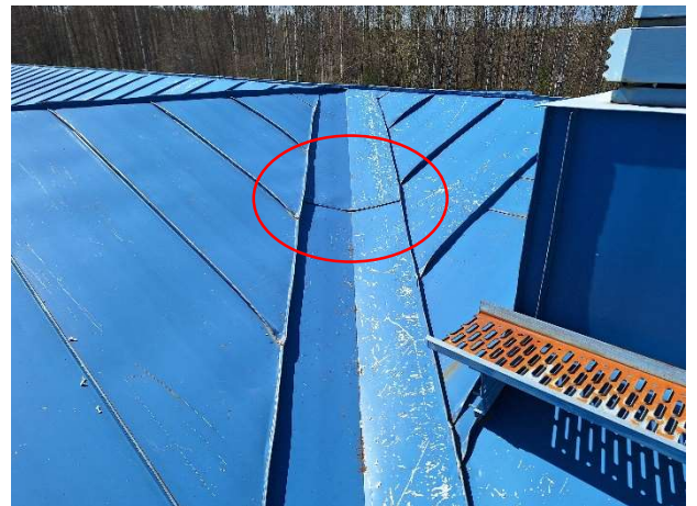
Kuvat 36-37. Räystäslaudoissa on merkkejä kosteusvaurioista ja jiirin saumat vuotavat.
