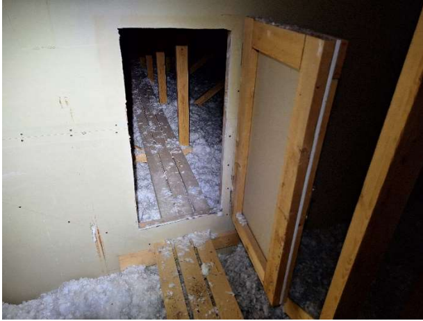
Kuvat 46-47. Yläpohjan palo-osastointi on toteutettu asianmukaisesti ja vesikatteen kiinnitysväli on riittävän tiheä (keskialueilla alle 45 mm).
