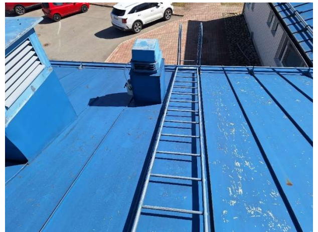
Kuvat 26-27. Vesikatolle kuljetaan seinätikkaita pitkin ja katolla kuljetaan lapetikkaita ja kulkusilloja pitkin.
