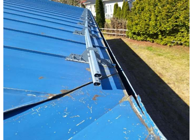
Kuvat 34-35. Lumiesteputki on naarmuttanut katetta ja se on taipunut lumikuormasta. Myös räystäspelti on vaurioitunut.
