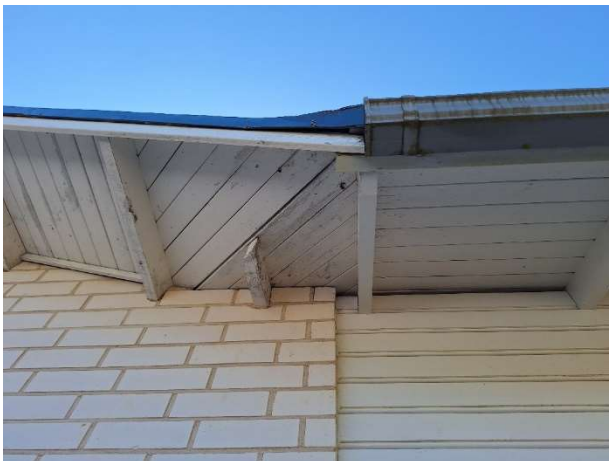
Kuvat 36-37. Räystäslaudoissa on merkkejä kosteusvaurioista ja jiirin saumat vuotavat.
