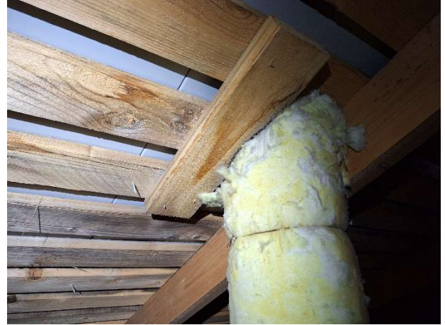
Kuvat 40-41. Vesivuotojälkiä viemärin tuuletusputken läpiviennin (kuvat 29-30) ympärillä.
