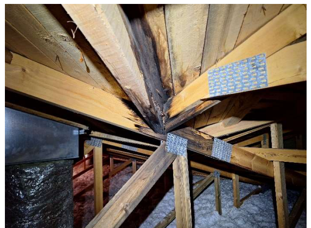
Kuvat 38-39. Kuvia jiirin alapuolelta. Kantavissa rakenteissa on lahovaurioita.
