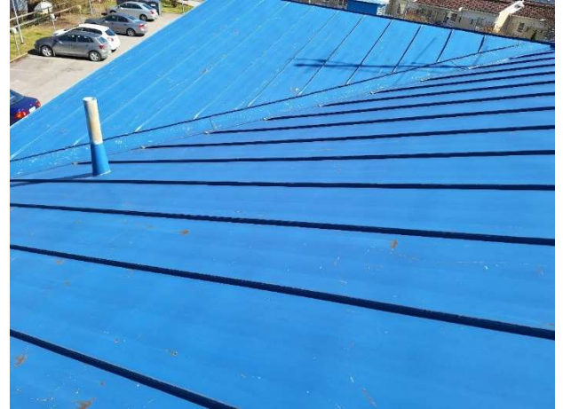
Kuvat 28-29. Vesikatteessa on runsaasti pinnoite- ja ruostevaurioita. Viemärin tuuletusputken taakse kertyy suuri lumikuorma ja se on suositeltavaa suojata lumiesteellä.
