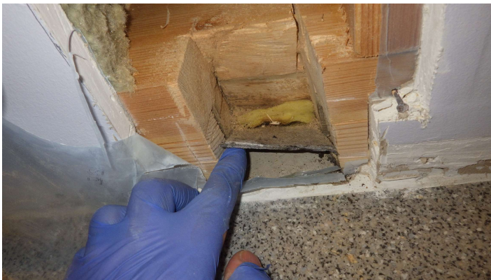
Kuva 15. Ulkoseinärakenne alapohjan yläpuolella.
