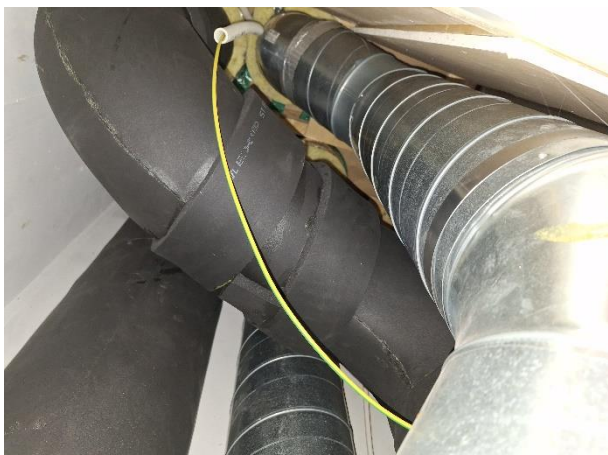
Raitis- ja jäteilmakanavat eristetty ok.
