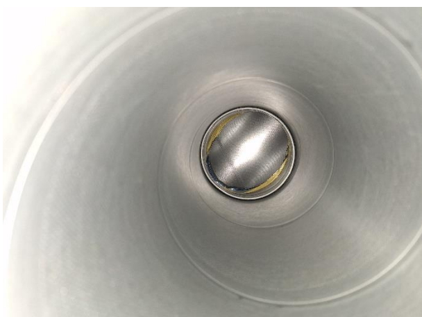
Tuloilmakanavaa. Kanava puhdas.
