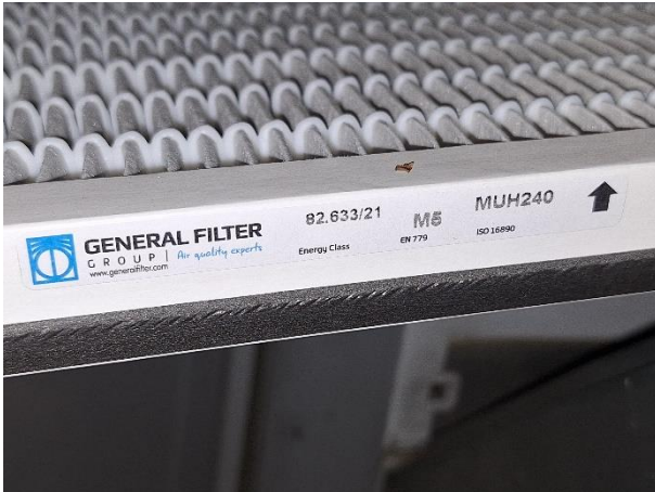
Ulkoilman hienosuodatin TK04.
