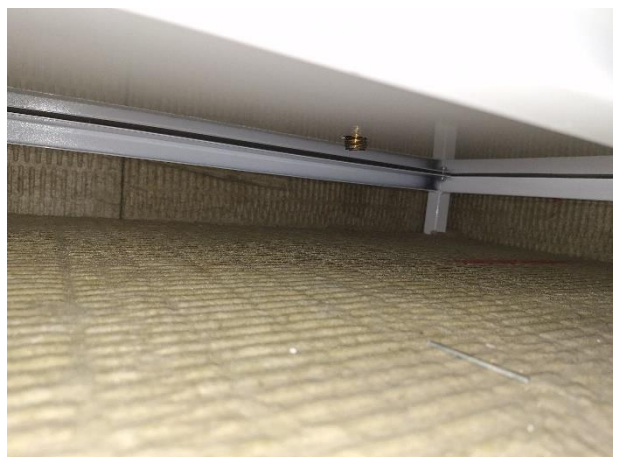
Ilmanvaihtokoneen alla ja sivuilla eristysvillaa.
