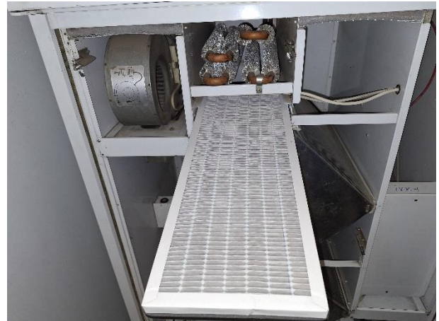
Ulkoilman hienosuodatin TK04.
