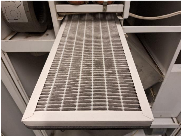
Ulkoilman hienosuodatin TK06.
