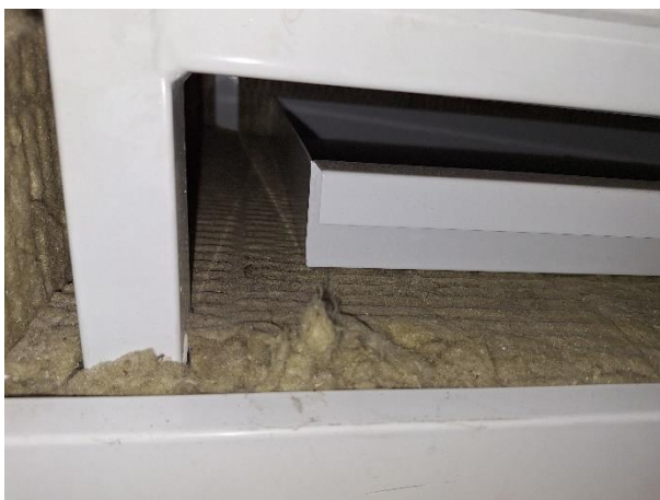
Ilmanvaihtokoneen alla ja sivuilla eristysvillaa.
