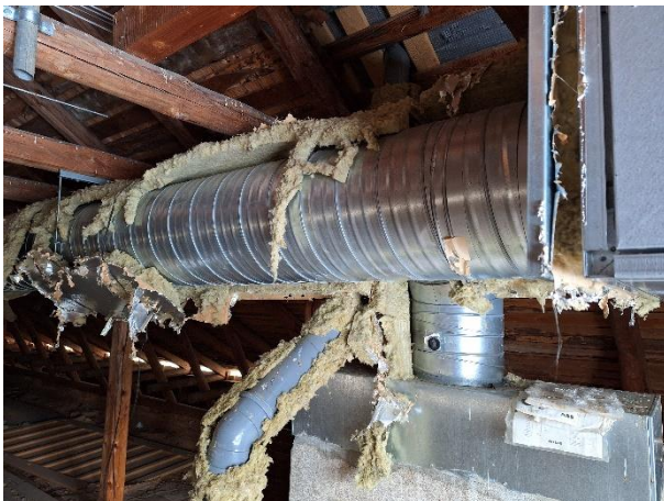
Koje kanavoitu hormien peltisiin kokoojalaatikkoihin.
