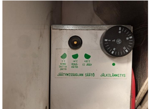
TK07 jäätymisuoja ja jälkilämmitysvastuksen ohjaus.
