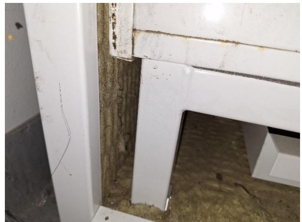
Ilmanvaihtokoneen alla ja sivuilla eristysvillaa.
