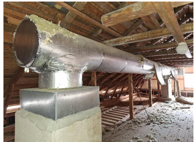
Koje kanavoitu hormien peltisiin kokoojalaatikkoihin.
