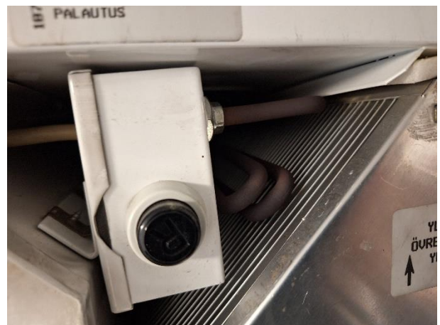
Kojeen jälkilämmitysvastus 0,5 kW.
