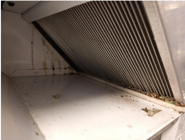
Kammio tulisi imuroida hyönteisistä.
