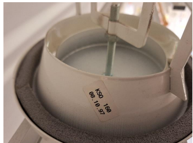
Poistoilmaventtiili mallia KSO-160.
