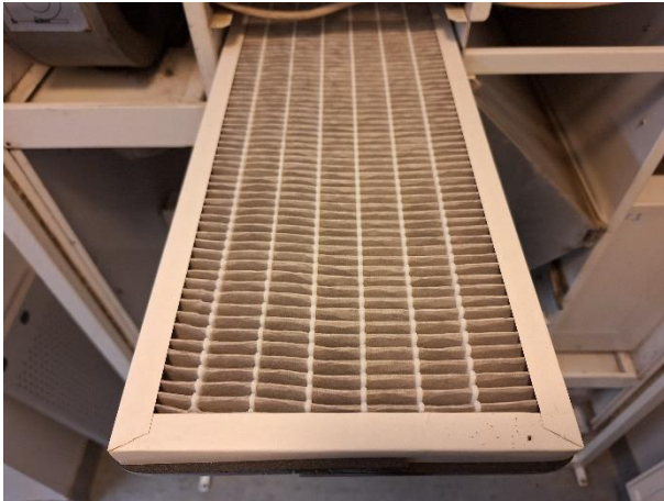
Ulkoilman hienosuodatin TK03.
