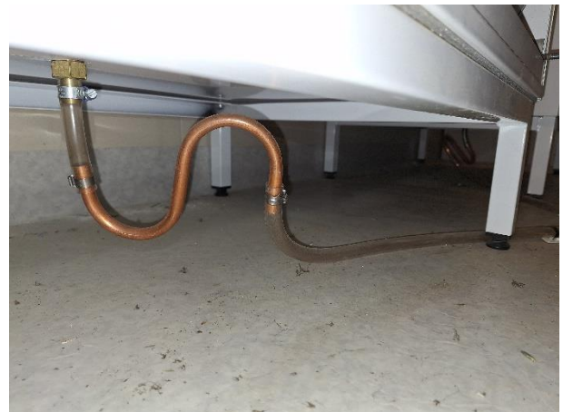
Kondenssivedenpoiston vesilukko.
