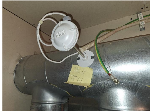
Tuloilmalämpötilan anturi.
