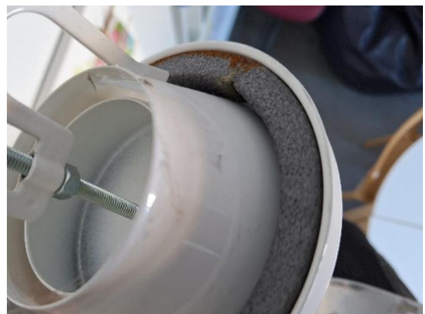
Poistoilmaventtiili mallia KSO-160.
