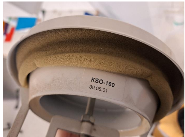
Luokan poistoilmaventtiili mallia KSO-160.
