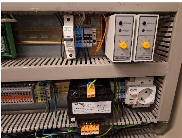
Jäätyminenestotermostaatteja TK-1 ja TK-2.
