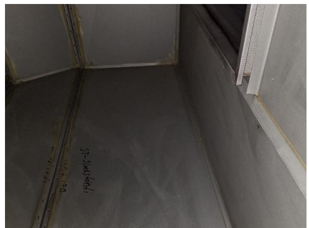
Näkymä tuloilmakammioon, TK/PK-1.
