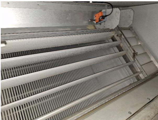
LTO-kuution pellistöä (TK/PK-2).
