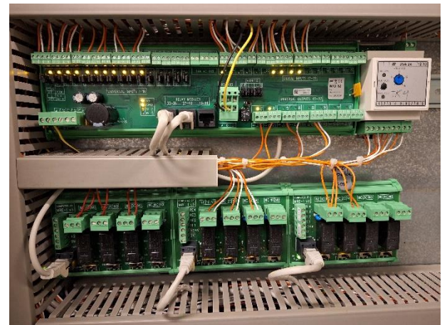
Oikealla jäätyminenestotermostaatti TK-4.
