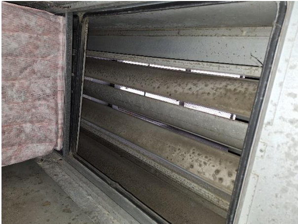
Raitisilmapelti ei mennyt kiinni (TK/PK-2).
