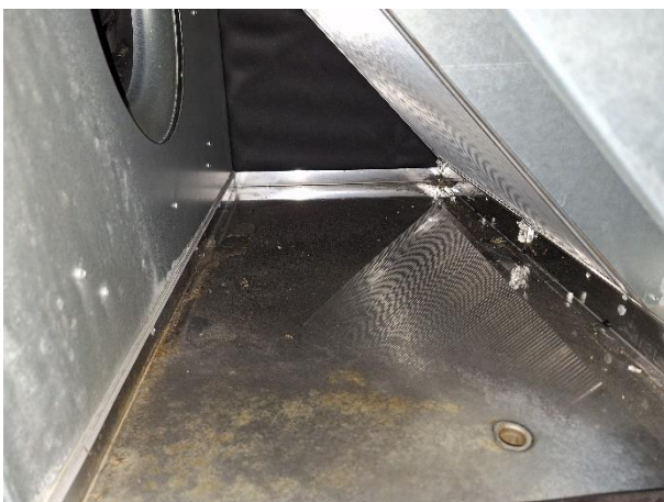
LTO-kondenssivesiviemärintä TK/PK-4.
