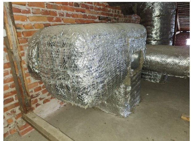
Koulusiiven ullakolla olevia kanavaeristyskiä.
