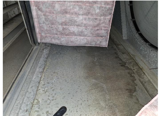
Tuloilmasuodatinkammion sulamisvesijälkiä.
