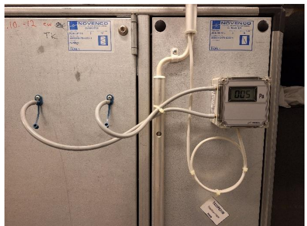
Tuloilmasuodattimien paine-erolähetin (TK/PK-1).
