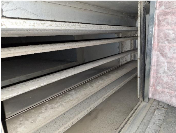
Raitisilmapelti ei mennyt kiinni (TK/PK-3).
