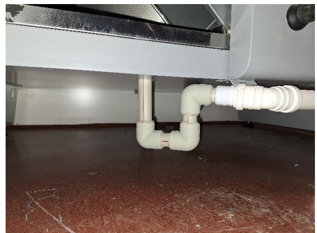
LTO-kondenssivesiviemärintä TK/PK-4.
