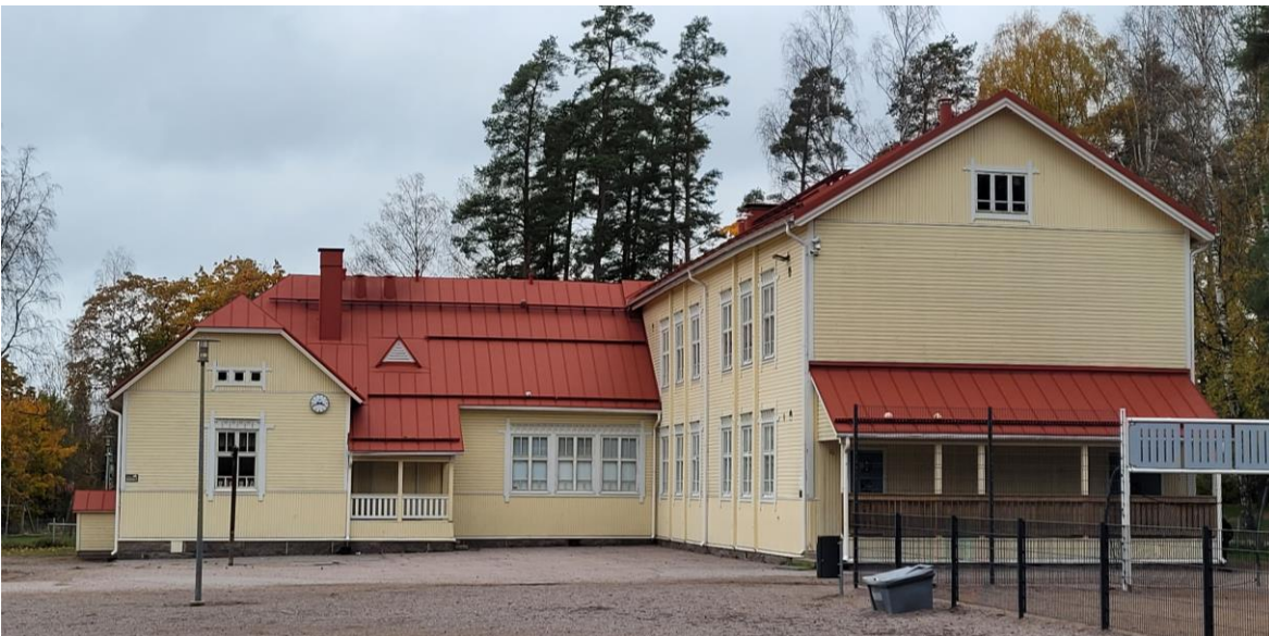
Kuva 43. Rajamäen koulun vanhempi koulurakennus.
