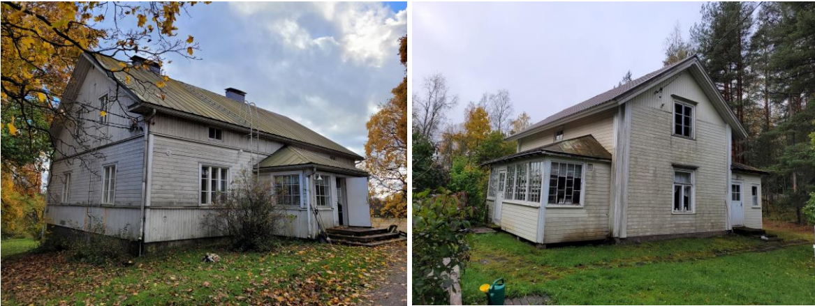
Kuva 33. Asuinrakentamista 1900-luvun alusta.
