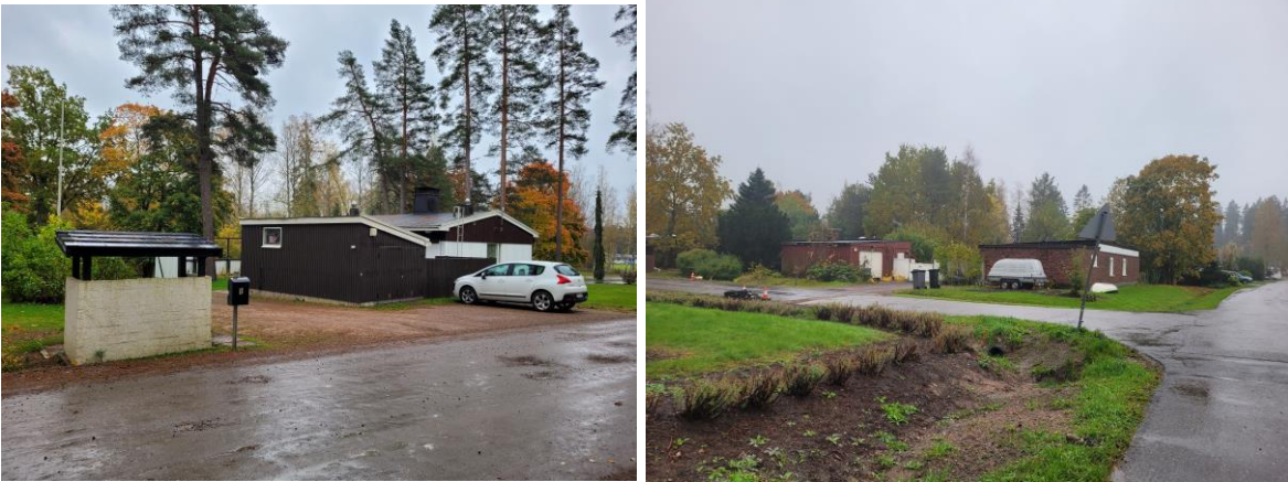
Kuva 42. Autotallit ovat usein pienikokoisia ja sijaitsevat erillisessä rakennuksessa.
