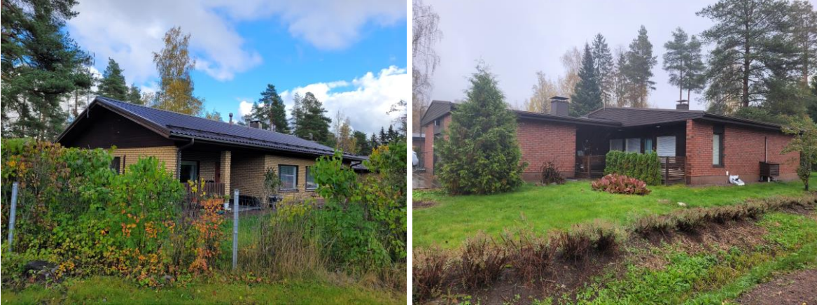
Kuva 38. 1970–1980-lukujen tiilirakenteisia asuintaloja.
