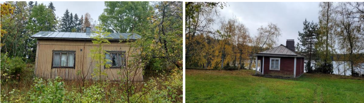
Kuva 39. Pihossa olevat saunarakennukset ovat usein pieniä ja puurakenteisia.
