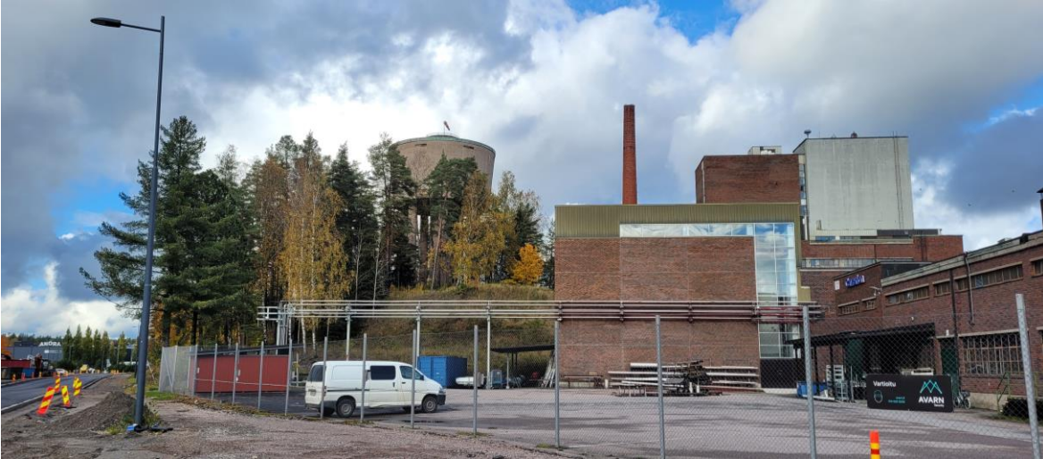
Kuva 56. Rajamäen vanhat tehdasrakennukset.
