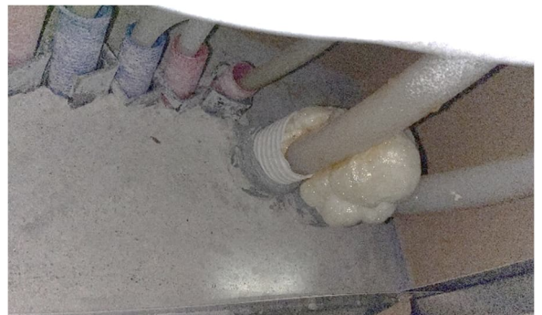
Kuva 14 Läpivientejä tiivistetty uretaanivaahdolla varastotilassa.
