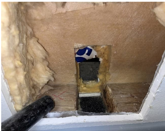
Kuva 68 US 13. Rakenneavaus tehtiin ulkonurkan alaosaan.
