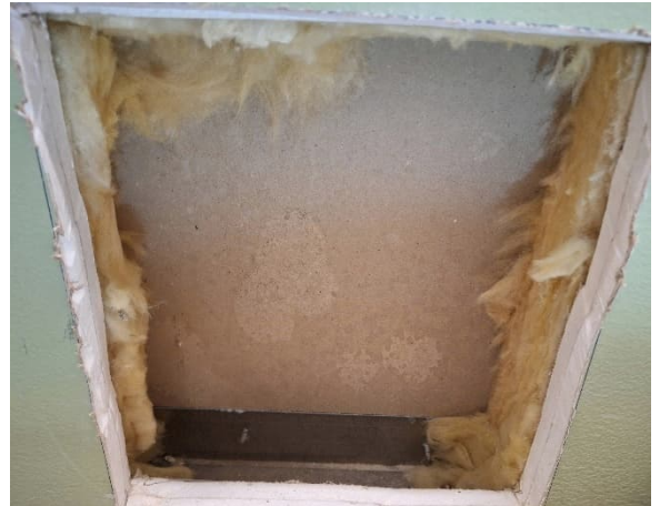
Kuva 77 Yleiskuva rakenteen sisältä [VS2], keittiön vastainen väliseinärakenne ruokalan puolelta kuvattuna.
