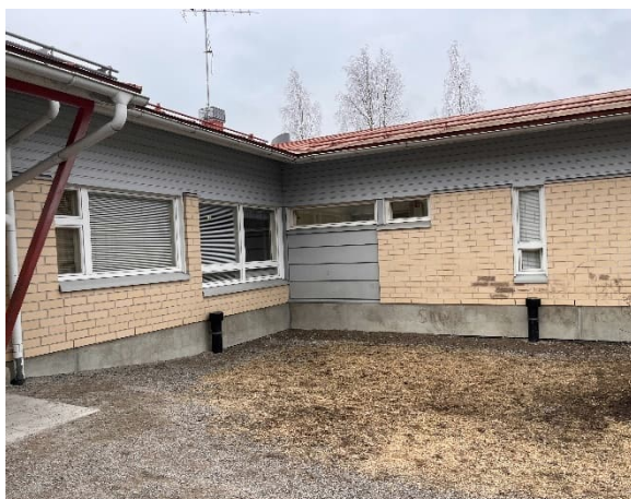
Kuva 41 Märkätilojen ulkoseinät ovat peltielementtiä.
