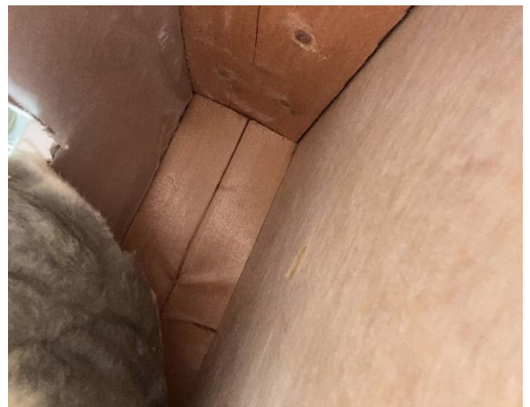
Kuva 67 US11. Ikkunan alapuolissa puurakenteissa ei havaittu kosteusjälkiä. Villoissa havaittiin tummentumaa.
