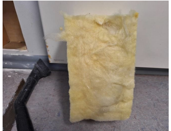
Kuva 51 US2. Ulkoseinän lämmöneristettä.
