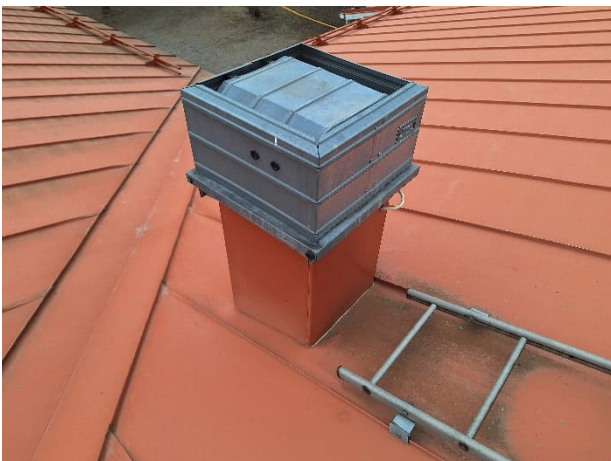
Kuva 89. Viemärin tuuletusputki.
