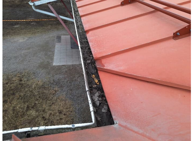
Kuva 94. Sadevesikourujen sisätaitteissa havaittiin vuotoja.
