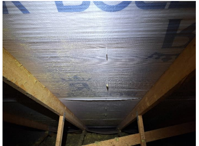
Kuva 96. Vesikaton klammereiden naulat tulevat aluskatteesta läpi.
