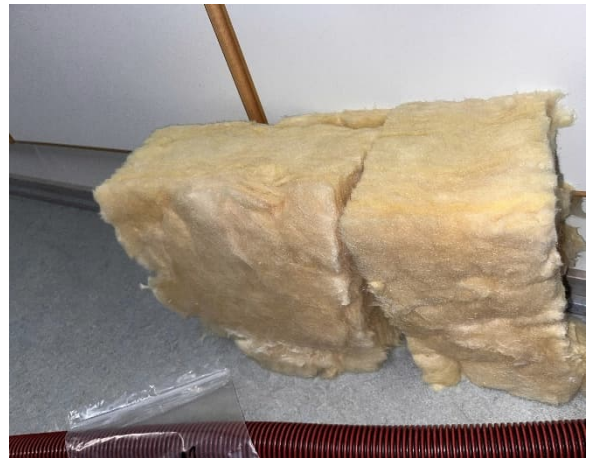
Kuva 61 US11. Ulkoseinärakenteen lämmöneristeissä ei havaittu tummentumaa.
