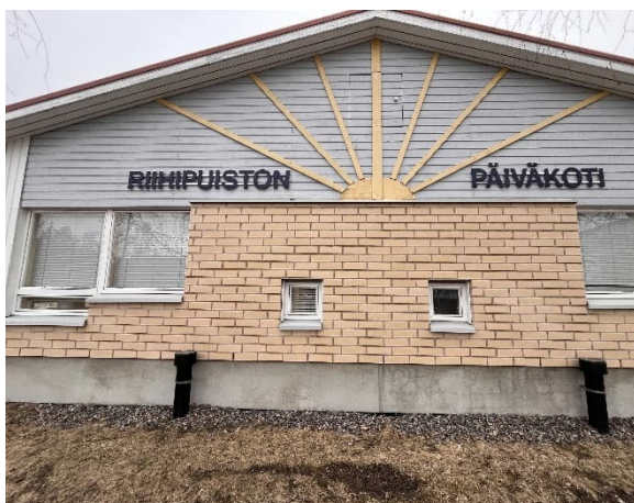
Kuva 37 Ulkoseinää. Rakennuksen päätyjen yläosat on puuverhoiltu.
