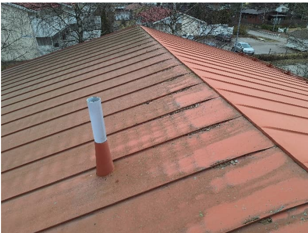
Kuva 89. Viemärin tuuletusputki.
