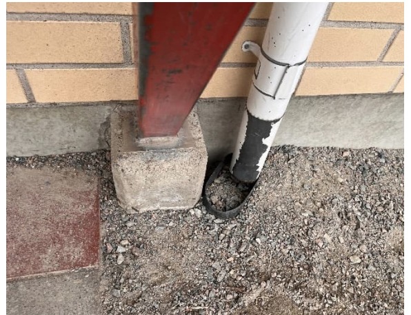
Kuva 20 Rakennuksen vierustaa ja sadevesien ohjausta.
