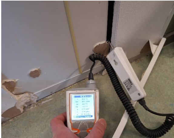
Kuva 76 Yleiskuva [VS1], ruokalan ja kylmiön välinen väliseinärakenne.
