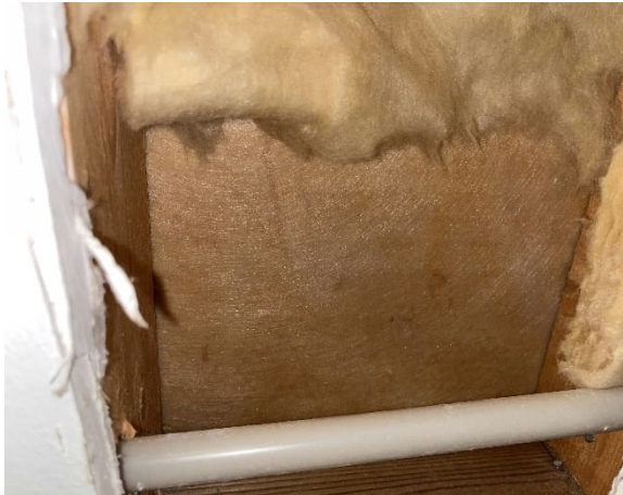
Kuva 70 US 14. Rakenteessa kulkee putkitettu sähköjohto.
