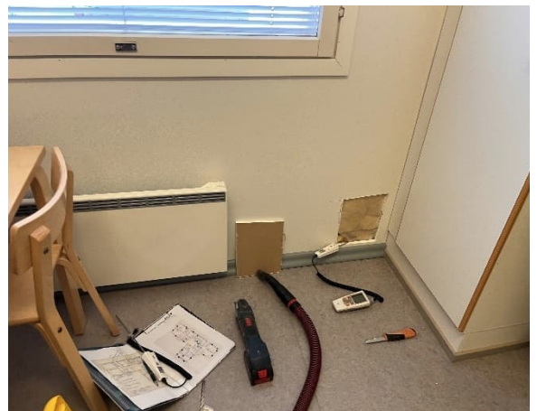
Kuva 69 US14. Rakenneavaus tehtiin ulkoseinän alaosaan.
