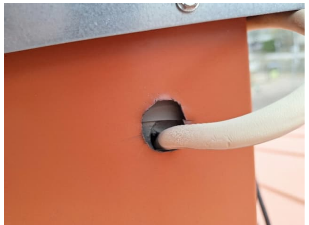
Kuva 90. Tuuletusputken ja tyvikartion liitoksessa ei ole tiivistysmassaa.
