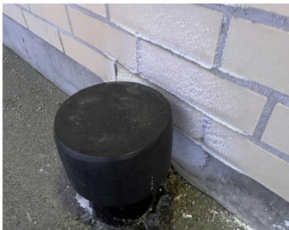
Kuva 5 Ryömintätilan tuuletusputkea.
