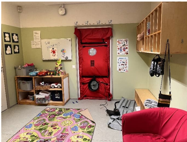
Kuva 100 Tutkittavat tilat alipaineistettiin ovipuhaltimen avulla.
