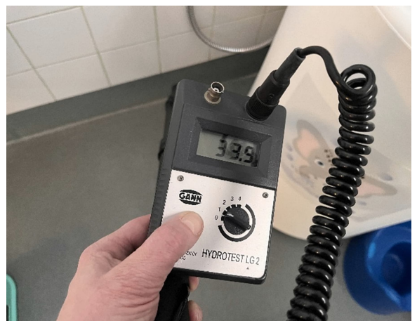
Kuva 81 [VS4] Poikkeavia pintakosteusarvoja ei havaittu väliseinän alaosassa.
