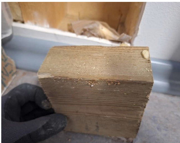
Kuva 52 US2. Alaohjauspuu oli aistinvaraisesti arvioituna hyväkuntoinen.
