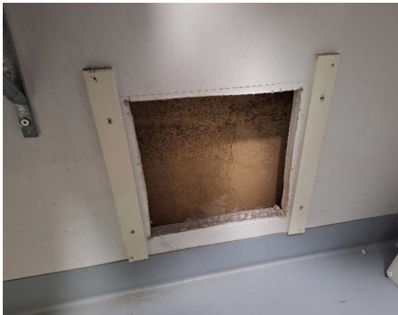
Kuva 78 Siivouskomeron ja keittiön väliseinäavaus [VS3].
