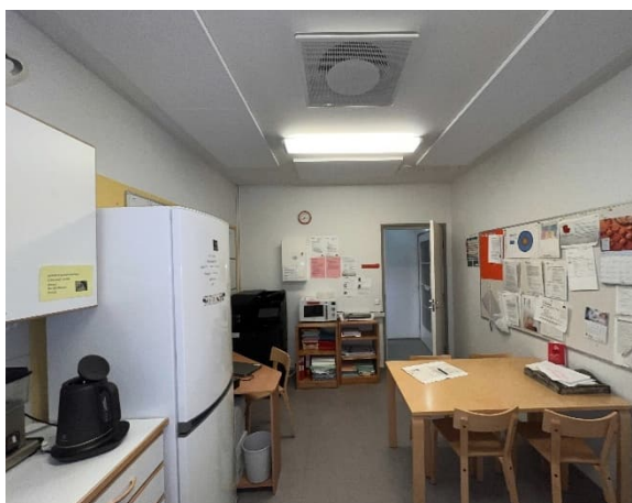
Kuva 84 Henkilökunnan tilan sisäkatto.
