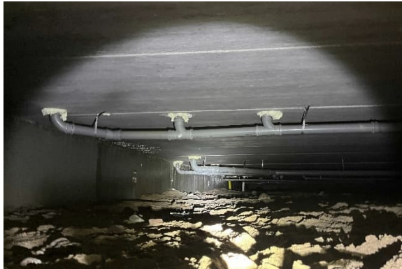
Kuva 29 Ryömintätilan läpivientejä on tiivistetty uretaanivaahdolla.
