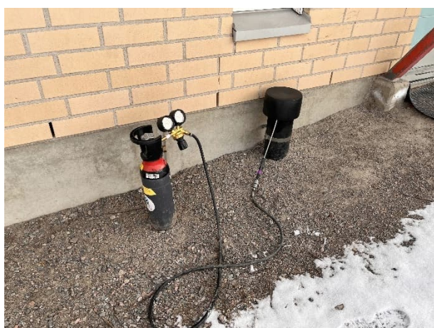
Kuva 104 Merkkiaine laskettiin ryömintätilaan myös tuuletuspaalujen kautta.
