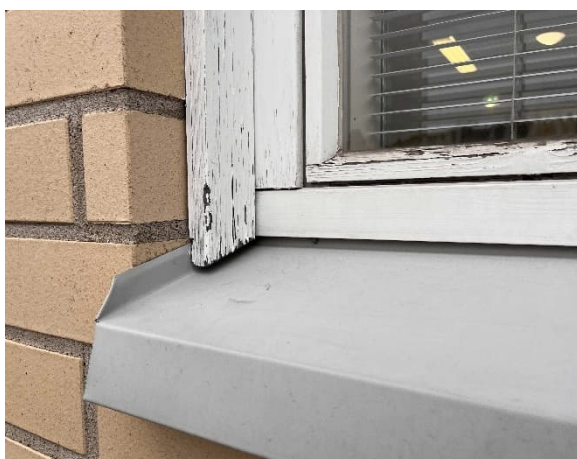
Kuva 39 Ikkunapellitysten kallistukset ovat riittävät.
