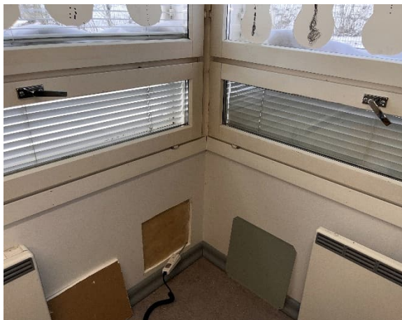
Kuva 62 US 12. Rakenneavaus tehtiin ulkonurkan alaosaan.
