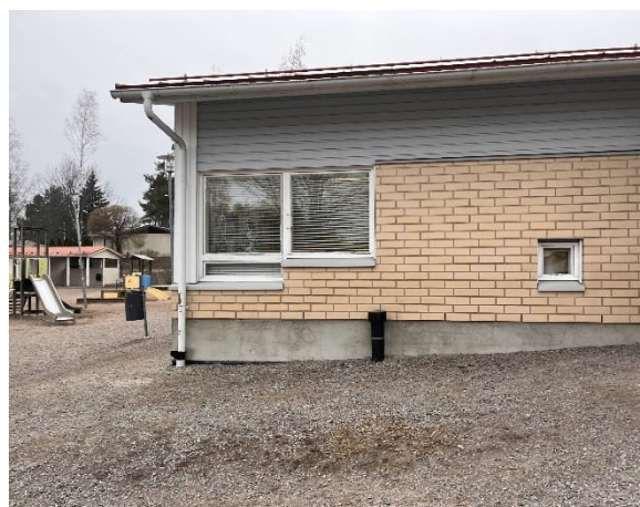
Kuva 38 Ulkoseinän yläosa on puuverhoiltu.
