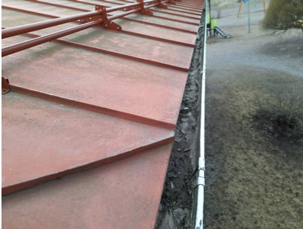
Kuva 93. Tippapelti ohjaa sadeveden paikoin sadevesikourun ohi.
