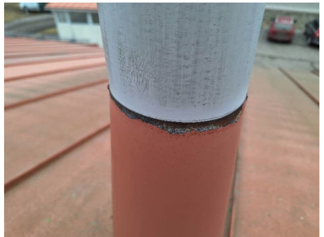
Kuva 90. Tuuletusputken ja tyvikartion liitoksessa ei ole tiivistysmassaa.
