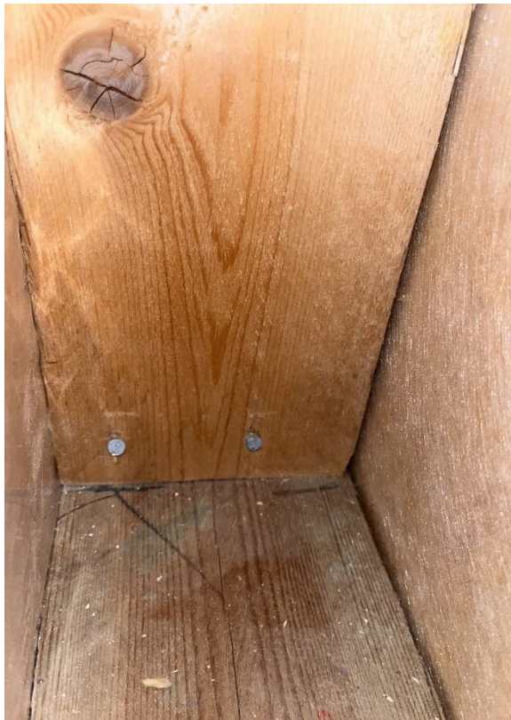
Kuva 60 US10. Ulkoseinärakenteen alaosa.
