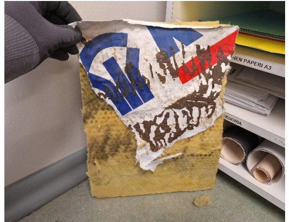
Kuva 57 US3. Tuulensuojavilla on kiinni bitumikermässä.
