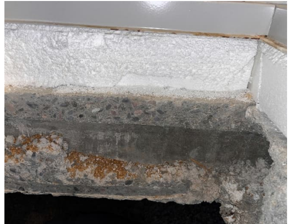
Kuva 38 Alapohjarakenne ryömintätilan luukusta katsottuna.
