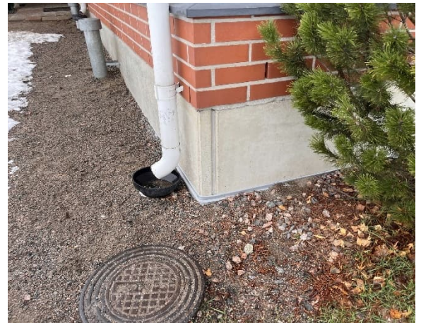
Kuva 19 Rakennuksen vierustaa ja sadevesien ohjausta.
