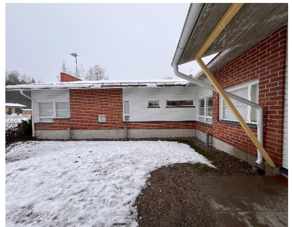
Kuva 4 Piha-alue ja julkisivu.
