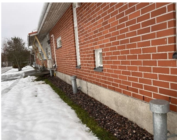
Kuva 26 Rakennuksen vierustaa keittiön sisäänkäynnin puolelta.
