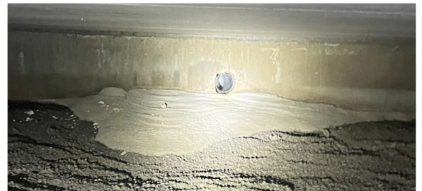
Kuva 44 Ylijäämäbetonit on laskettu ryömintätilaan.
