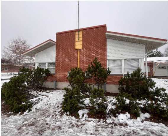
Kuva 5 Sadevesien ohjausta ja ryömintätilan tuuletusputkea.
