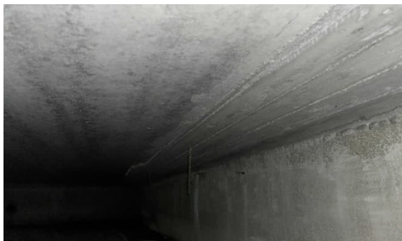
Kuva 31 Ryömintätilaa. Reuna-alue on paikalla valettua betonia.
