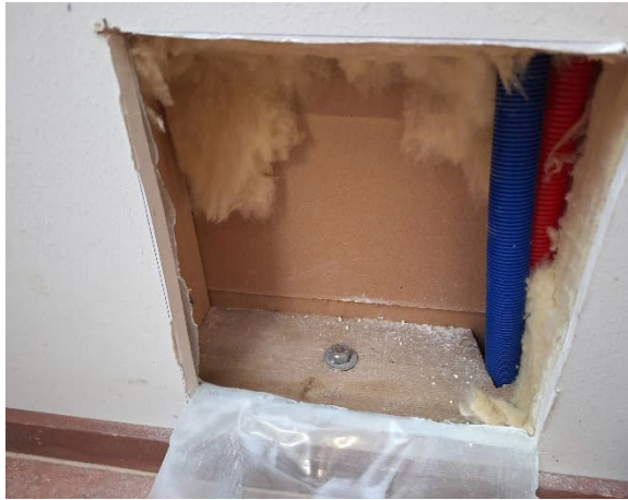
Kuva 75 Yleiskuva [VS1], ruokalan ja pesuhuone/WC:n välinen väliseinärakenne.
