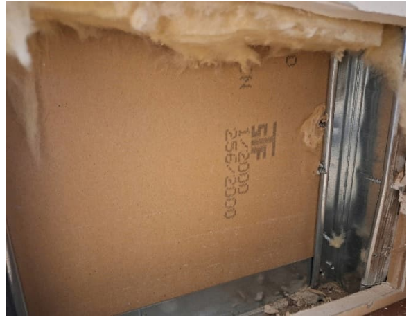
Kuva 76 Yleiskuva rakenteen sisältä [VS2], keittiön vastainen väliseinärakenne.
