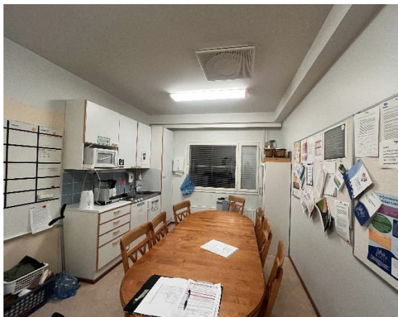
Kuva 80 Henkilökunnan tilan sisäkatto.
