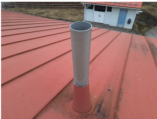
Kuva 85. Viemärin tuuletusputki.
