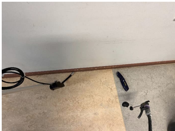
Kuva 97 Alapohjan eristetilaan laskettu merkkiainekeasu kulkeutui ulkoseinä-lattialiittymän kautta sisäilmaan.
