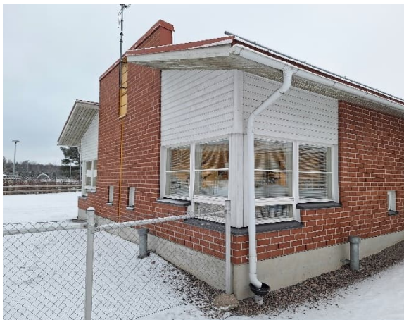
Kuva 50 Ulkoseinää. Isompien ikkunoiden yläosien julkisivut ovat pääosin puuverhoituja.
