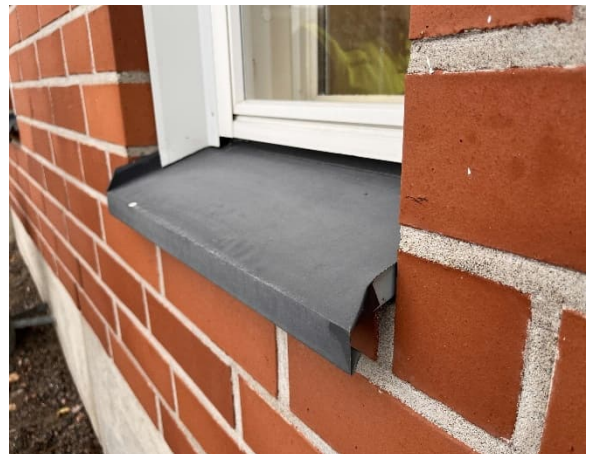
Kuva 51 Ikkunapeltien kaato on riittävä.
