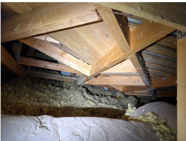
Kuva 93. Vesikaton rakenteissa ei havaittu kosteusjälkiä tai mikrobivaurioita.
