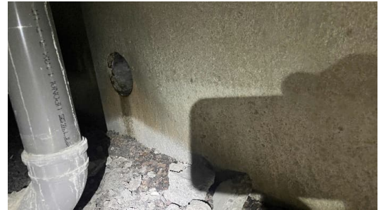
Kuva 42 Ryömintätilan tuuletusta.
