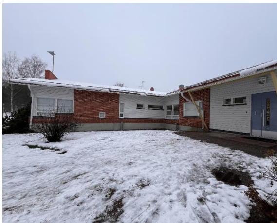
Kuva 3 Piha-alue ja julkisivu.
