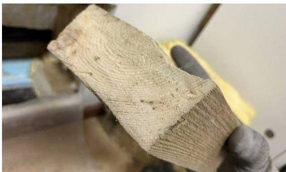
Kuva 59 US7. Alaohjauspuu oli aistinvaraisesti arvioituna hyväkuntoinen.
