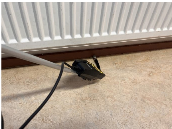
Kuva 98 Merkkiainekeasu kulkeutui ryömintätilasta lattia-ulkoseinäliittymän kautta sisäilmaan.
