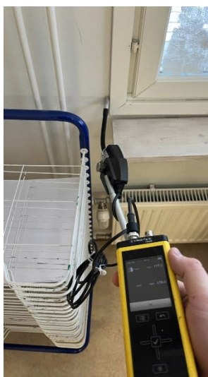
Kuva 102 Ilmapuotoa havaittiin ikkuna-ulkoseinäliittymien kautta.
