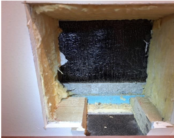
Kuva 67 US13. Ulkoseinärakenteen alaosa.
