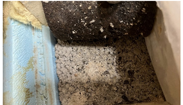
Kuva 58 US5. Bitumikermän alla on lecasoraharkko.
