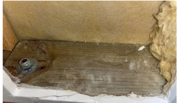
Kuva 62 US7. Puurakenteissa ei havaittu kosteusjälkiä.
