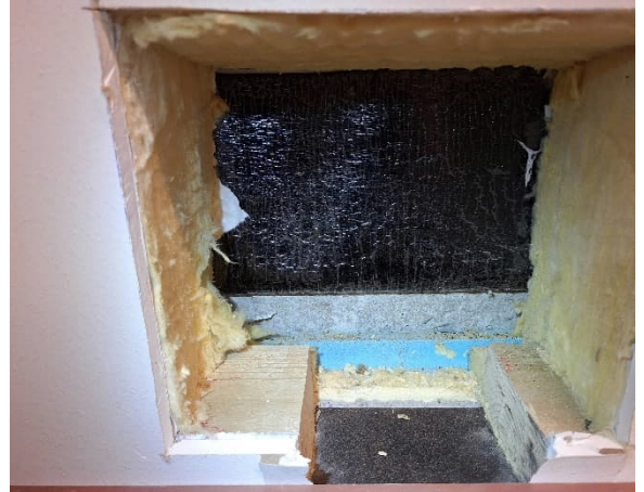
Kuva 56 US13. Ulkoseinärakenteen alaosa.
