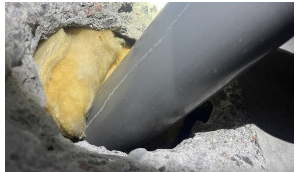
Kuva 46 Epätiivis läpivienti.
