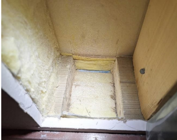
Kuva 55 US1. Ulkoseinärakenteen alaosa.
