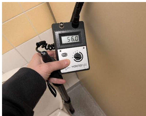
Kuva 19 Poikkeavia pintakosteusarvoja ei havaittu.
