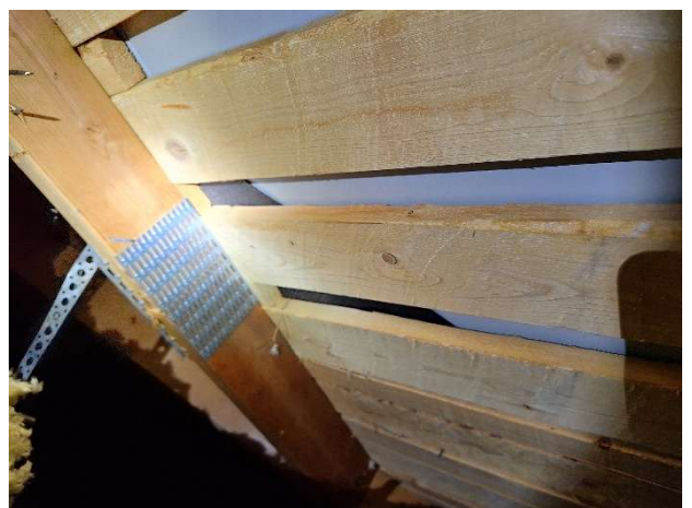
Kuva 110. Sisätaitteiden kohdalla katteen alla on bitumikermi.
