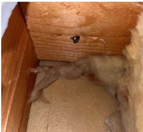
Kuva 83 Rakenneavaus US8. Ikkunan alapuolisissa puurakenteissa ei havaittu viitteitä vaurioista.
