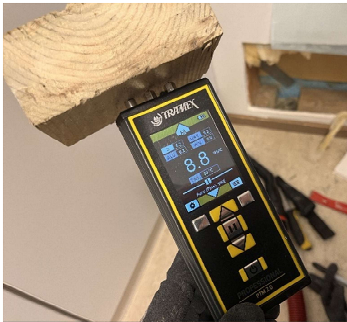
Kuva 71 Rakenneavaus US5. Puun kosteusmittausta.
