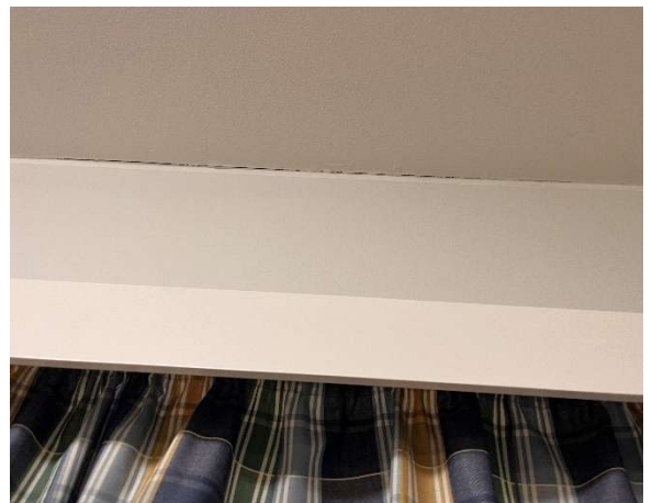
Kuva 27 Halkeamia katto/seinäliittymässä.
