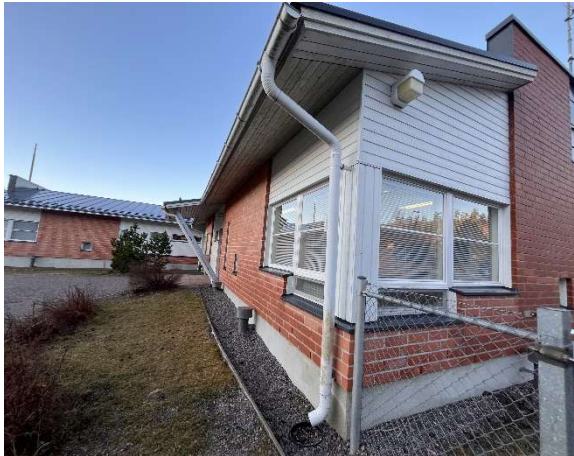
Kuva 52 Ulkoseinää. Ikkunoiden yläosien rakenteet ovat pääosin puuverhoituja.
