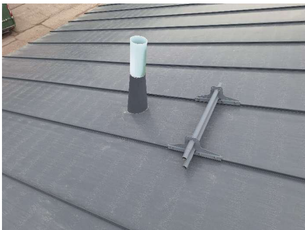
Kuva 101. Viemärin tuuletusputki.
