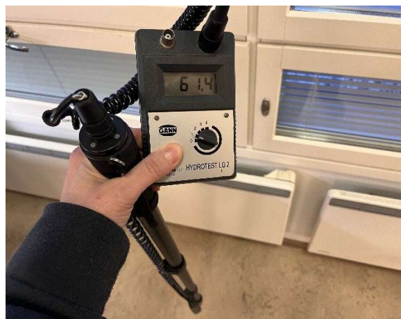
Kuva 21 Poikkeavia pintakosteusarvoja ei havaittu.
