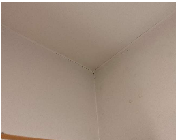
Kuva 24 Halkeamia katto/seinäliittymässä.
