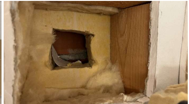
Kuva 58 Rakenneavaus US1. Ulkoseinän yläosa.
