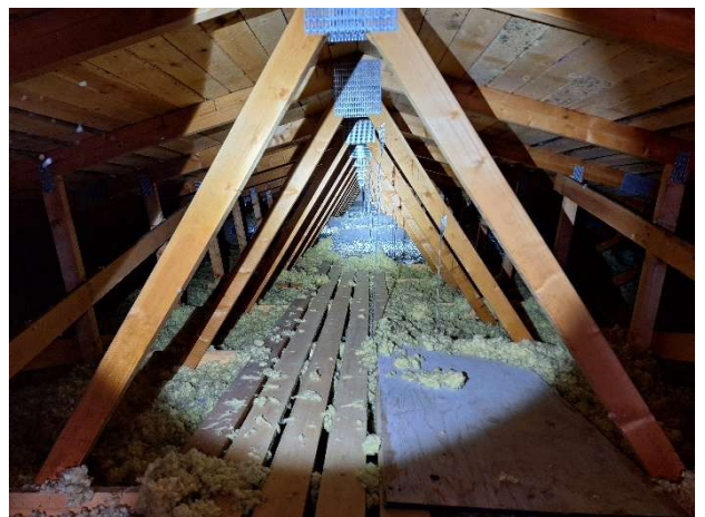
Kuva 108. Kuvaa tuuletetusta ilmatilasta.
