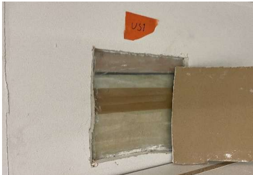
Kuva 57 Rakenneavaus US1. Ulkoseinän yläosa.
