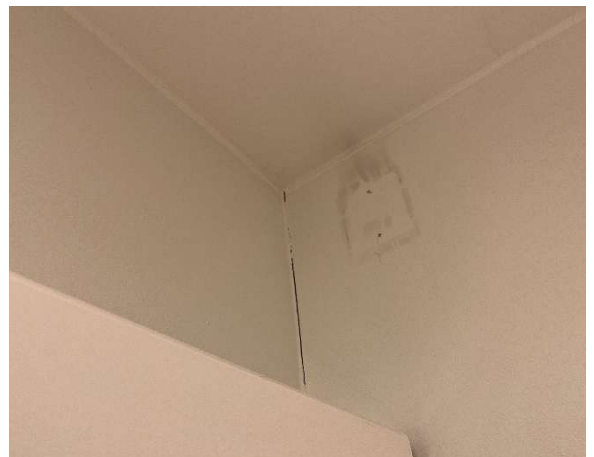
Kuva 25 Halkeamia katto/seinäliittymässä.
