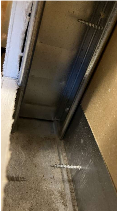
Kuva 91 Yleiskuva rakenteen sisältä [VS2].
