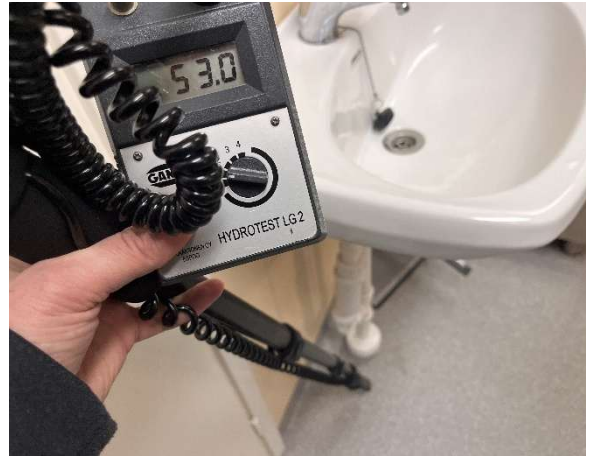
Kuva 23 Poikkeavia pintakosteusarvoja ei havaittu.
