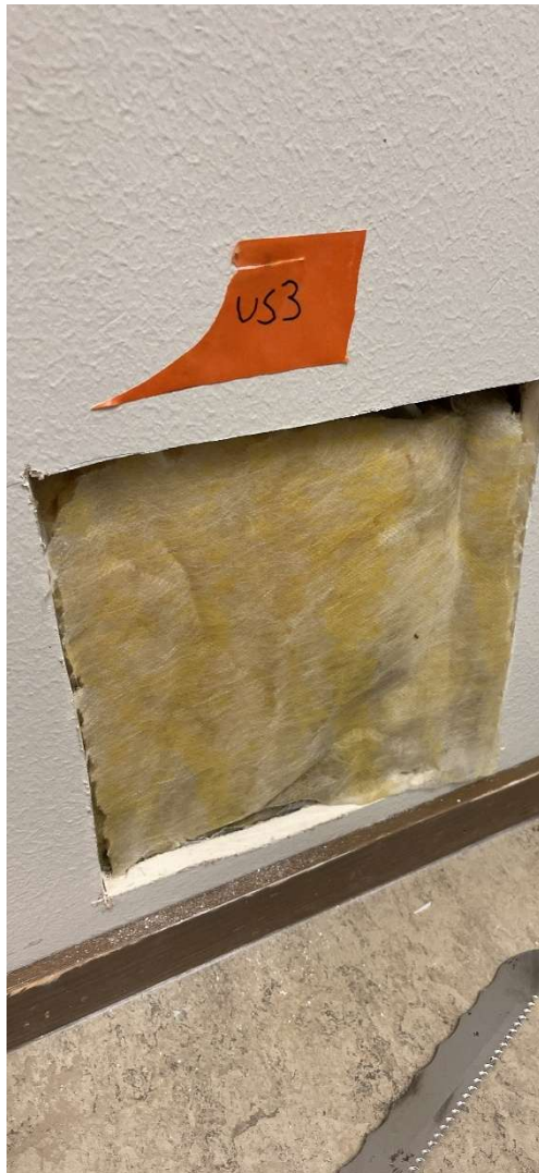
Kuva 63 Rakenneavaus US3.
