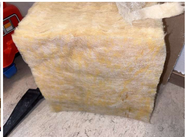
Kuva 74 Rakenneavaus US6. Ulkoseinän lämmöneriste.
