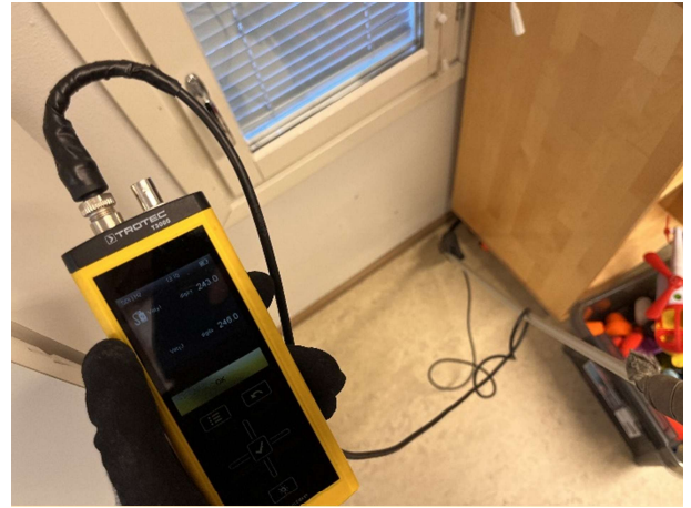
Kuva 121 Runsasta ilmavuotoa havaittiin ulkoseinä-alapohjan eristetilän kautta.
