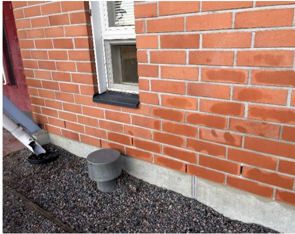
Kuva 5 sadevesien ohjausta ja ryömintätilan tuuletusputkea.
