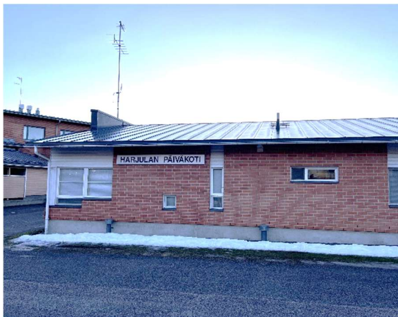
Kuva 7 Rakennuksen julkisivua pysäköintialueen puolelta.
