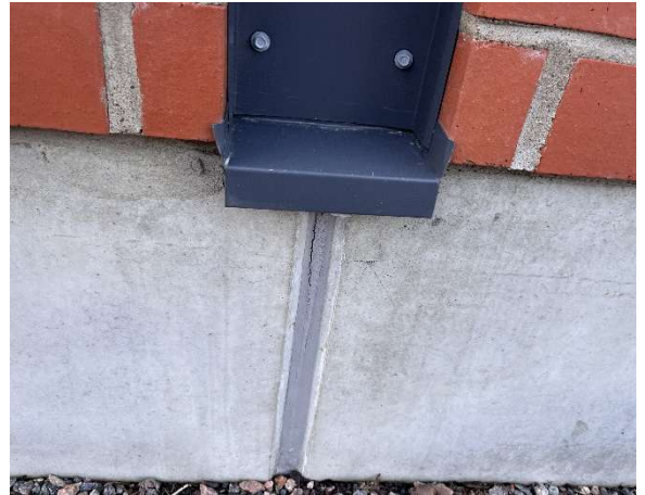
Kuva 53 Peltien kaato oli paikoin vähäinen.
