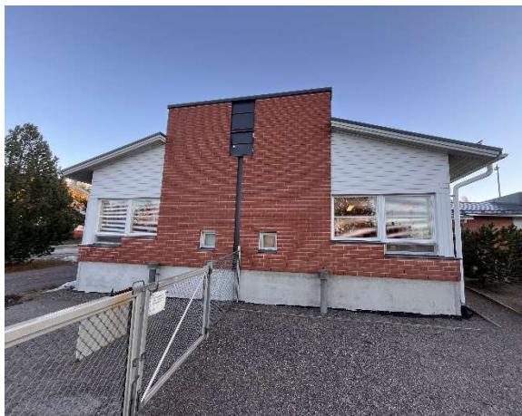
Kuva 3 Piha-aluetta ja julkisivua.
