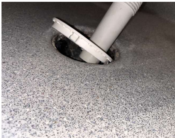
Kuva 16 Jänönhäntien pesutilan viemärin kansi on irti.
