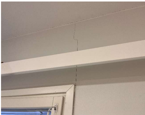
Kuva 26 Halkeamia katto/seinäliittymässä.
