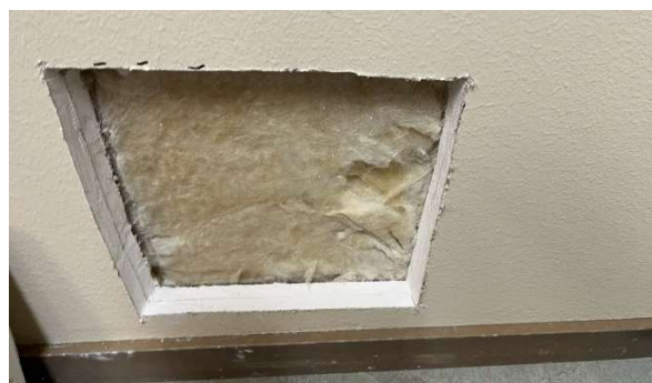
Kuva 90 Yleiskuva rakenteen sisältä [VS2].
