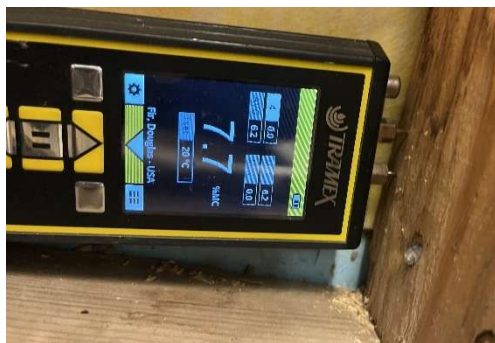
Kuva 65 Rakenneavaus US3. Puurungossa ei havaittu poikkeavia kosteusarvoja.
