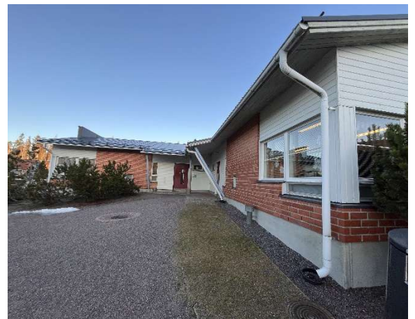
Kuva 4 Piha-aluetta ja julkisivua.
