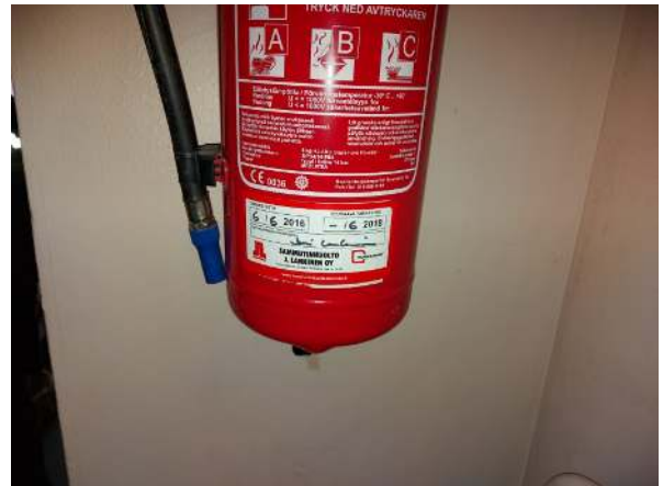
60. Käsisammutin tarkastettu 2016.
