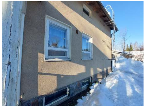
2. Rakennusten vierustat, pintavesien poisto ja salaojitus
