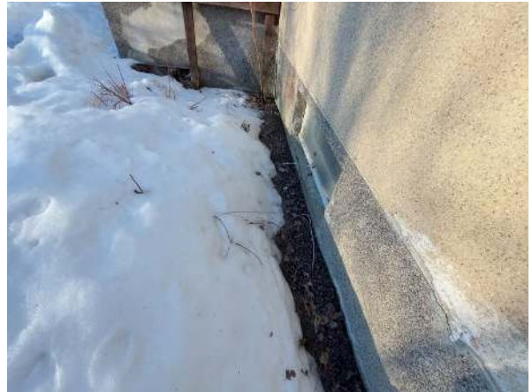
4. Perustukset ja sokkelit
