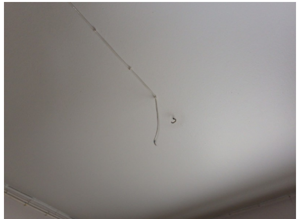
72. Pinta-asennusta huoneistossa (käytöstä poistettu johto tulisi rasioida tai poistaa kokonaan).
