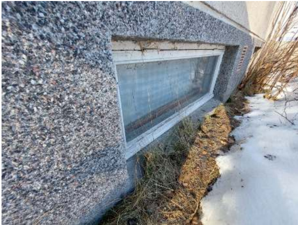
3. Perustukset ja sokkelit
