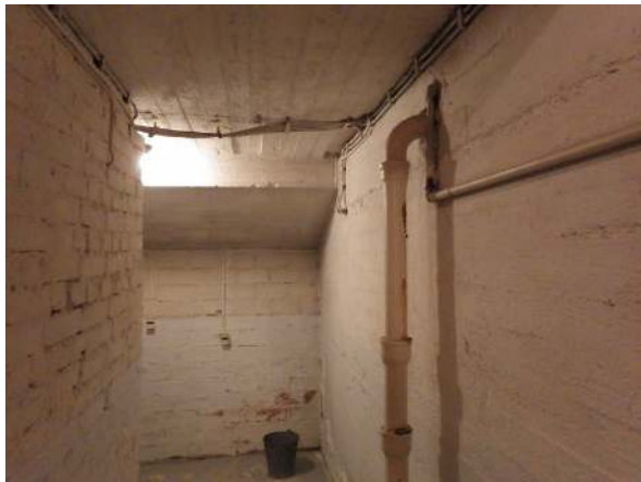
71. Pinta-asennusta kellaritiloissa (katosta irronnut johtonippu).
