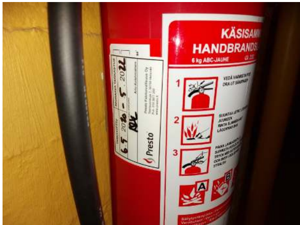
59. Käsisammutin tarkastettu.
