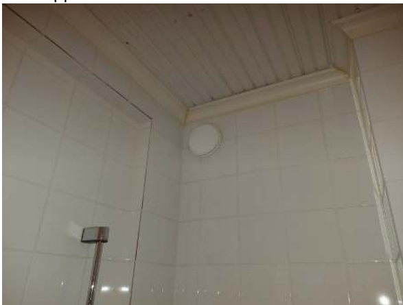
58. Poistoilmaventtiili.
