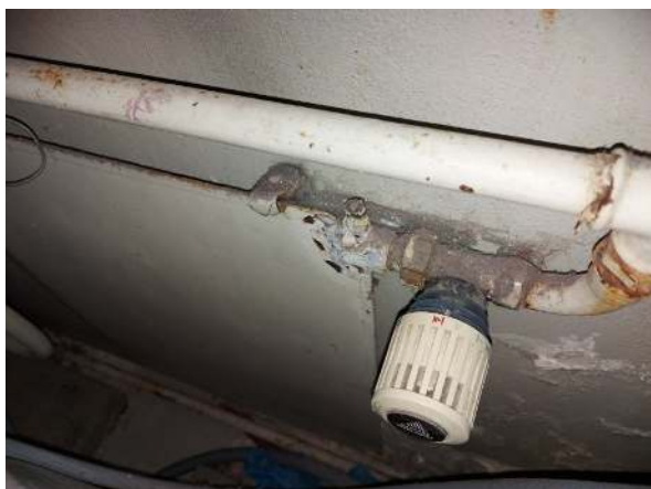
41. Termostaattinen patteriventtiili.
