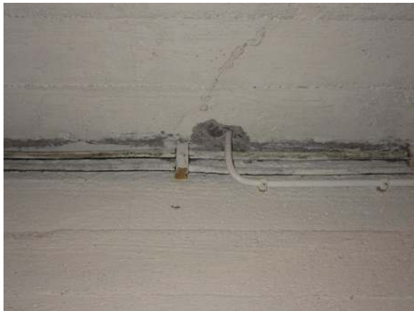
69. Avoin kaapeliläpivienti kellarissa...
