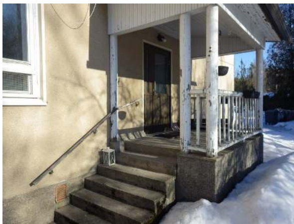
61. Rakenteisiin asennettu valaisin, josta puuttuu kupu.
