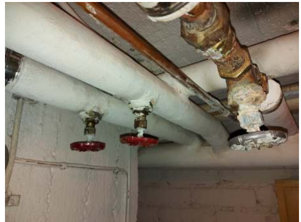
46. Käyttöveden linjaventtiileitä.
