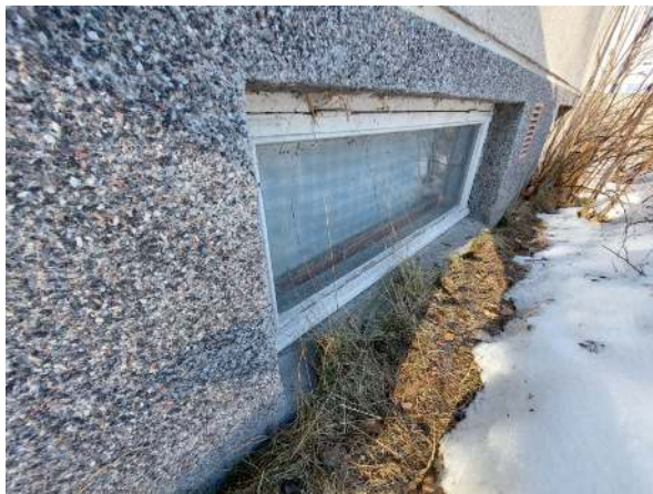
1. Rakennusten vierustat, pintavesien poisto ja salaojitus
