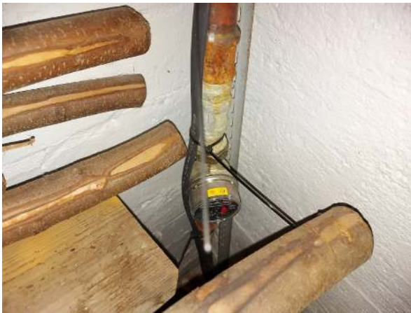
44. Kiinteistön päävesimittari.
