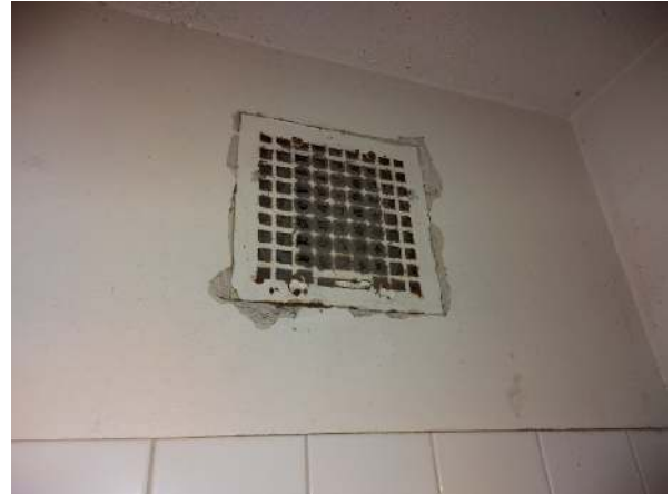
57. Alkuperäinen valurautasäleikkö.
