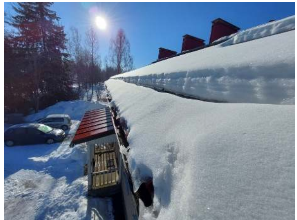
18. Etulipan katto on kohtalaisen hyvässä kunnossa.
