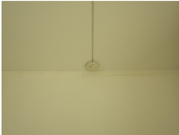
86. Huoneiston palovaroitin (liian lähellä seinän reunaa).
