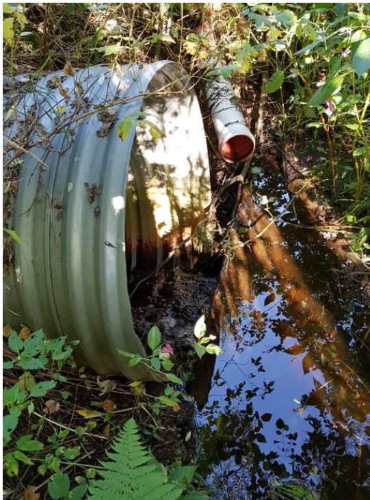
Kuva 14. Risusillantien alittava 1200 mm teräsrummu, kuva rummun yläjuoksulta. [Ramboll 9/2021]
