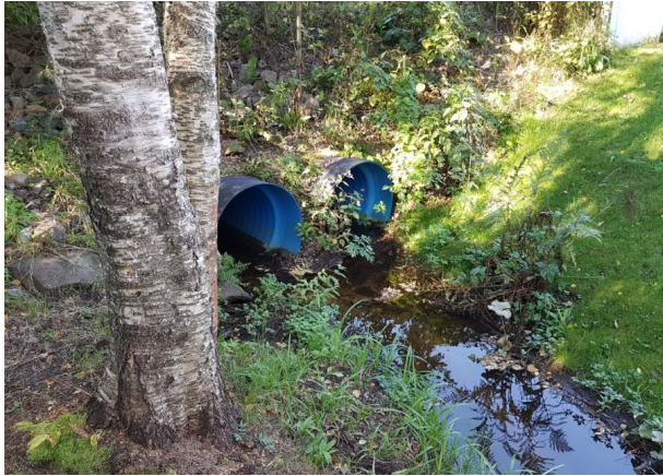
Kuvat 10. ja 11. Ylikorventien alittavat 800 mm muovirummut, oikeanpuoleinen kuva purkupäästä. [Ramboll 9/2021]
