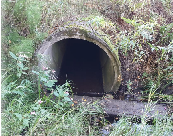
Kuvat 12. ja 13. Lopentien (Mt 132) alittava 1200 mm betonirumpu, oikeanpuoleinen kuva purkupäästä. [Ramboll 9/2021]
