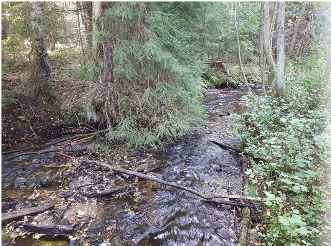
Kuva 17. Myllyjoja Kassakummuntien alittavan rummun alajuoksun suuntaan katsottuna. [Ramboll 9/2021]
