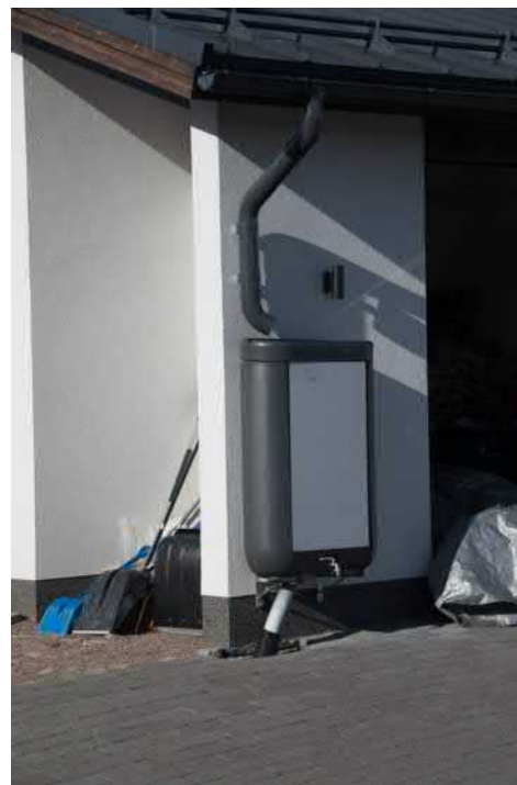
Kuvat 4 (vas.) ja 5. Kaksi tapaa viivyttää hulevesiä tontilla. Vasemmanpuoleisessa säiliö, josta saadaan kätevästi myös kasteluvettä istutuksia varten. Oikeanpuoleisessa luonnonmukainen painanne. Kuvat Janne Oittinen.
