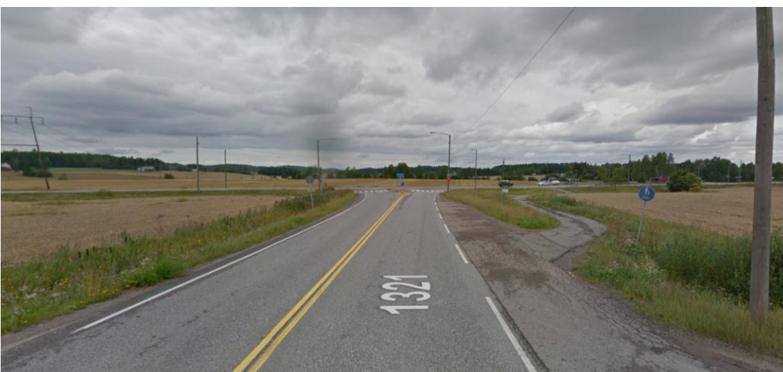
Perttussa yhdistetty jalankulku- ja pyöräilyväylä jatkuu Perttulantien pohjoispuolella mt 132 liittymän kohdalla. (Kuva © Google, 08/2011)
