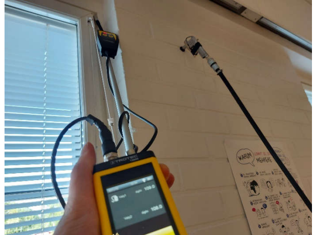
Kuva 14. Ilmavuotoa havaittiin ikkunan karmiliitosten kautta.
