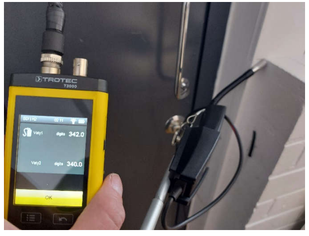
Kuva 10. Ilmavuotoa havaittiin ulko-oven viereisen koteloinnin liittymien kautta.
