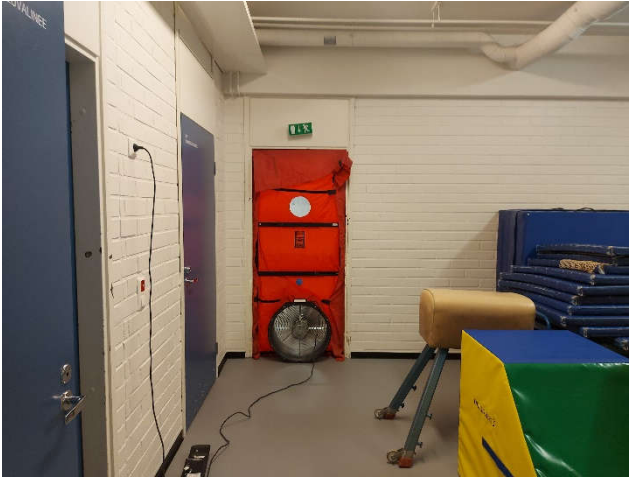
Kuva 1. Tutkittavat tilat alipaineistettiin keinotekoisesti merkkiainekokeen ajaksi n. 10 Pa ulkoseinän eristetilaan nähden.
