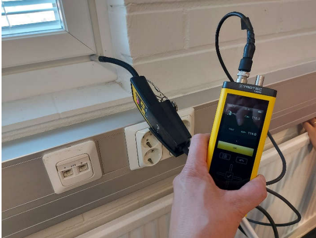
Kuva 13. Ilmavuotoa havaittiin ikkunan karmiliitosten kautta.
