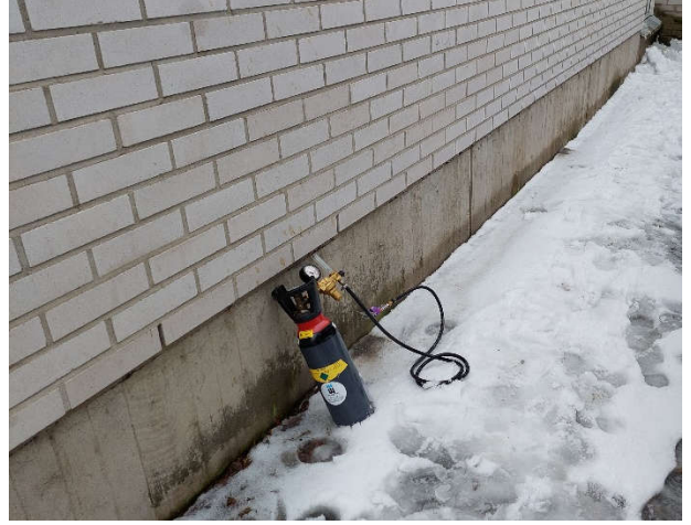
Kuva 2. Merkkiainekaasun annostelua ulkoseinärakenteeseen poratun reiän kautta.
