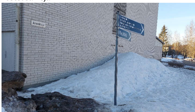
Kuva 21. Liikuntasalin ulkoseinää vasten oleva lumivalli esti osin kaasun syöttämisen ulkoseinän alaosaan.
