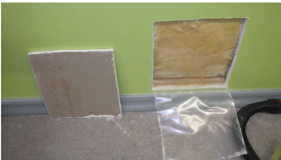
Kuva 8. Rakenneavaus 2 tehtiin leppötilan ulkoseinärakenteeseen.
