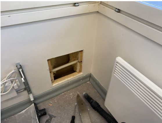
Kuva 6. Rakenneavaus 1 (RA 1) tehtiin leikkikalan ulkoseinärakenteeseen.
