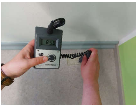
Kuva 5. Pintakosteuskartoituksessa havaittiin lievästi poikkeavia arvoja betonilattian pinnalta. Leikkitala.
