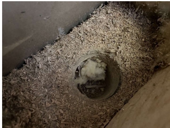
Kuva 7. RA 1. Alaohjauspuun alla olevaa villakaistaa.
