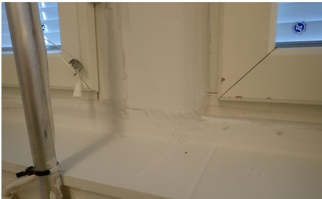
Kuva 13. Ikkunaliittymän valmis tiivistys ennen listoitusta (tila 147).
