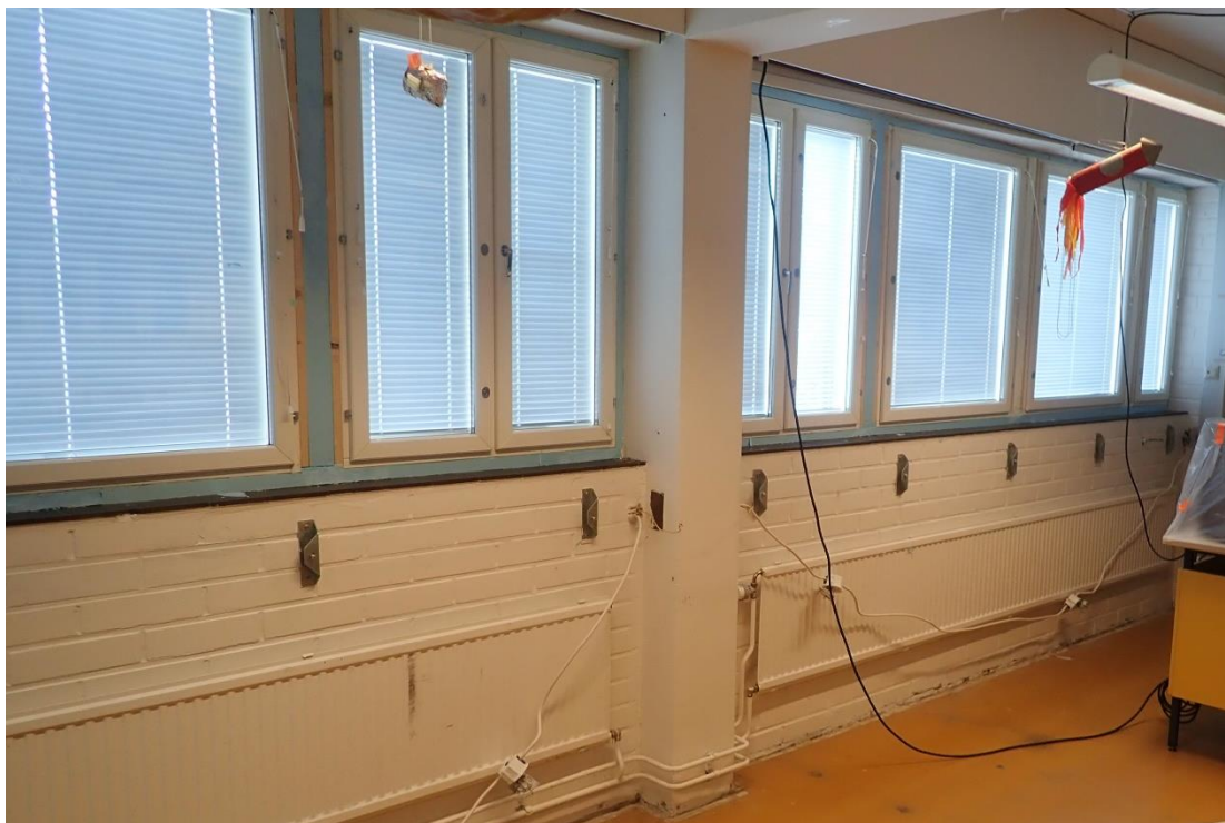
Kuva 12. Luokkahuone 233, jossa tiivistystöitä ei ole vielä tehty. Ikkunaliittymien vanhat eristeet on poistettu ja uusittu XPS-eristeellä, jonka saumat on tiivistetty PU-vaahdolla. Ennen ikkunaliittymien tiivistystä saumojen pinta on tasoitettu elastisella saumamassalla.
