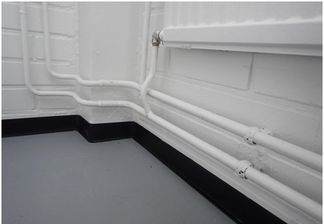
Kuva 15. Valmiissa tiloissa lattialiittymän päälle on asennettu muovijalkalista.
