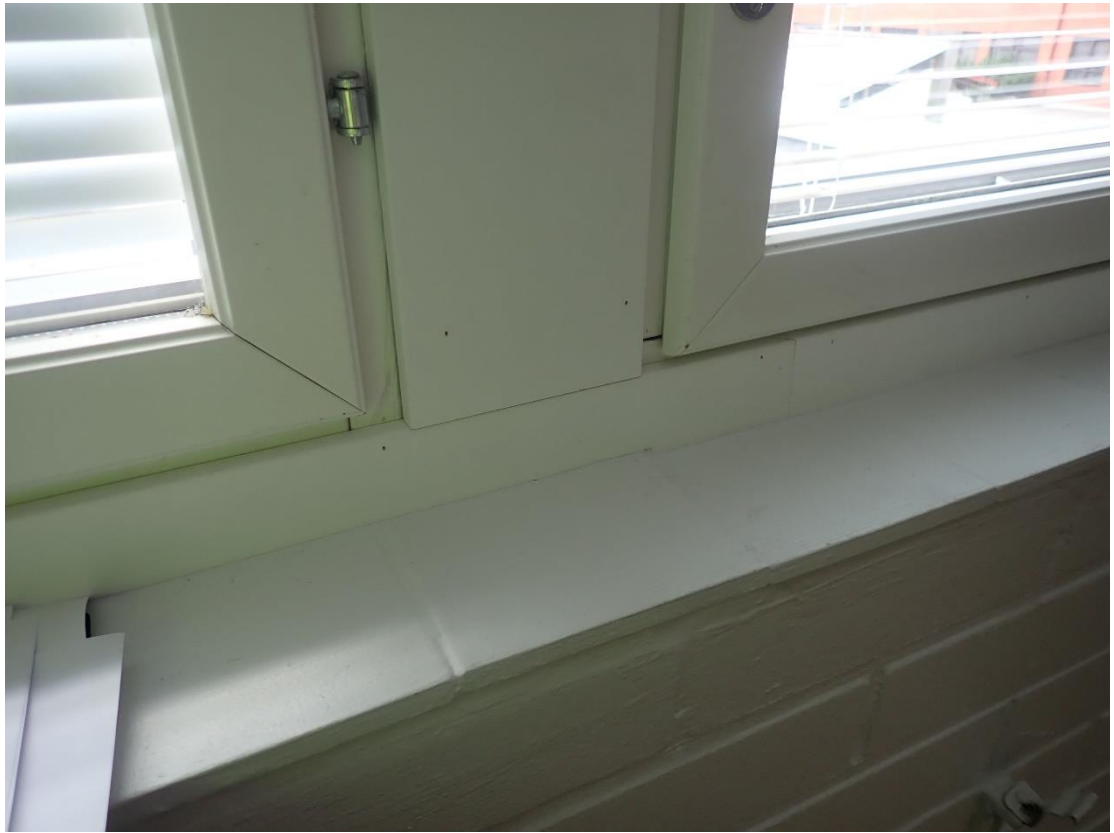
Kuva 14. Valmiissa tiloissa listanaulat on asennettu pääosin listan reunaan.
