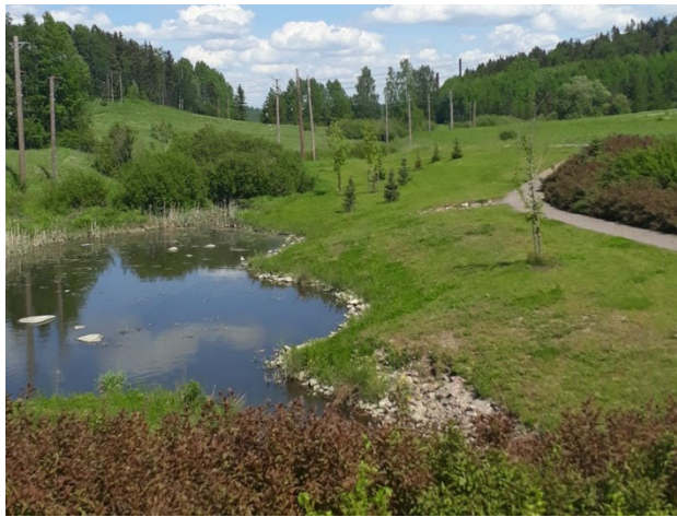
Kuva 6. Alueen pohjoispuolella on jo rakennettu hulevesien viivytysallas.
