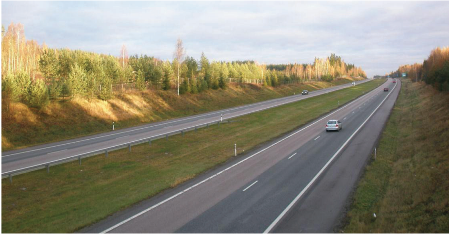
Kuva 3. Alueen julkisivu Hämeenlinnankäytävän (VT 3) suuntaan Palojoentien sillalta pohjoiseen päin katsottuna hahmotuu nykyisellään puustoisena ja maastoltaan pienimuotoisesti vaihtelevana.
