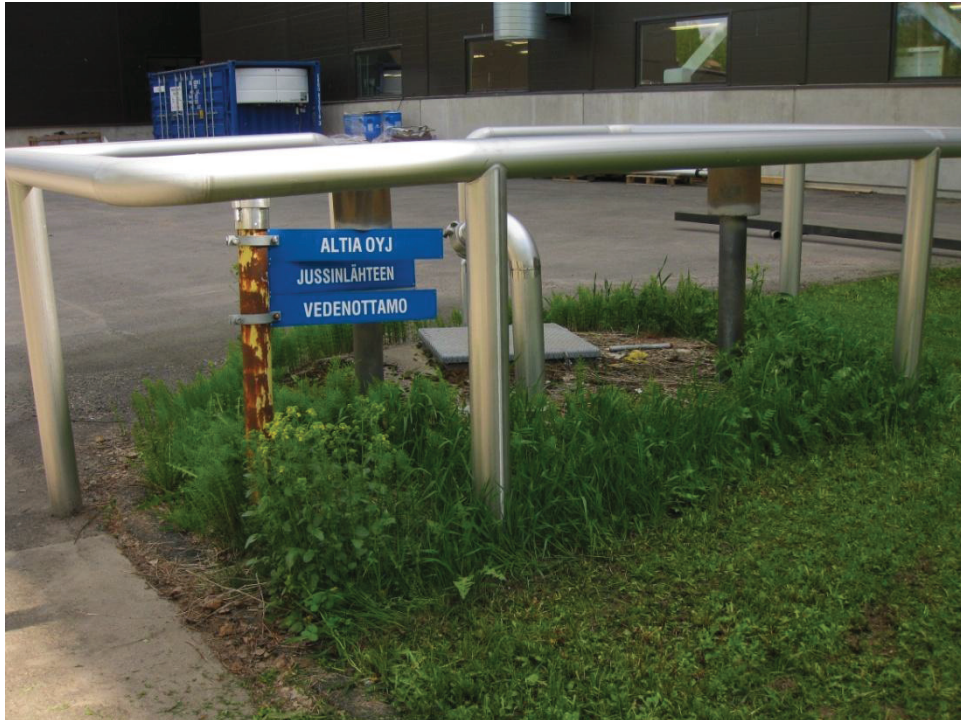
Kuva 7. Jussinlähteen vedenottamo Valta-Akselilla Rajamäellä.
