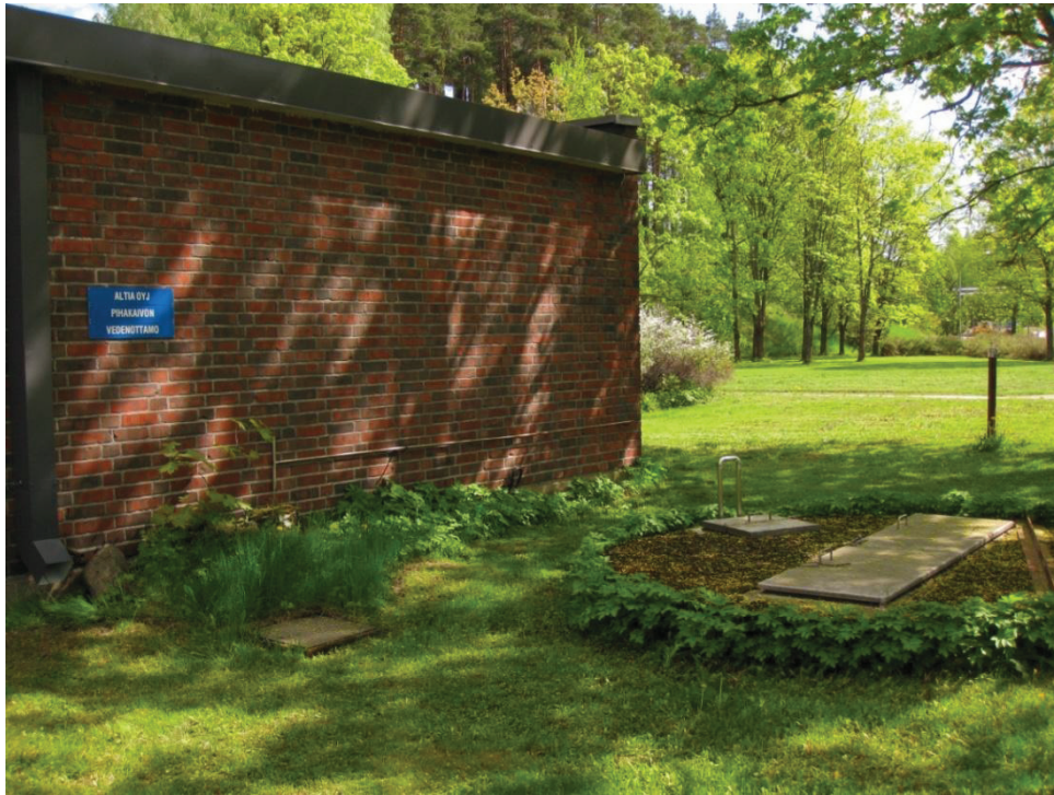
Kuva. 9. Pihakaivon vedenottamo Rajamäen tehdasalueella Nurmijärvellä.
