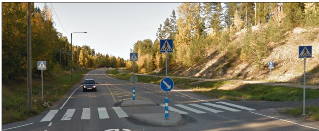
Kuva 12. Keskisaarekkeellinen suojatie Rajamäentiellä, Astrakanintien liittymän vasemmalla puolella
