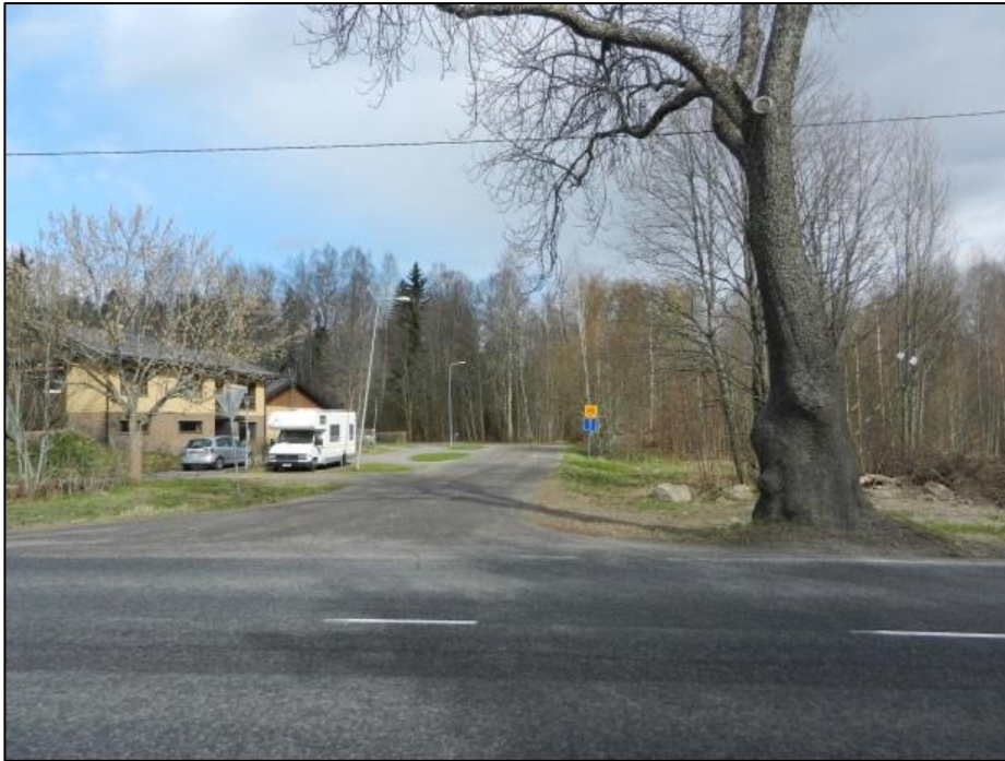
Kuva 8. Mäkeläntien ja Kiljavantien avoin tasoliittymä
