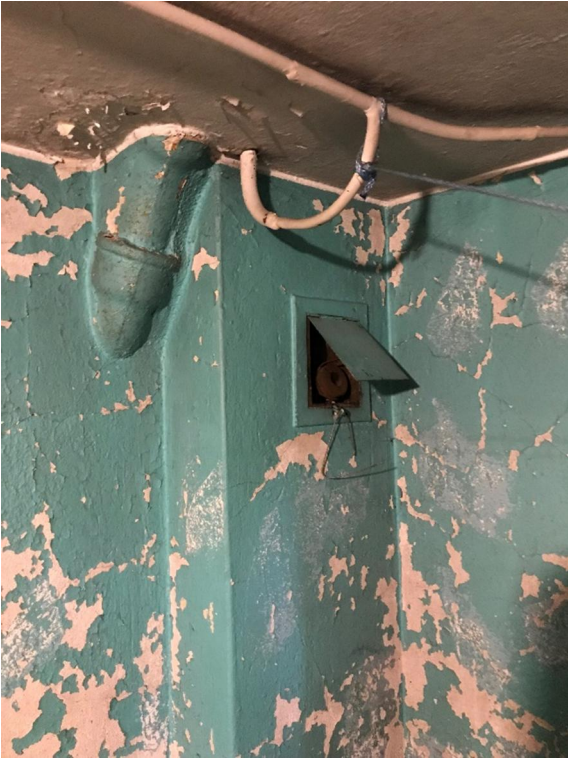
Kuva 27. Valurautaviemäri ja painovoimaisen ilmanvaihdon venttiili.
