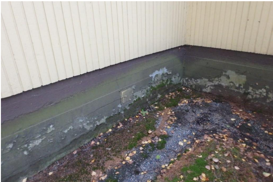
Kuva 7. Räystäältä tippuva sadevesi on muodostanut sokkelin vierustalle painauman, jossa vesi lammoikoituu. Sokkelin maalipinta hilseilee. Yksi alapohjan tuuletusluukuista oli suljettu.
