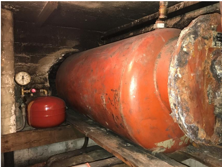
Kuva 24. Vanha käytöstä poistettu lämpimän käyttöveden varaaja lämmönjakohuoneessa.
