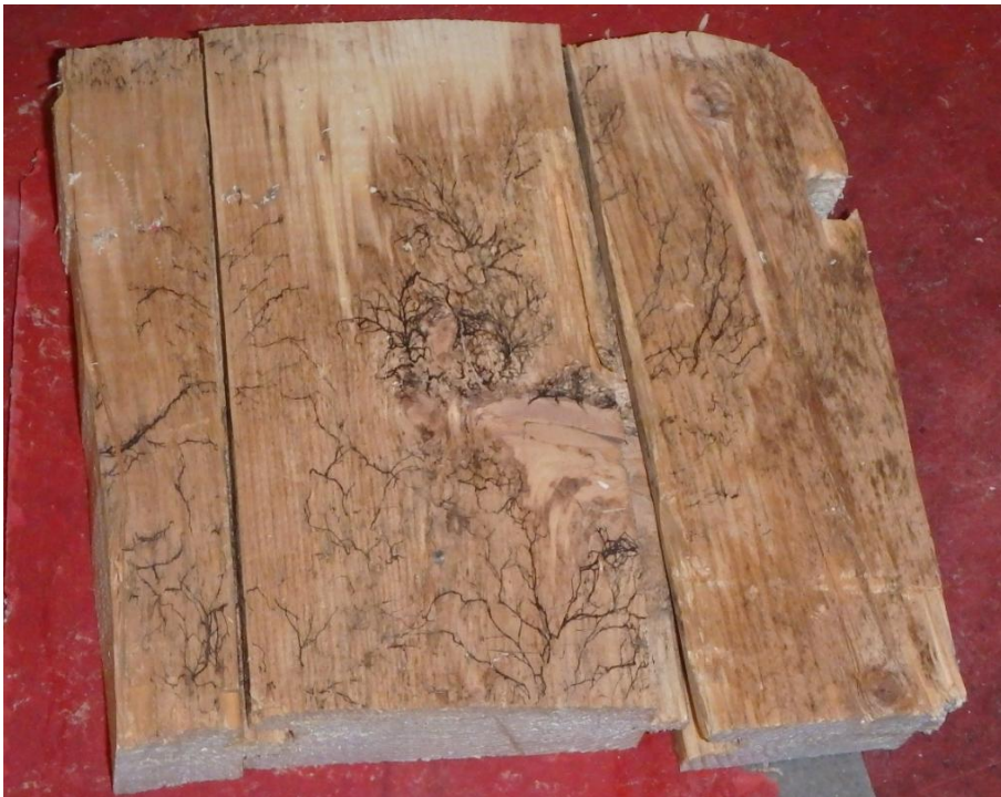
Kuva 11. Ensimmäisen kerroksen välipohjan lattialankun alapinnassa havaittiin mikrobikasvustoa.
