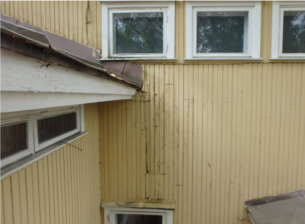
Kuva 17. Ensimmäisen kerroksen katolta tulevat sadevedet ovat kasteleet julkisivun panelointia. Rästäskourut puuttuvat. Ikkunoiden päälle on lisätty vesipellit. Vesi valuu ikkunan sisään pellin ja paneelin välisestä saumasta.
