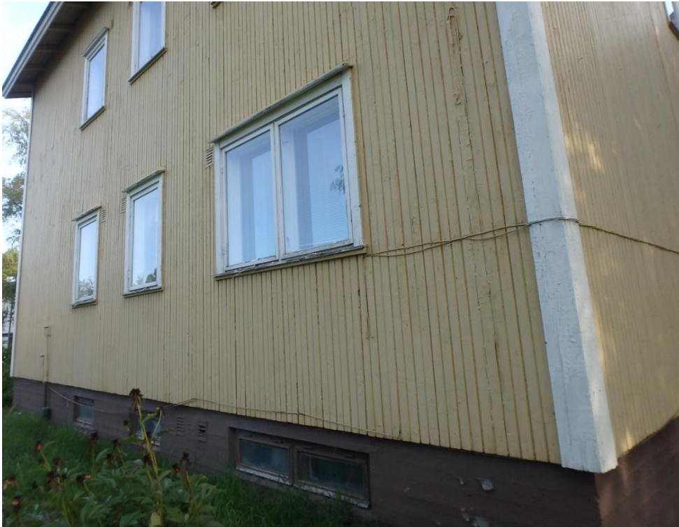
Kuva 14. Julkisivun maalipinta hilseilee jonkin verran lounaan puoleisella julkisivulla. Lounaan puoleisen julkisivun ikkunoiden maalipinnat olivat muita heikommassa kunnossa. Ikkunoista puuttuvat vesipellit.
