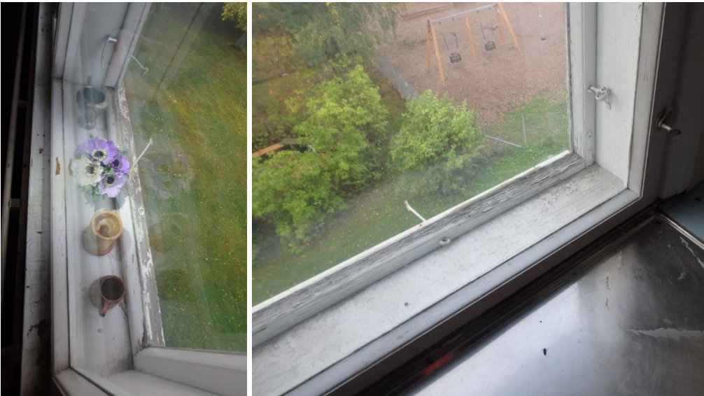
Kuva 18. Ikkunakarmien maalipinnat ovat heikossa kunnossa.
