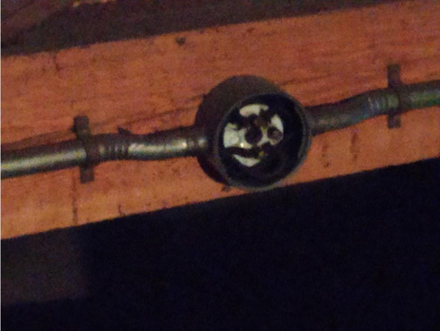
Kuva 29. Ullakon yhdestä jakorasiasta puuttu peitekansi.
