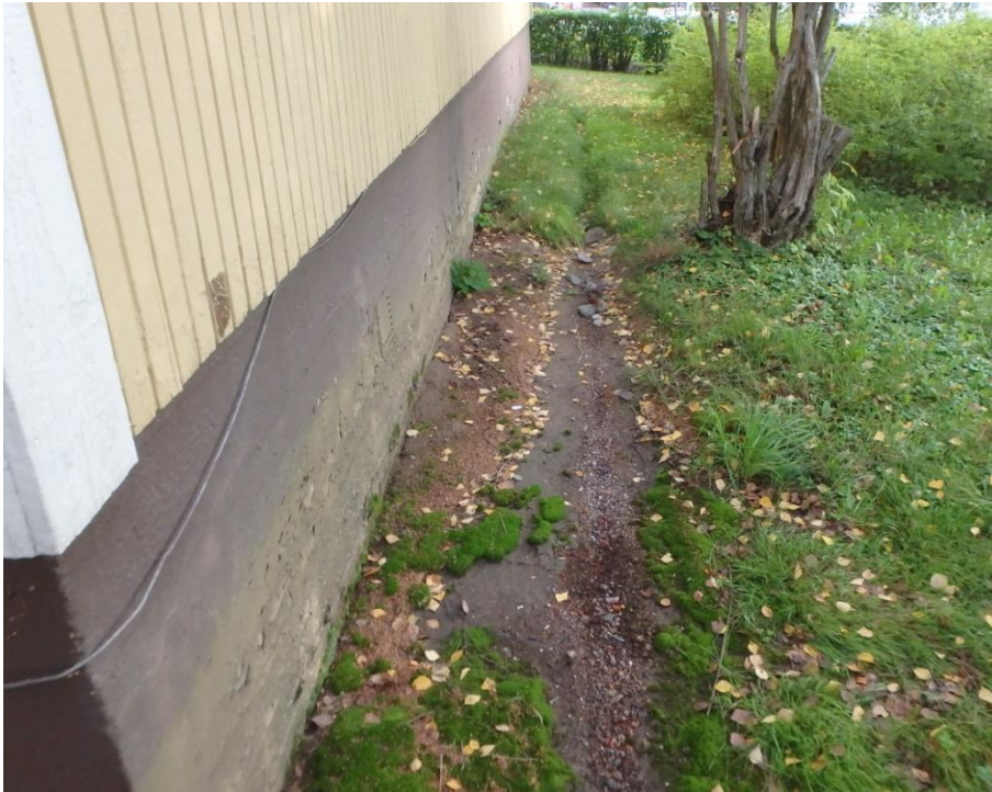
Kuva 6. Räystäältä tippuva sadevesi on muodostanut sokkelin vierustalle painauman, jossa vesi lammoikoituu. Sokkelin maalipinta hilseilee.
