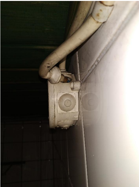
Kuva 30. Ullakon yhdestä jakorasiasta puuttu peitekansi.
