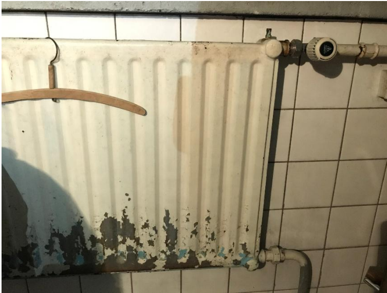
Kuva 25. Pesuhuoneen radiaattorin maalipinta on huonossa kunnossa.
