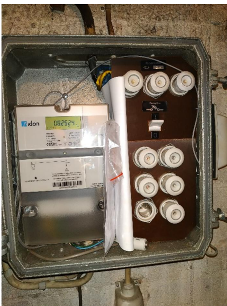
Kuva 35. Kellarikerroksen ryhmäkeskuksesta puuttuu varokekansi.
