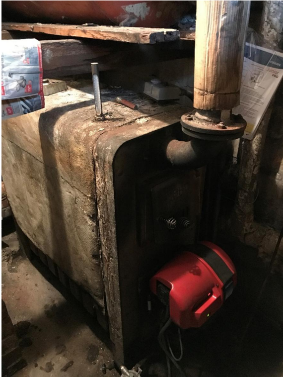
Kuva 23. Öljykattila ja -poltin lämmönjakohuoneessa.
