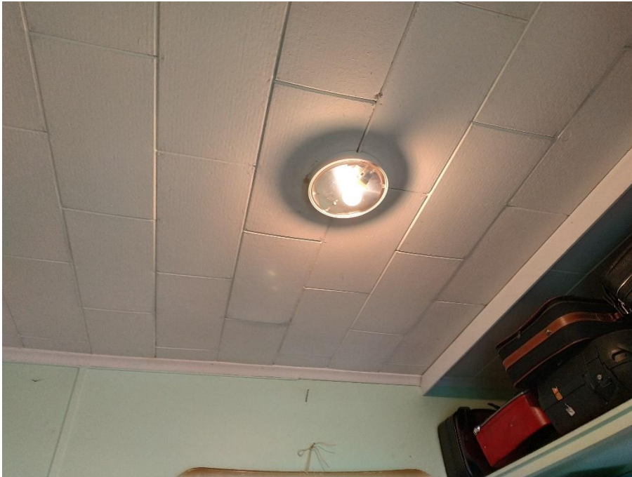
Kuva 38. Kirpputorin eteisen kattovalaisimesta puuttuu suojakupu.
