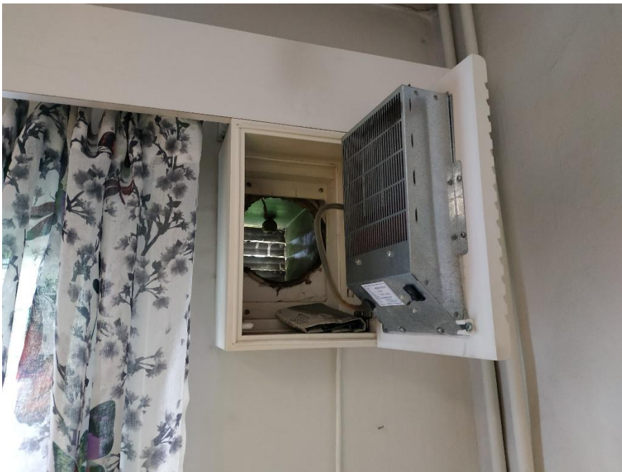
Kuva 42. Sähkötoiminen lämmityksellä varustettu tuloilmapuhallin kirpputorin tiloissa. Tuloilmakanavassa on ampiaispesä.
