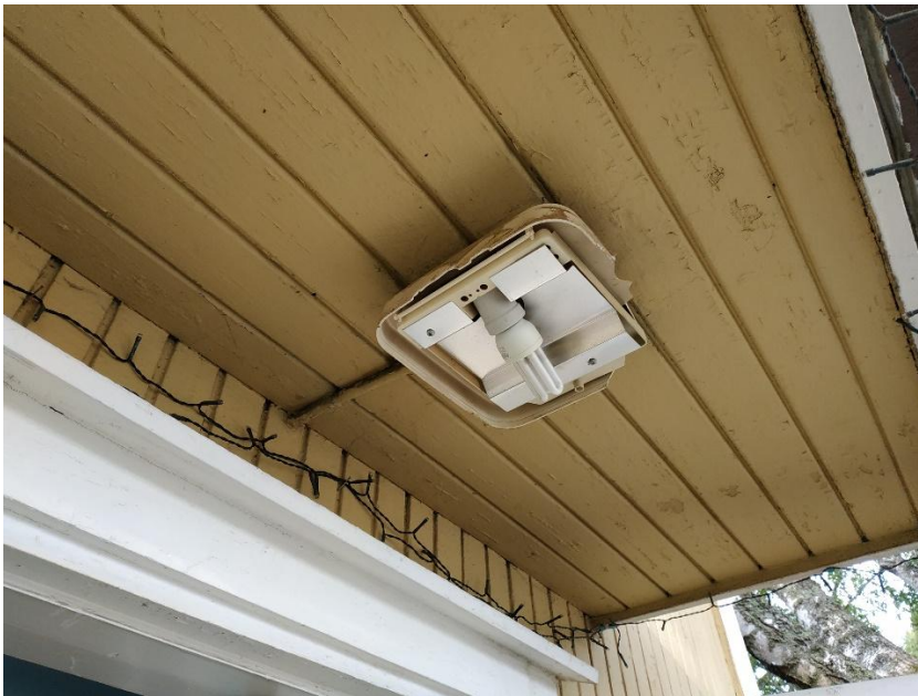
Kuva 37. Kirpputorin sisäänkäynnin ulkovalaisimesta puuttuu suojakupu ja valaisin on muutoinkin vaurioitunut.
