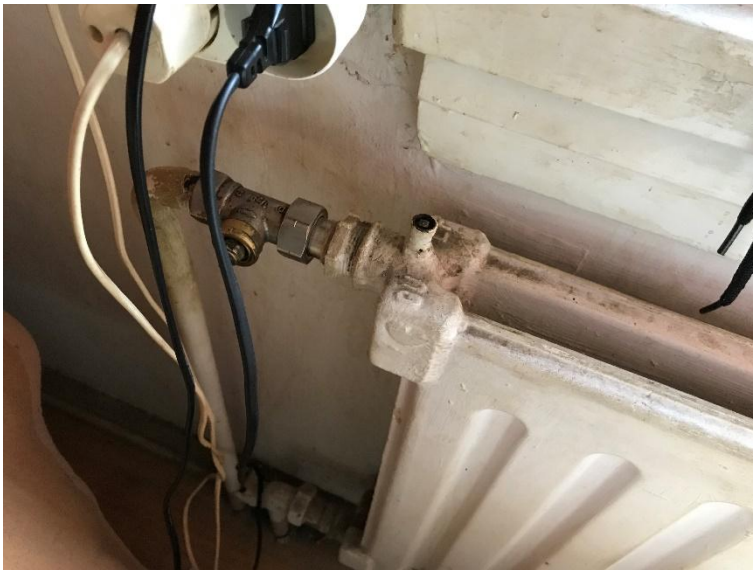
Kuva 26. Radiaattorista puuttuu termostaattiosa.
