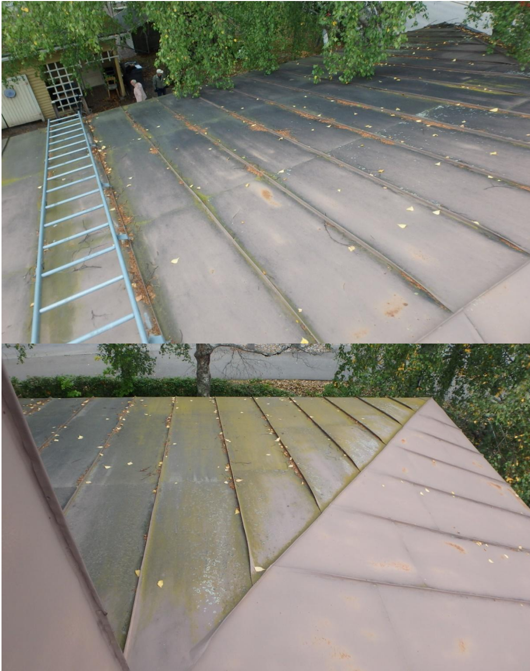
Kuva 19 ja 20. Vesikate on tehty palapelistä. Katteen maali on kulunut ja katolla on ruostetta. Pihakoivun oksat ovat katon päällä.
