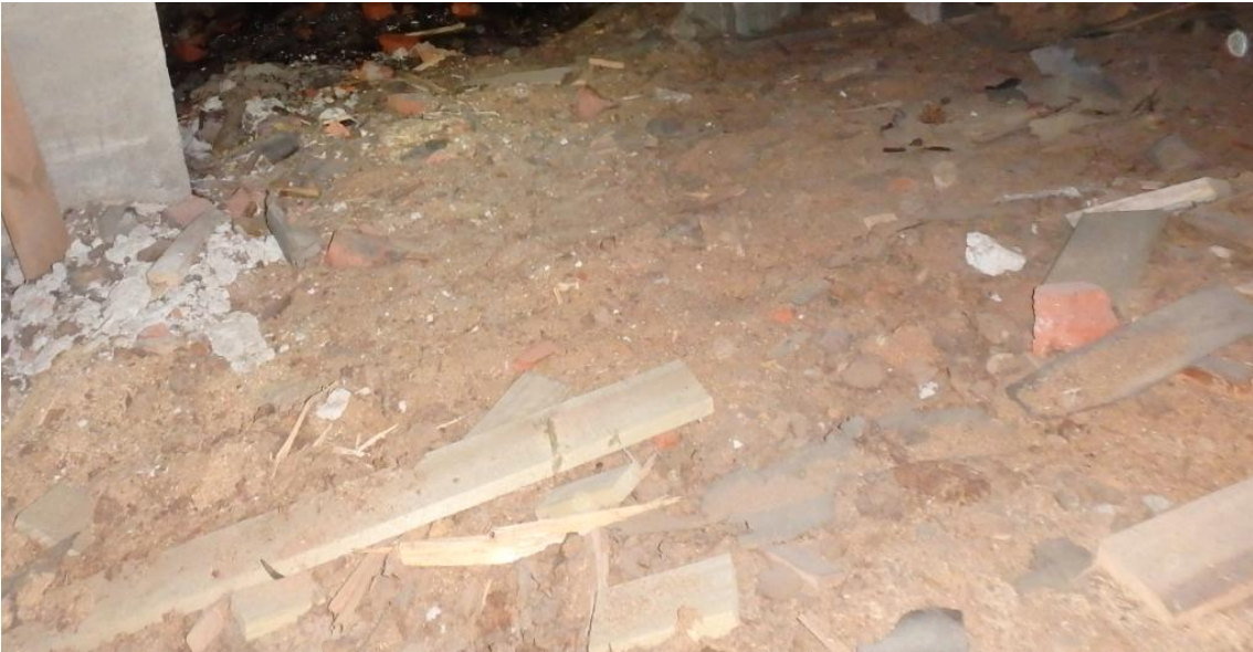
Kuva 8. Ryömintätilassa on perusmaana hieno hiekka. Tilassa on merkittävä määrä vanhaa rakennusjätettä.
