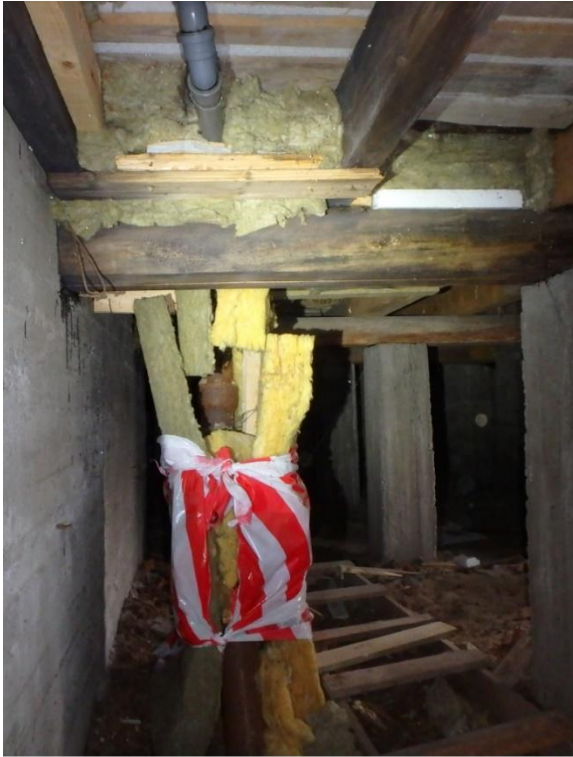
Kuva 22. Viemäriasennuksia alapohjassa.
