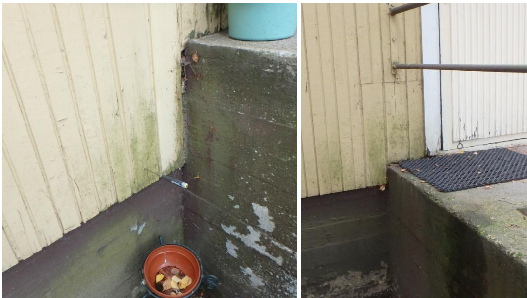
Kuva 15 ja 16. Julkisivun panelointia on paikattu portaiden vieressä. Paikatut osat ovat jo hieman pehmenneet ja maalipinnalla kasvaa levää tai sammalta.
