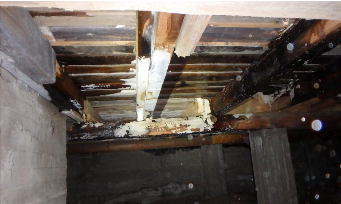
Kuva 9. Alapohjassa havaittiin laajahko kastunut vuotoalue. Kantavat puurakenteet ovat vesimäret ja mikrobikasvuston peitossa.
