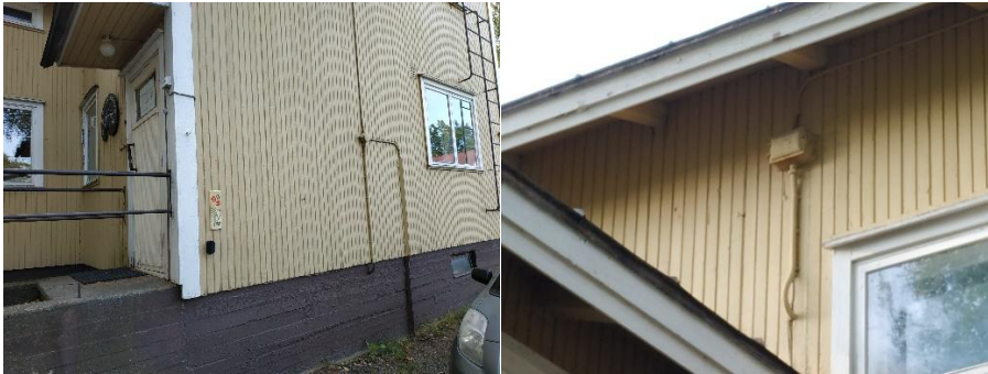
Kuvat 31 ja 32. Liittymiskaapelin kytkentärasiat julkisivussa.
