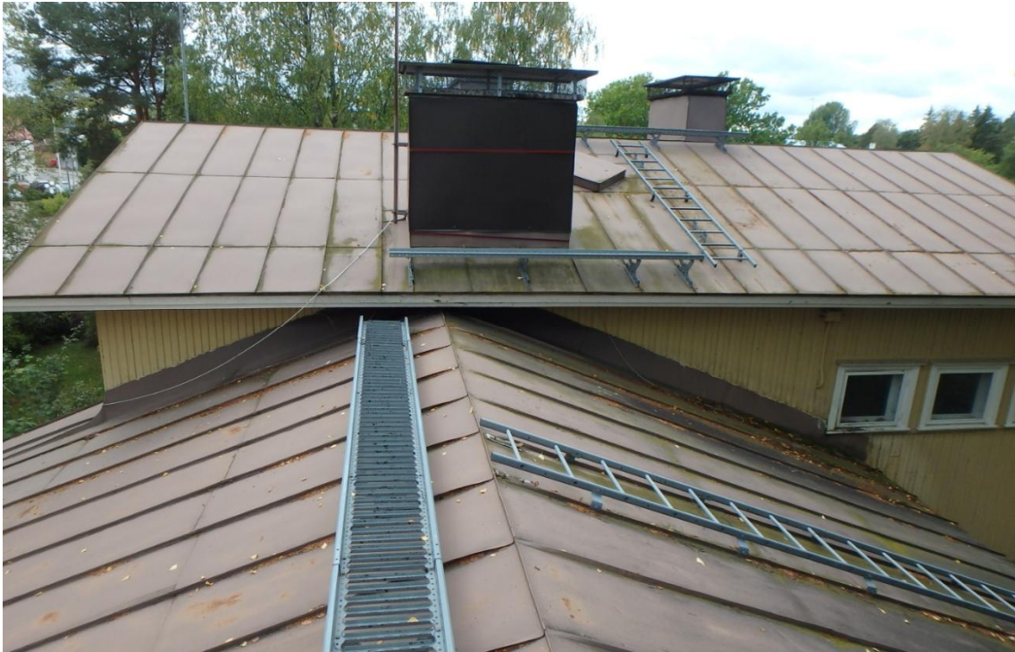
Kuva 21. Katon kulkusillat ovat hyvässä kunnossa ja kulkusillat ovat kiinnitetty katon saumoihin.
