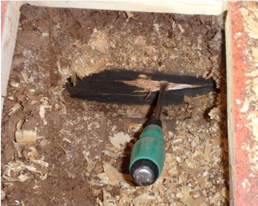
Kuva 12. Toisen kerroksen välipohjan kantava puupalkki on mustunut. Puuainees on pehmennyt, ruuvimeisseli uppoaa 10-20 mm palkin sisään.
