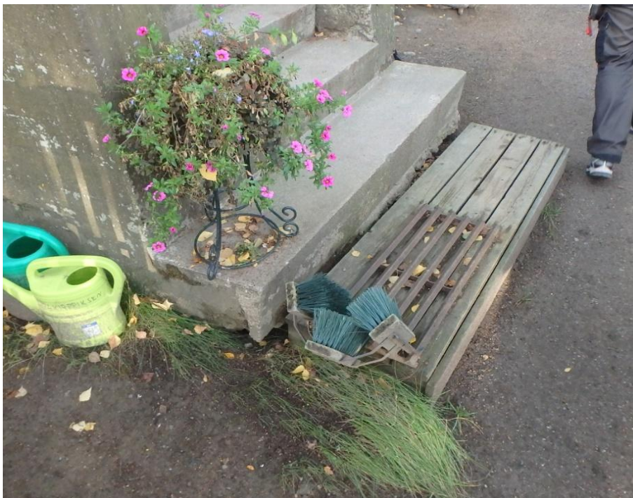
Kuva 5. Maanpinta on painunut portaiden edustalta. Edustalle on jouduttu rakentamaan puinen lisäporras.
