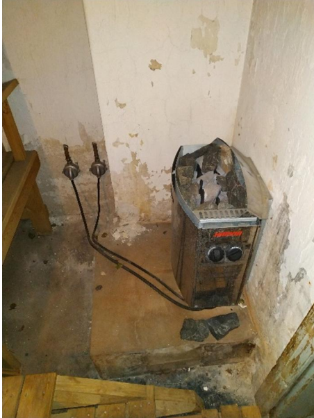
Kuva 43. Kiukaan kivimäärä on liian pieni ja osa vastuksista on näkyvissä. Seinässä alkuperäiset liitännät.
