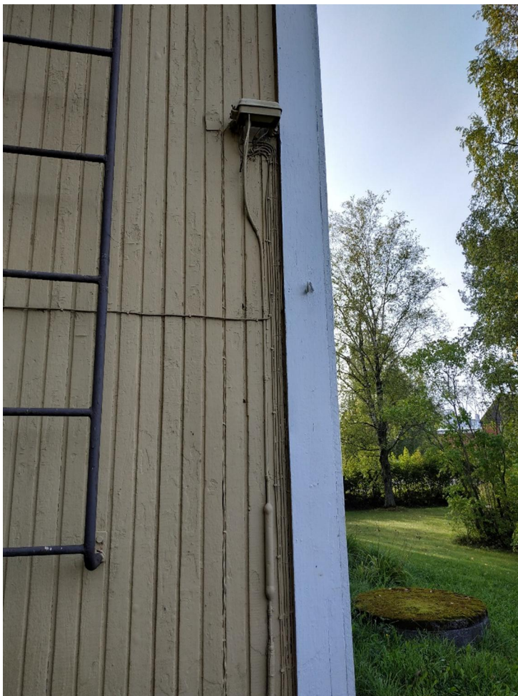
Kuva 33. Puhelintalokaapelin kytkentärasia julkisivussa.
