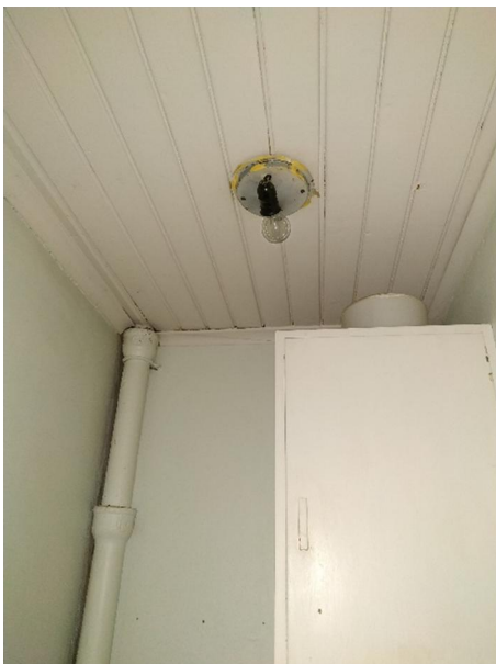
Kuva 39. Toisen kerroksen yhdestä kattovalaisimesta puuttuu suojakupu.
