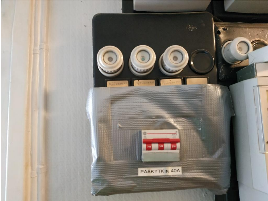
Kuva 34. Pääkeskuksen pääkytkinosan kosketussuojauksen puutteellinen korjaus ilmastointiteipillä.
