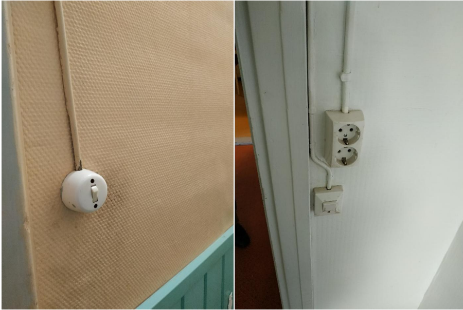
Kuva 40 ja 41. Alkuperäinen ja jossain vaiheessa uusittu valaistuksenohjauskytkin. Kuvassa 40 myös uusittu pistorasia.
