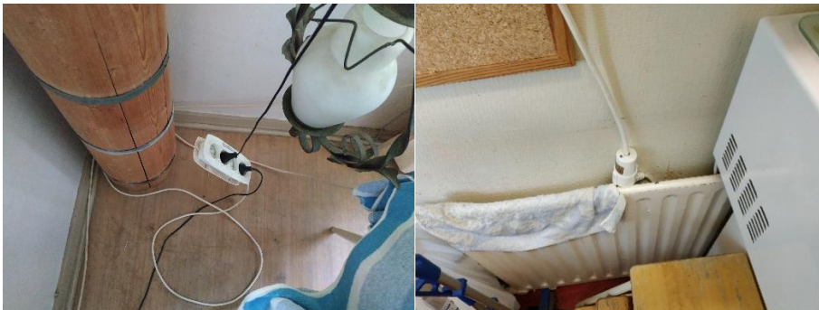
Kuvat 44 ja 45. Pistorasioiden vähäinen määrä ja niiden epäedullinen sijainti nykyiseen käyttötarkoitukseen nähden aiheuttaa jatkojohtojen käyttöä.
