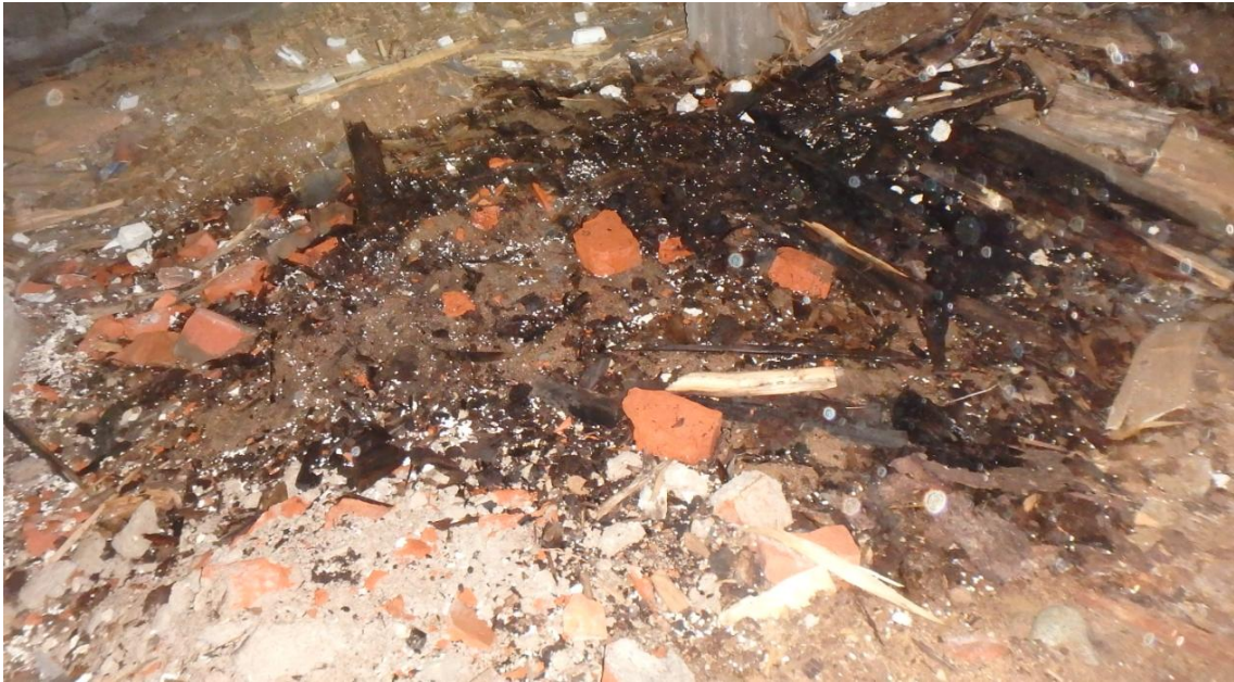
Kuva 10. Alapohjan muuten kuiva maa oli märkä vesivuodon kohdalla.
