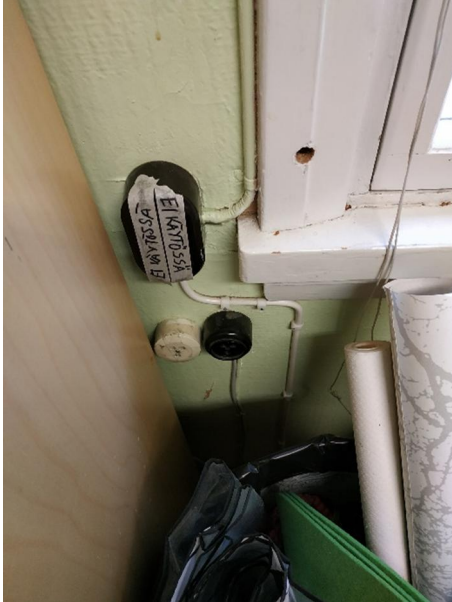
Kuva 36. Vaurioitunut pistorasia on korkauksen/uusimisen sijaan peitetty teipillä kirpputorin toimistossa. Pistorasian alapuolella perinteisen puhelinverkon pistorasioita.
