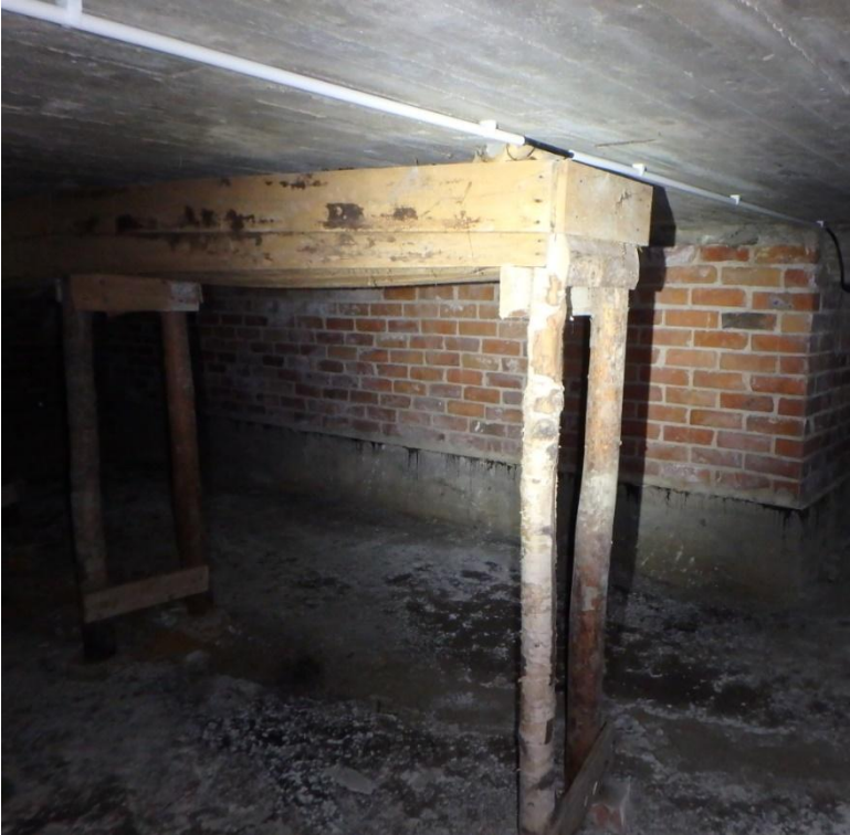
Kuva 27. Alapohjatilassa olevat vesi ja viemäriputket ovat tuettu maasta.
