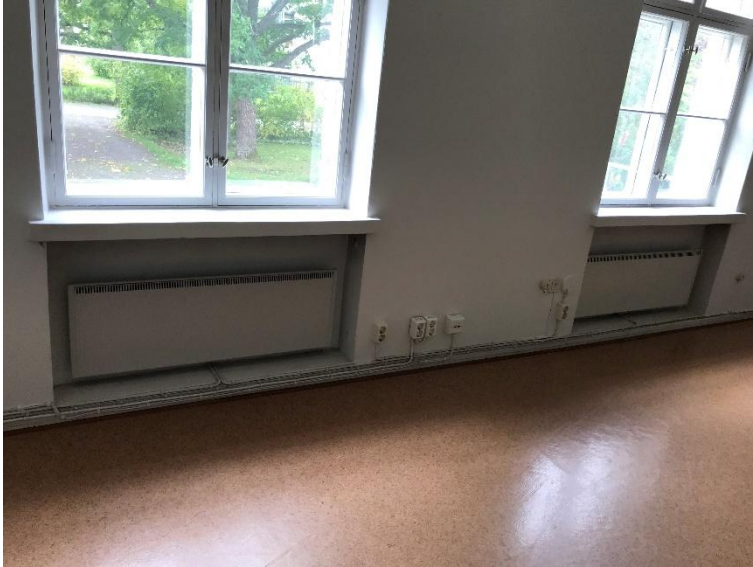
Kuva 23. Kohteen lämmitys toteutettu sähköpattereilla.
