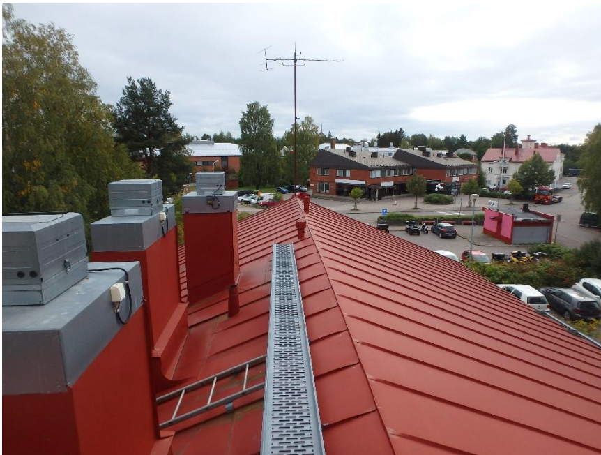
Kuva 36. Poistopuhaltimien turvakytkimiltä puuttuvat lumisuojat ja laitetunnukset puuttuva. Taustalla kohteen terestiaaliantenni TV- signaalin vastaanottoa varten.
