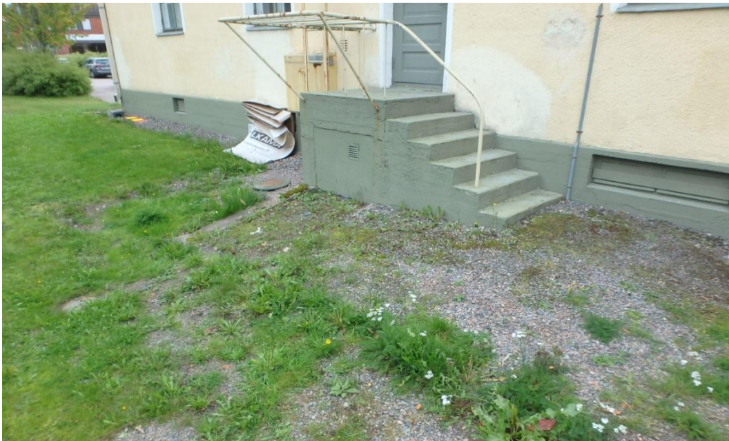
Kuva 6. Rakennuksen takaportaat. Kellarin sisäänkäynti on täytetty osittain maalla.
