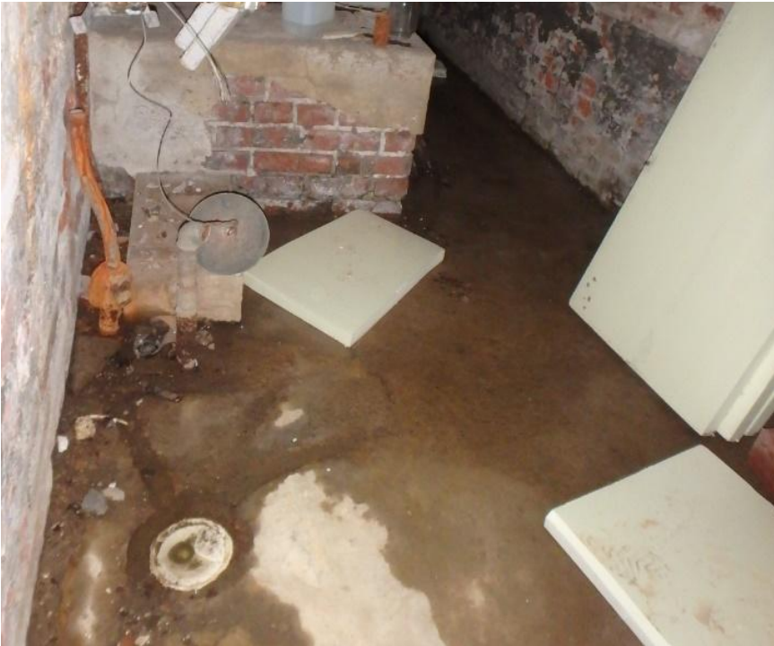
Kuva 13. Kellarin lattialla havaittiin vettä.
