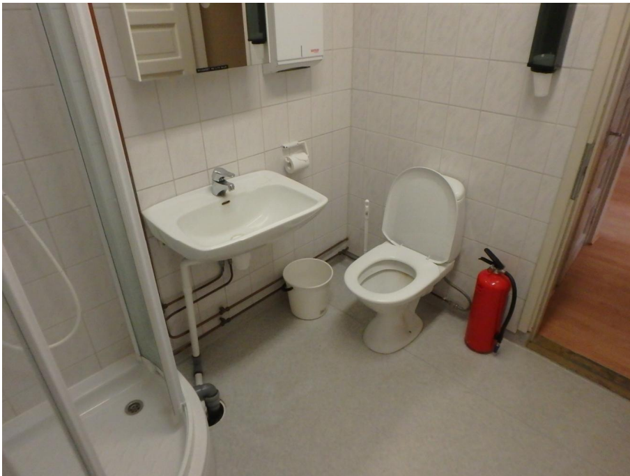
Kuva 22. Kylpyhuoneen kalusteet ovat hyvässä kunnossa.
