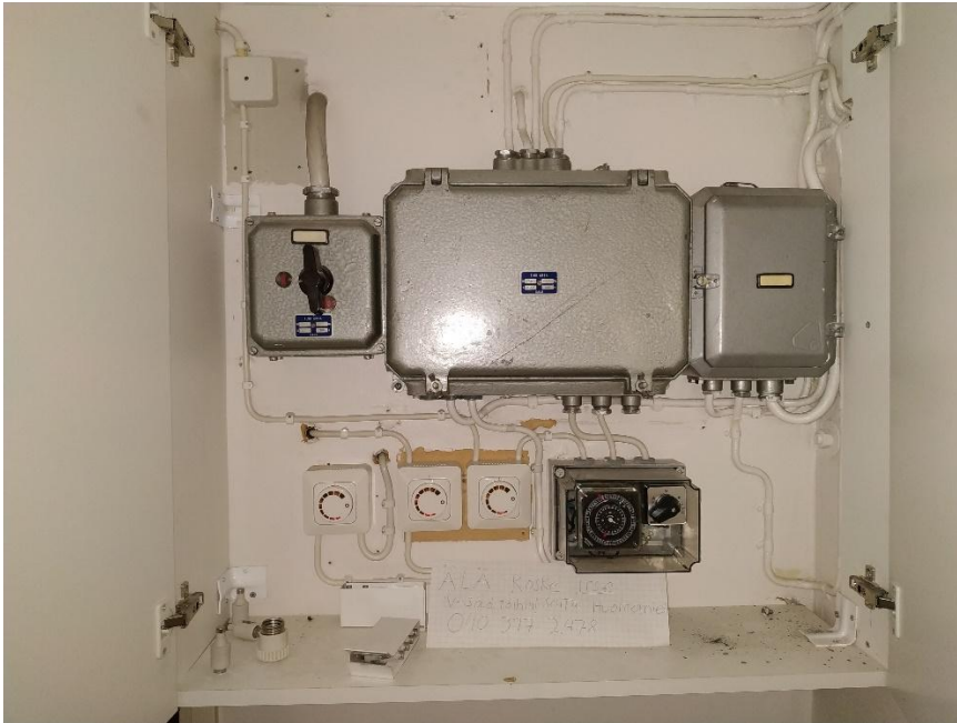
Kuva 35. Kiinteistön toinen ryhmäkeskus sekä poistopuhaltimien säätimiä 2. kerroksessa.
