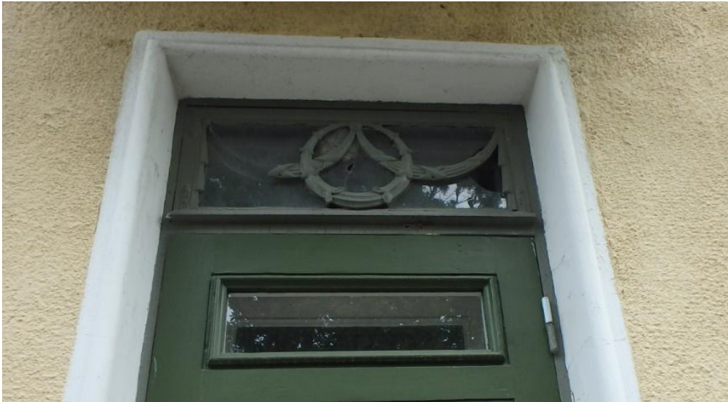
Kuva 11. Toisen etuoven päällä oleva lasi on rikki.
