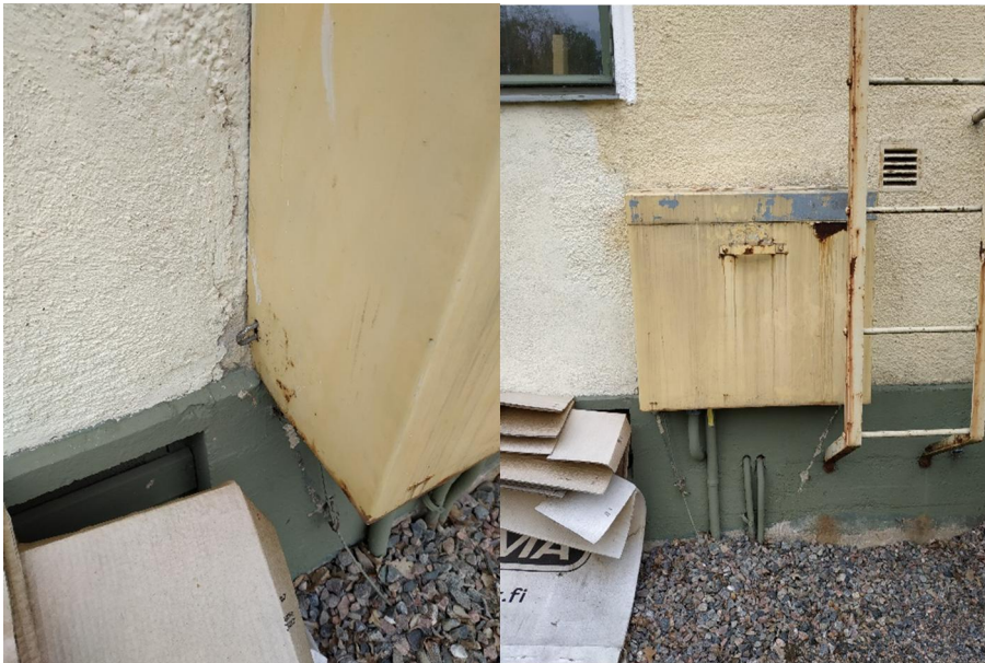
Kuvat 31 ja 32. Nousukeskuksen suojakotelosta puuttuu lukitus ja kotelo on suhteellisen helposti avattavissa. Sen jälkeen on esteetön pääsy jännitteisiin osiin avattavien keskuskansien kautta. Kotelossa ei ole varoitusta sähköiskun vaarasta.
