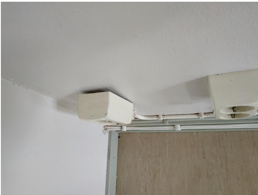
Kuva 38. 1. kerroksessa muutamien pistorasioiden kiinnitys oli puutteellinen.
