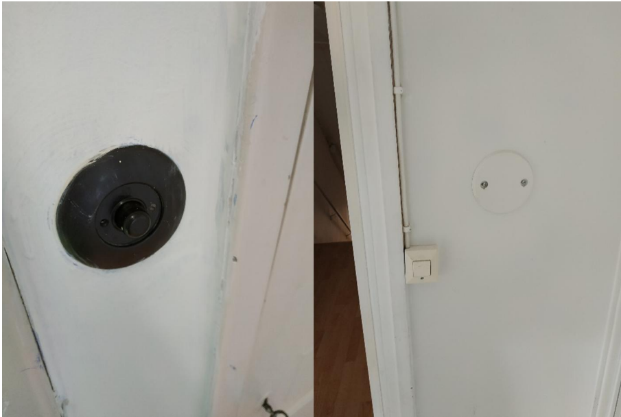
Kuvat 41 ja 42. Vasemmalla alkuperäinen valaistuksenohjauspainike 1. kerroksessa, oikealla uusittu kytkin 2. kerroksessa.
