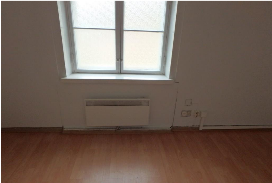
Kuva 19. Ulkoseiniin on paikoin lisätty huokoinen puukuitulevy. Patterisyvennykset on ummistettu
