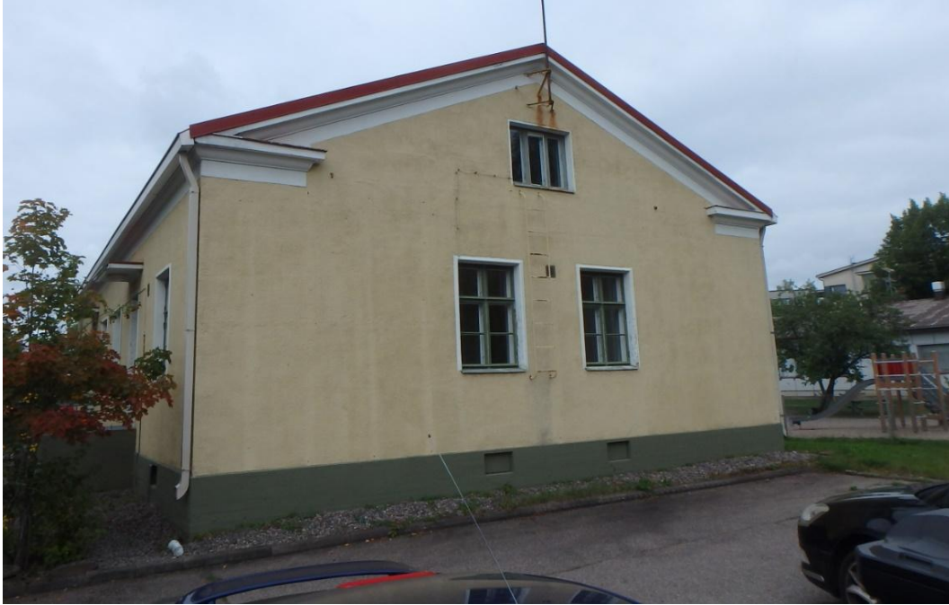
Kuva 5. Rakennuksen kaakon puoleinen pääty. Etelänurkasta puuttuu loiskekuppi. Sokkelin vierustalla on salaojasoraa.
