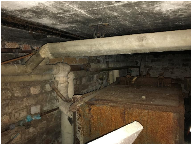
Kuva 26. Vanha öljykattila, lämmitysputkia ja eristeitä kellarissa
