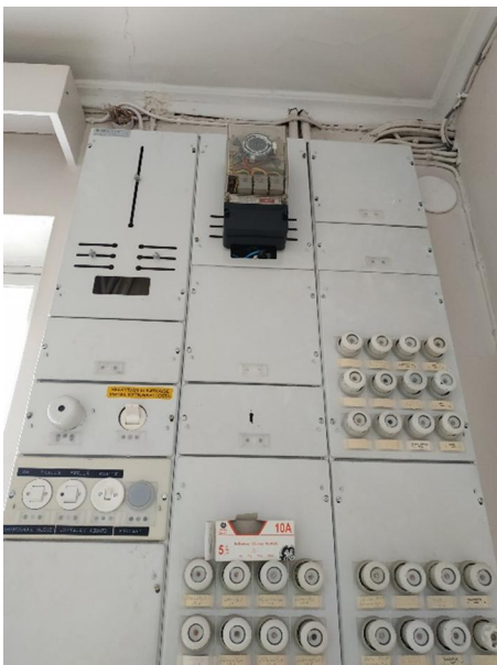
Kuva 34. Kiinteistön ryhmäkeskus 1. kerroksessa.
