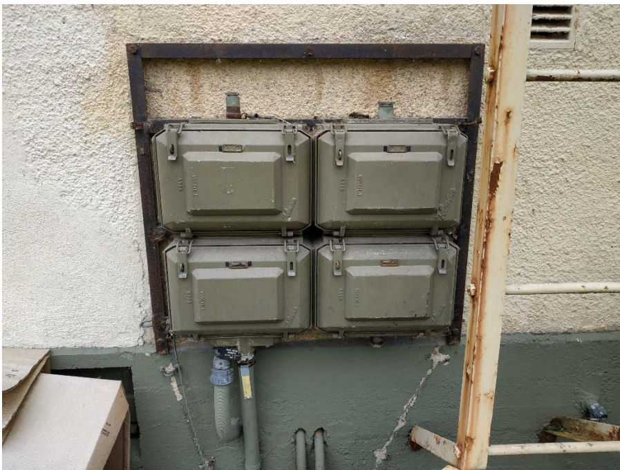
Kuva 29. Kohteen nykyinen nousukeskus takapihan puoleisella julkisivulla.
