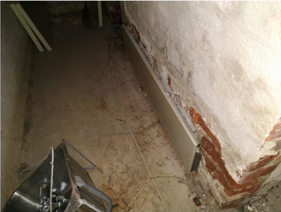
Kuva 39. Ikääntynyt sähkölämmitin kellarikerroksessa.
