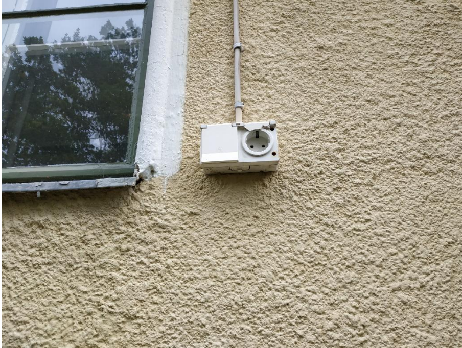
Kuva 37. Etupihan julkisivussa olevan pistorasian toinen peitekansi puuttuu.
