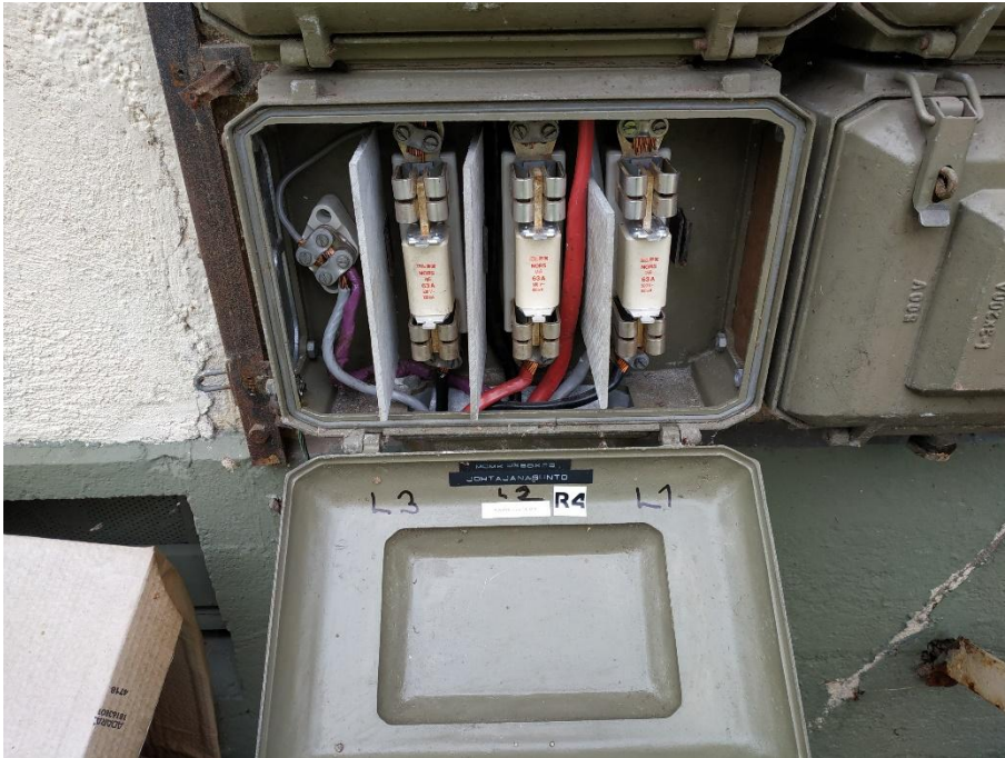
Kuva 30. Kiinteistön nykyiset päävarokkeet. Kansi avautuu helposti ilman työkaluja.
