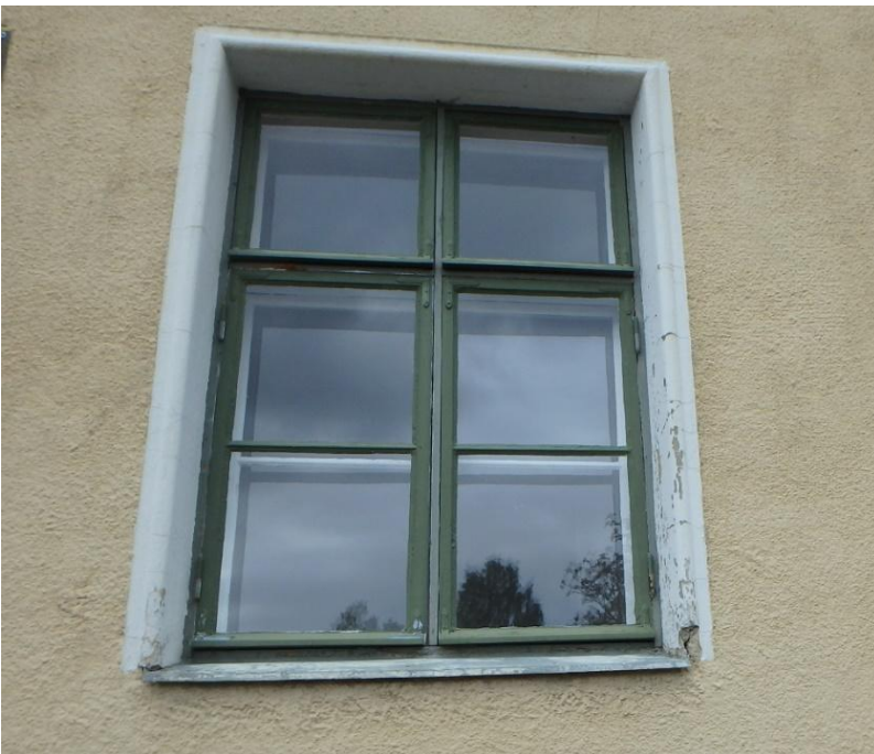
Kuva 8. Ikkunapeltien maalipinnat hilseilevät. Ikkunapielen rappaukset ovat rapautuneet ikkunapellin liitosten kohdalta.
