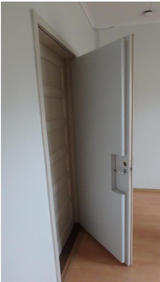
Kuva 18. Välioviin on lisätty akustista materiaalia.
