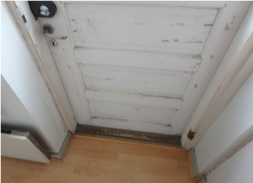
Kuva 12. Takaovesta puuttuu ns. tuulikaapin ovi. Oven sisäpinnan maalit hilseilevät.
