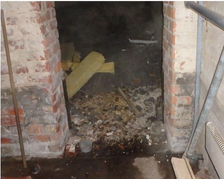
Kuva 14. Kellarin ja alustatilan välillä ei ole erillistä ovea.
