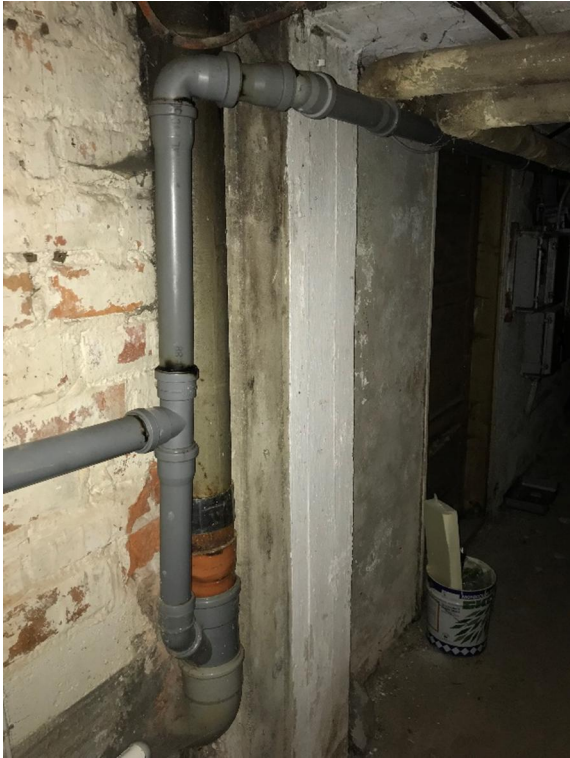
Kuva 25. Muovisia ja valurautaisia jätevesiviemäreitä kellarissa.
