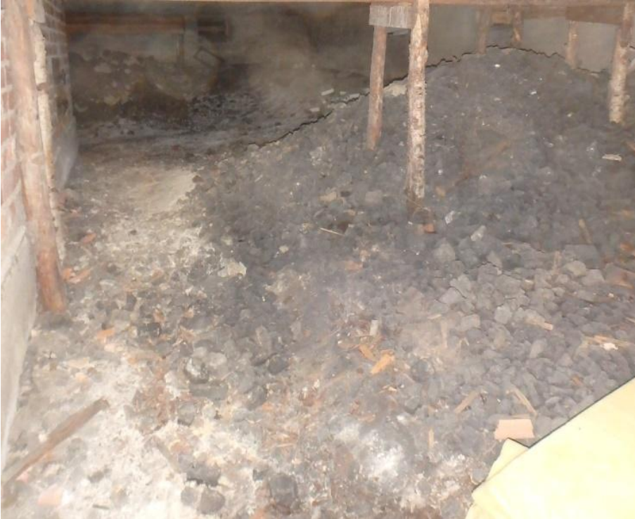
Kuva 15. Alustatilassa on kivihiiltä yms. jätettä.
