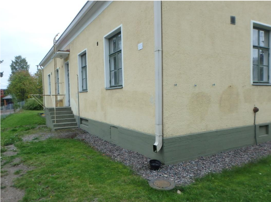
Kuva 7. Rakennuksen ympärille on asennettu sadevesikaivot ja loiskekupit. Salaojia ei havaittu, tai ne ovat yhdistetty sadevesikaivoihin, jolloin ne saattavat kastella sateella rakennuksen perustusta.
