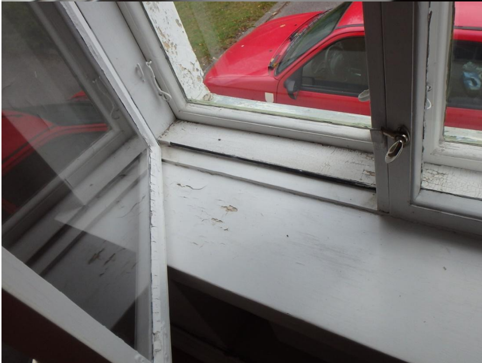
Kuvat 9 ja 10. Puuikkunoiden ikkunaruutujen, ikkunapenkkin ja vesipeltien maalit hilseilevät. Lasikittaukset ovat halkeilleet.
