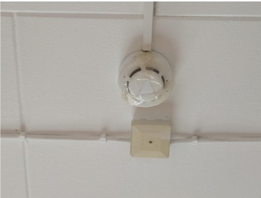
Kuva 40. Paloilmaisin on teipattu yhdessä 1. kerroksen huoneessa.
