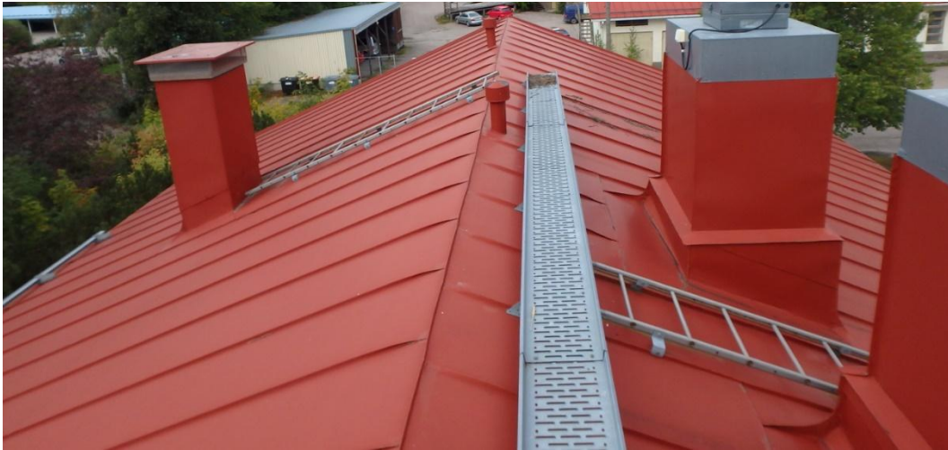
Kuva 17. Vesikate ja kulkusillat ovat hyväkuntoiset.
