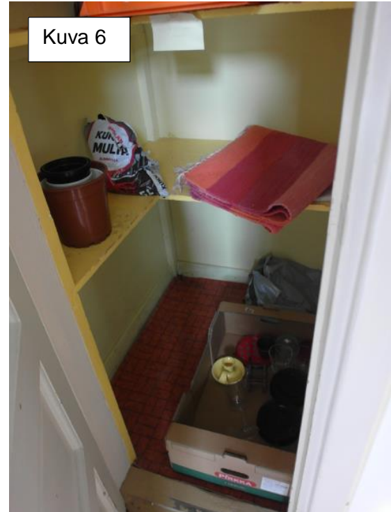
Kuva 6. V Keittiön komerossa ja eteisessä on punainen muovimatto (ja/tai liima), joka sisältää asbestia. Tarkkaa määrää ja sijaintia ei ole voitu arvioida, mattoa saattaa olla muuallakin uudempien pintamateriaalien alla.
