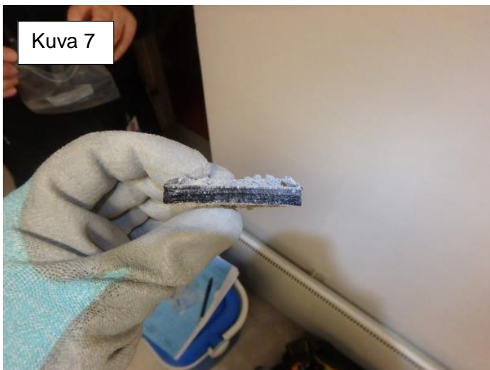
Kuva 7. Ullakkokerroksessa on aiemmin ollut sauna ja pesuhuone, jotka on myöhemmin purettu. Väli-pohjarakenteessa on näiden entisten märkätilojen kohdalla pikieriste, joka sisältää asbestia.
