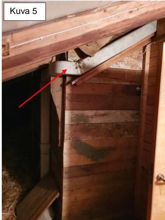
Kuva 5. Ullakkokerroksessa ja on näkyvillä Mica-kanavaa, joka sisältää asbestia. Kanavaa on myös nousuputkina 1. kerroksen ja ullakon välipohjassa. Tarkkaa määrää ja sijaintia ei ole voitu arvioida.
