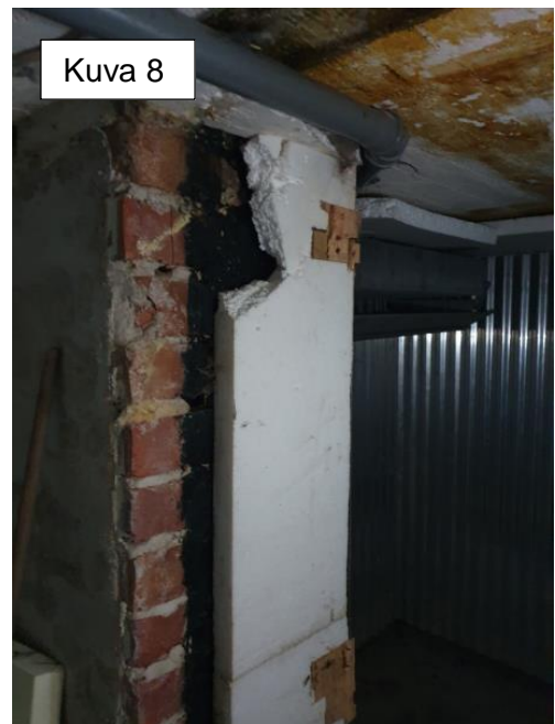
Kuva 8. Kellarin seinien pikisiveily sisältää asbestia ja yli 200 mg/kg PAH-yhdisteitä.
