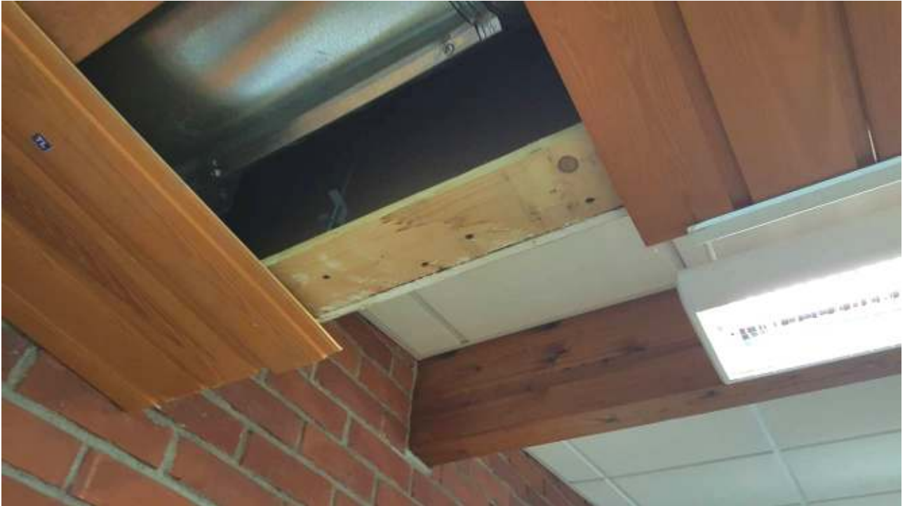
Kuva 13. Yleiskuva tutkimuspaikasta. Alaslaskun runkokuuussa on veden valumajälkiä, joita todettiin myös paneelien taustassa.
