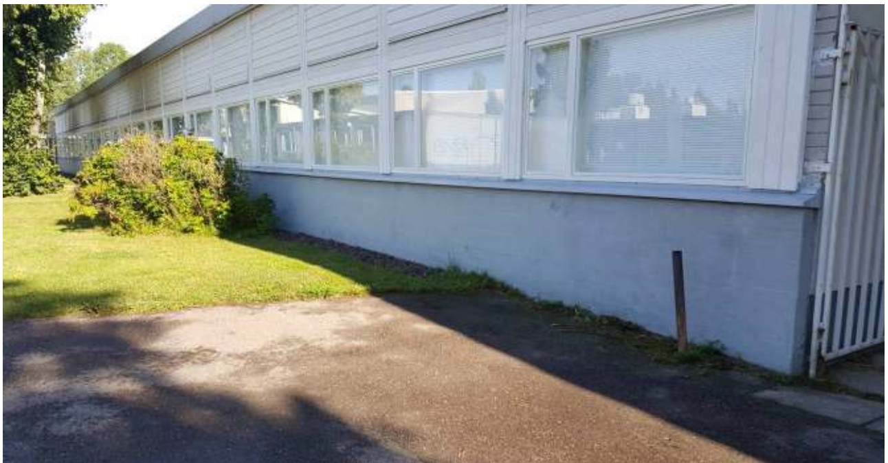
Kuva 31. Rakennuksen päädyssä (opetus-/luokkatilat 179-186) kasvillisuus on kiinni sokkelissa / julkisivussa aiheuttaen ylimääräistä kosteusrasitusta rakenteille. Maanpinnan kallistukset ovat paikoin puutteellisia.
