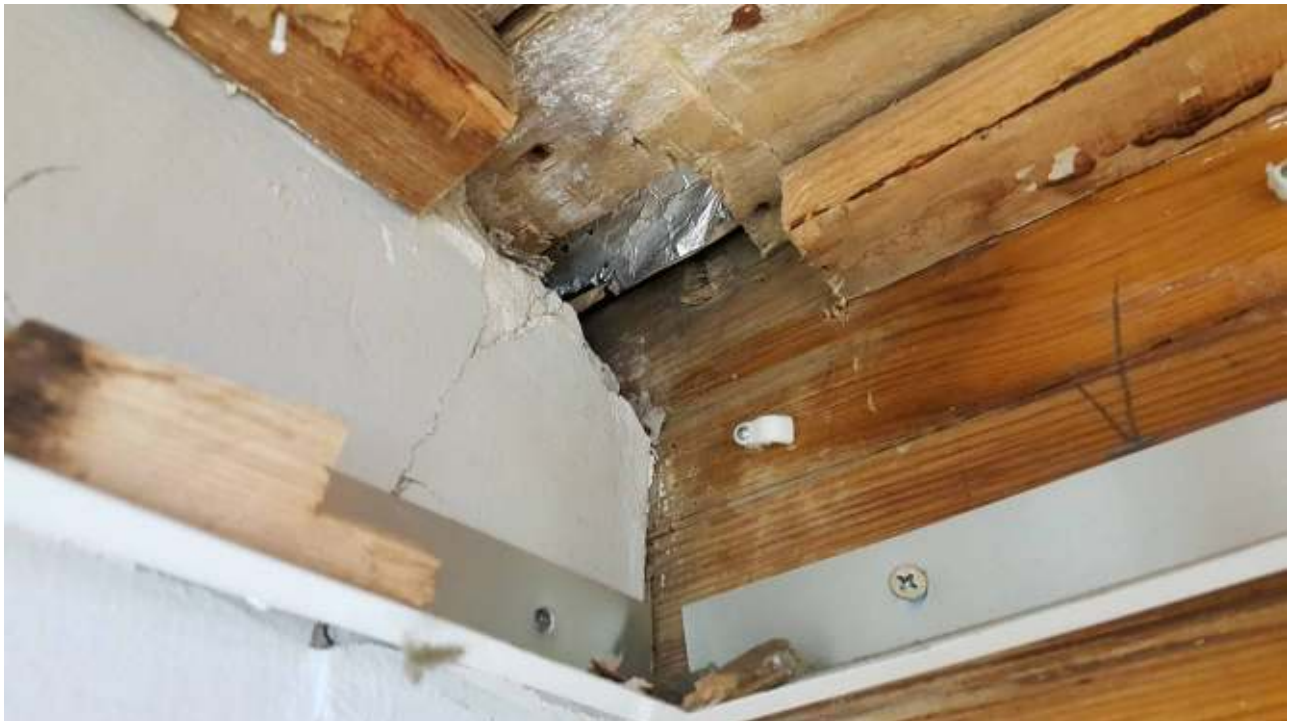
Kuva 20. Yläpohjan koolauspuut ovat kosteus- ja mikrobivaurioituneet liimapuupalkin vierustalla.
