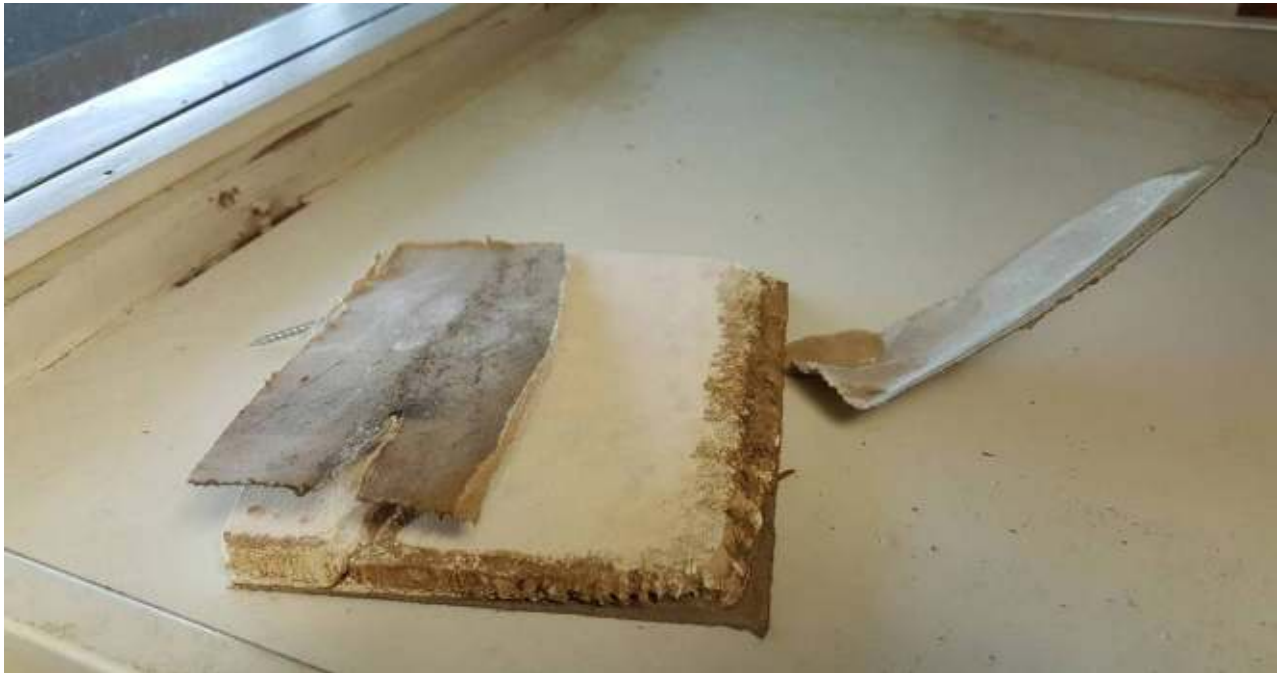
Kuva 15. Kipsilevy on kosteus- ja mikrobivaurioitunut. Kaapin päällä on vesivuotojälkiä.
