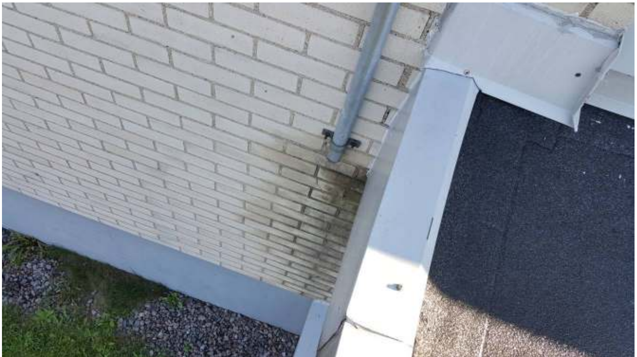
Kuva 30. Sadevesi pääsee valumaan tiiliseinälle. Suositellaan reunapeltien uusimista, uusi pelti muotoiltaan niin että se ohjaa sadeveden pois tiiliseinältä.
