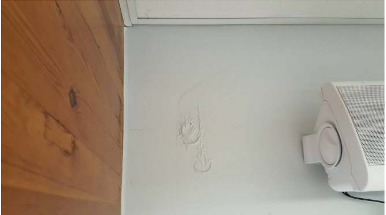
Kuva 21. Liimapuupalkin toisella puolella maalipinta on vaurioitunut vuotovesien johdosta.
