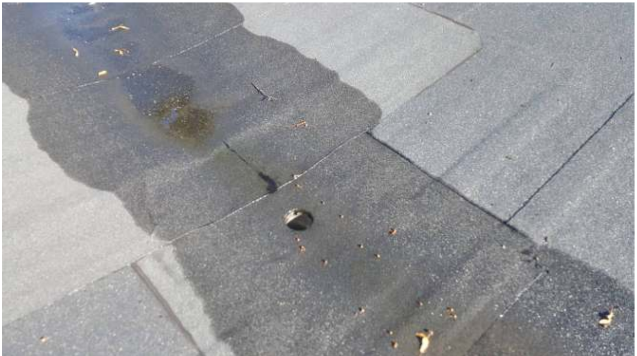
Kuva 28. Kattokaivon siivilä puuttuu. Suositellaan siivilän asentamista, ilman siivilää on mahdollista että sadevesiviemäri tukkeutuu puiden lehdistä.
