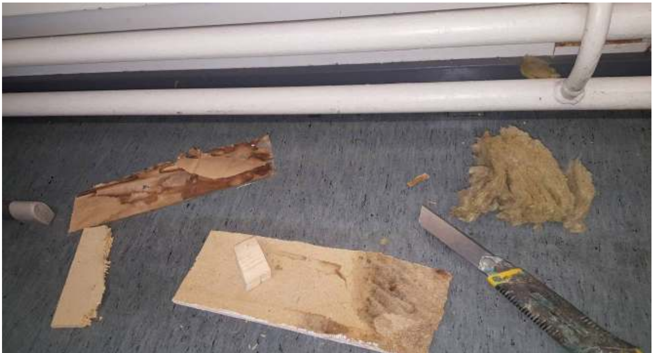
Kuva 5. Ilmansulkupaperin taustassa on vesivuotojälkiä. Lastulevyn taustassa on kosteus- ja mikrobivaurio.
