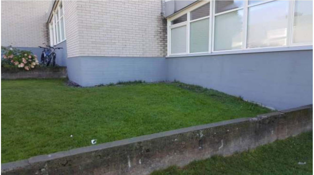
Kuva 34. Rakennus sijaitsee rinteessä, tilojen lattiapinnat ovat paikoin maanpinnan tasossa/hieman maanpintaa alempana. Maanpinnan kallistukset ovat paikoin puutteellisia. Betonisokkeli ulottuu ikkunoiden alareunan tasolle.
