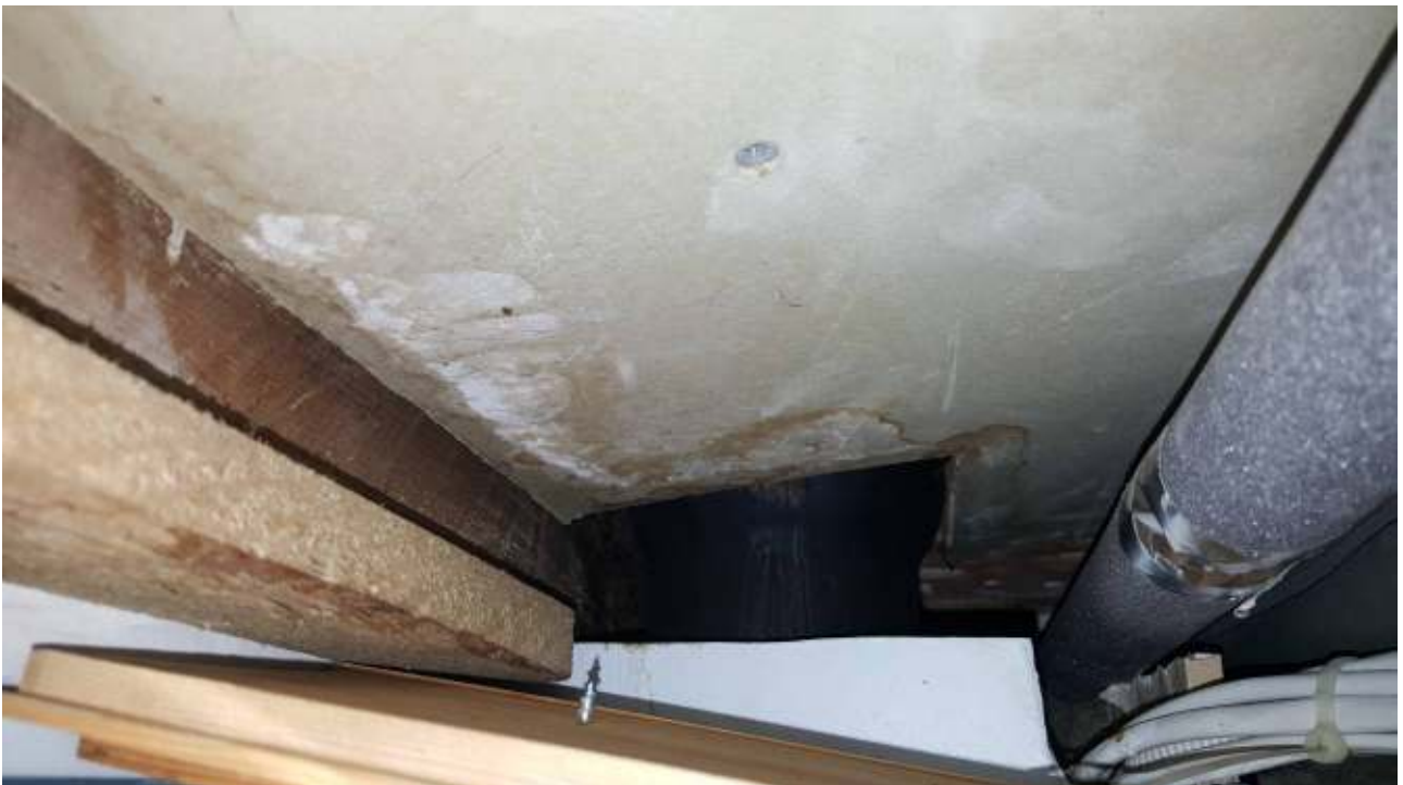
Kuva 14. Nurkassa on sadevesiviemärin poistoputki. Katon kipsilevyssä on vesivuotojälkiä. Sadevesiviemärin läpiviennin kohdalta havaittiin voimakas ilmavirtaus luokkatilaan merkkisavun avulla.
