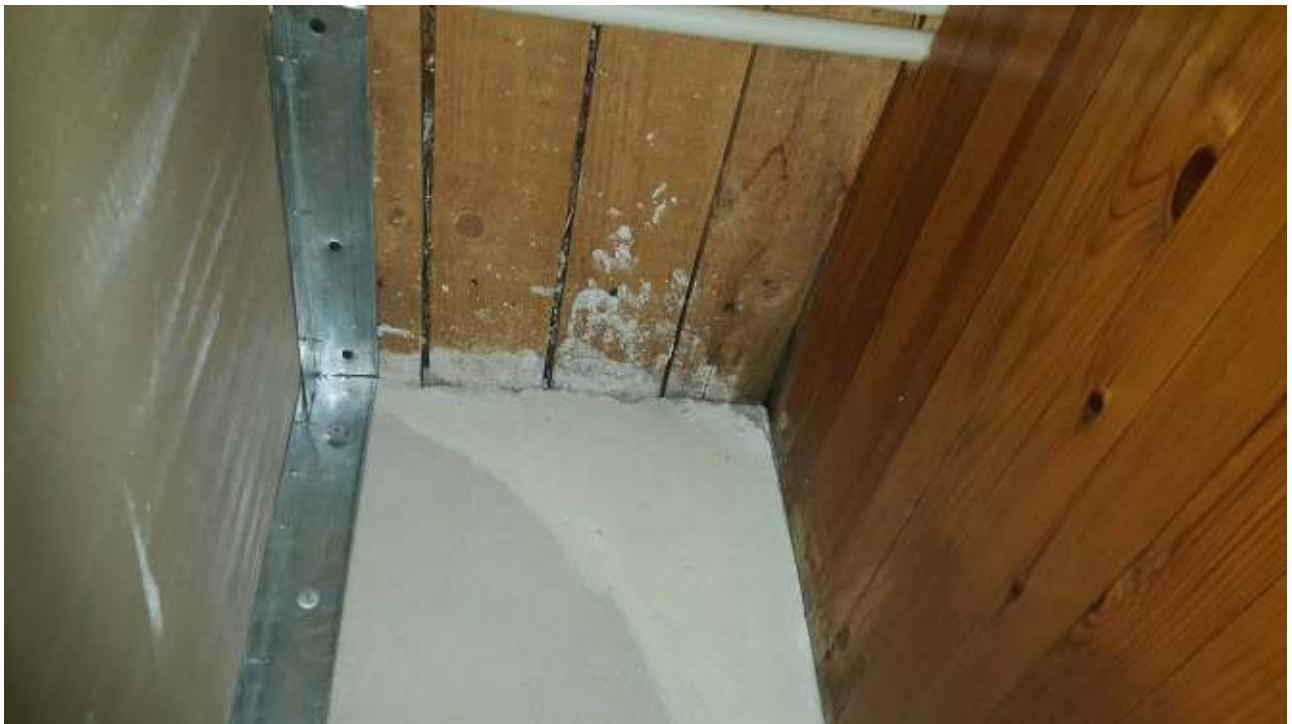
Kuva 22. Yleiskuva luokkatilan käytävän alaslaskutilasta. Yläpohjan koolauspuussa on vesivuotojälkiä.
