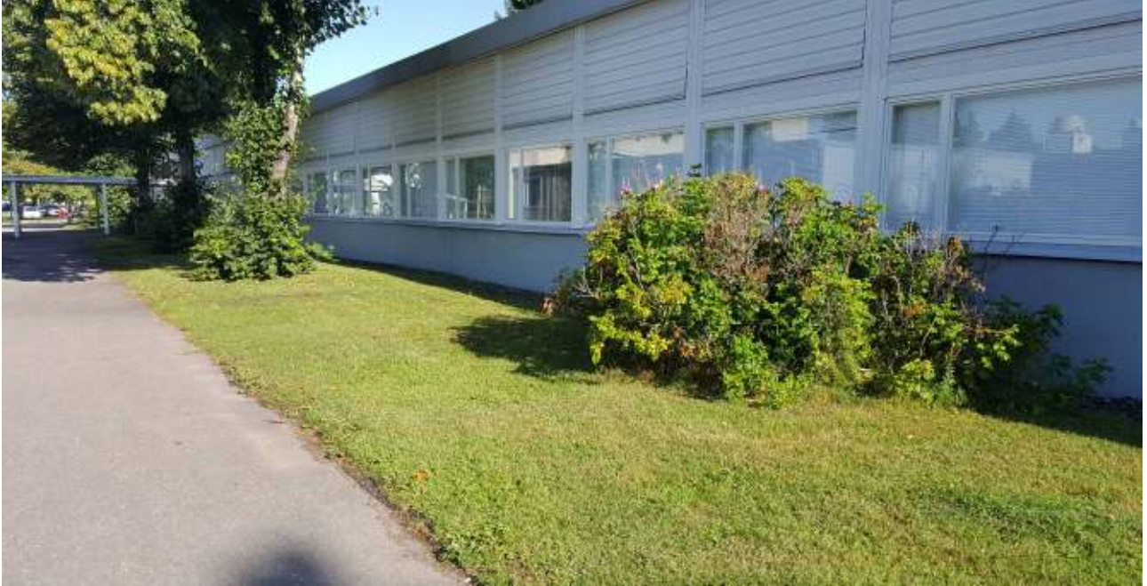
Kuva 32. Rakennuksen päädyssä (opetus-/luokkatilat 179-186 kohdalta) kasvillisuus on kiinni sokkelissa / julkisivussa aiheuttaen ylimääräistä kosteusrasitusta rakenteille. Maanpinnan kallistukset ovat paikoin puutteellisia.
