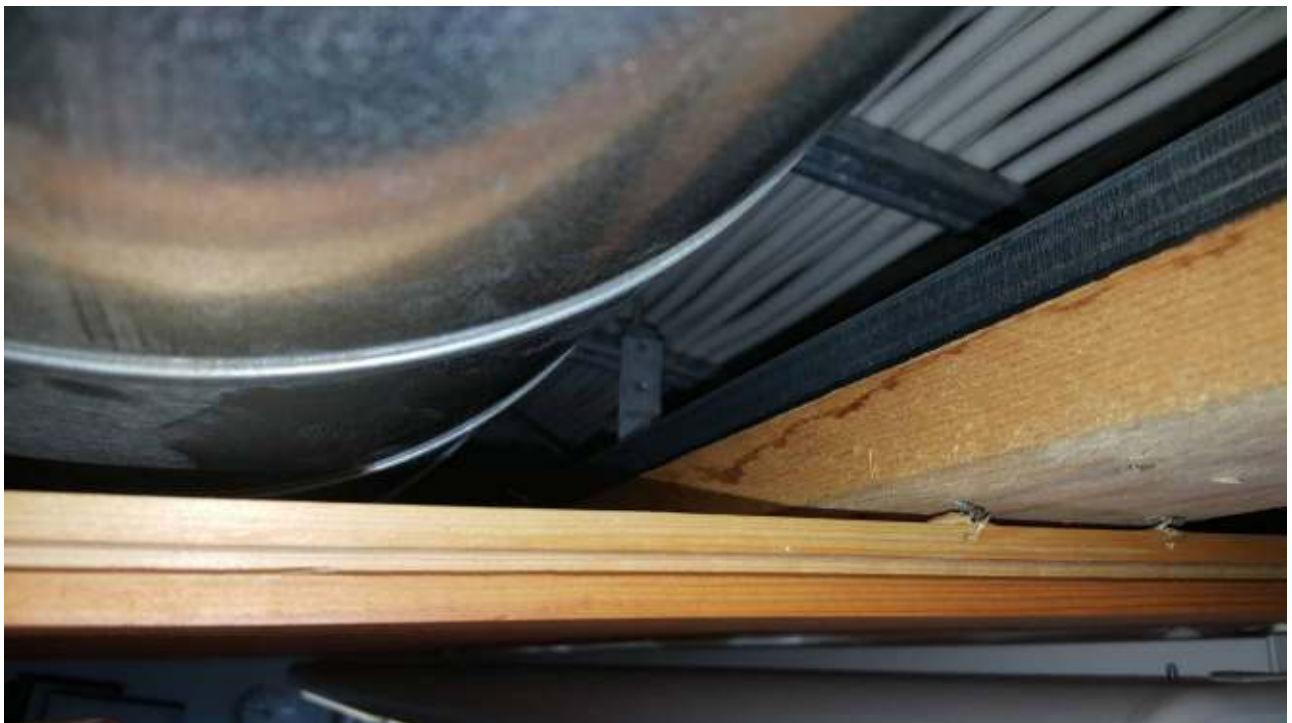
Kuva 18. Alaslaskun runkokuussa on veden valumajälkiä.
