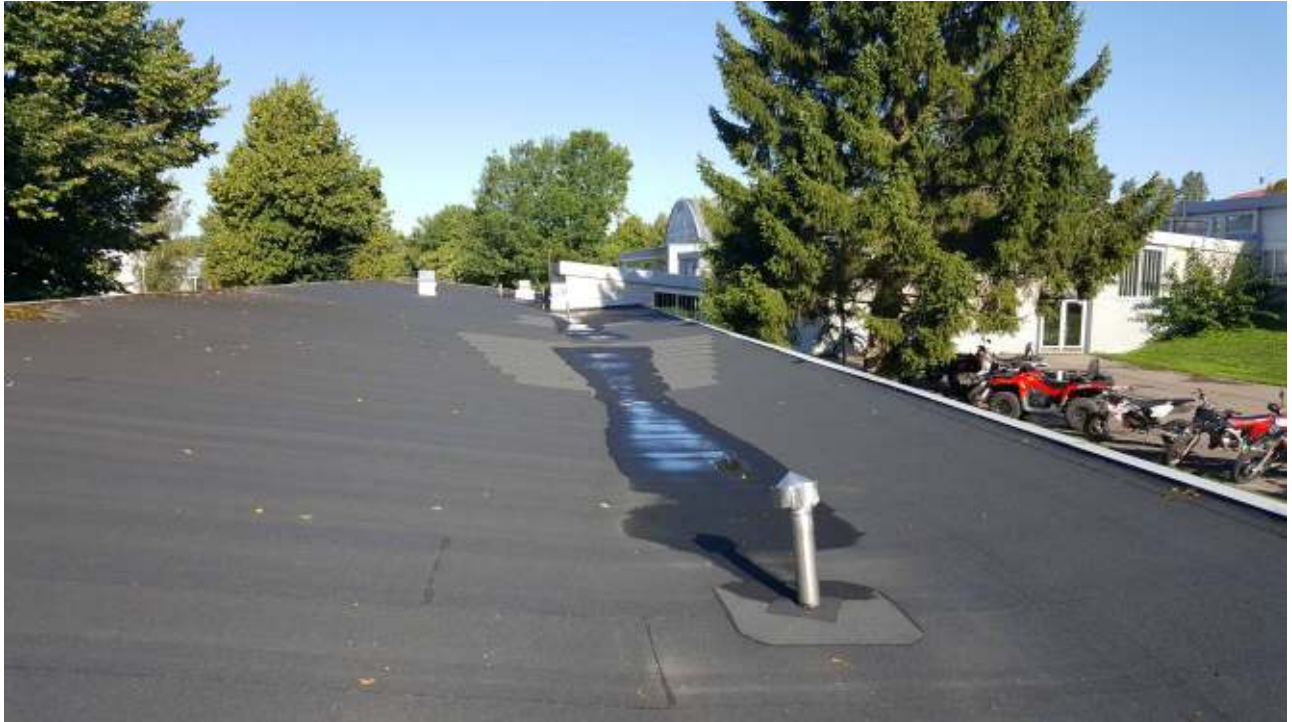
Kuva 25. Yleiskuva vesikatolta, alla opetus-/luokkatilat 179-186. Vesikatetta on paikkakorjattu jollain aikavälillä.
