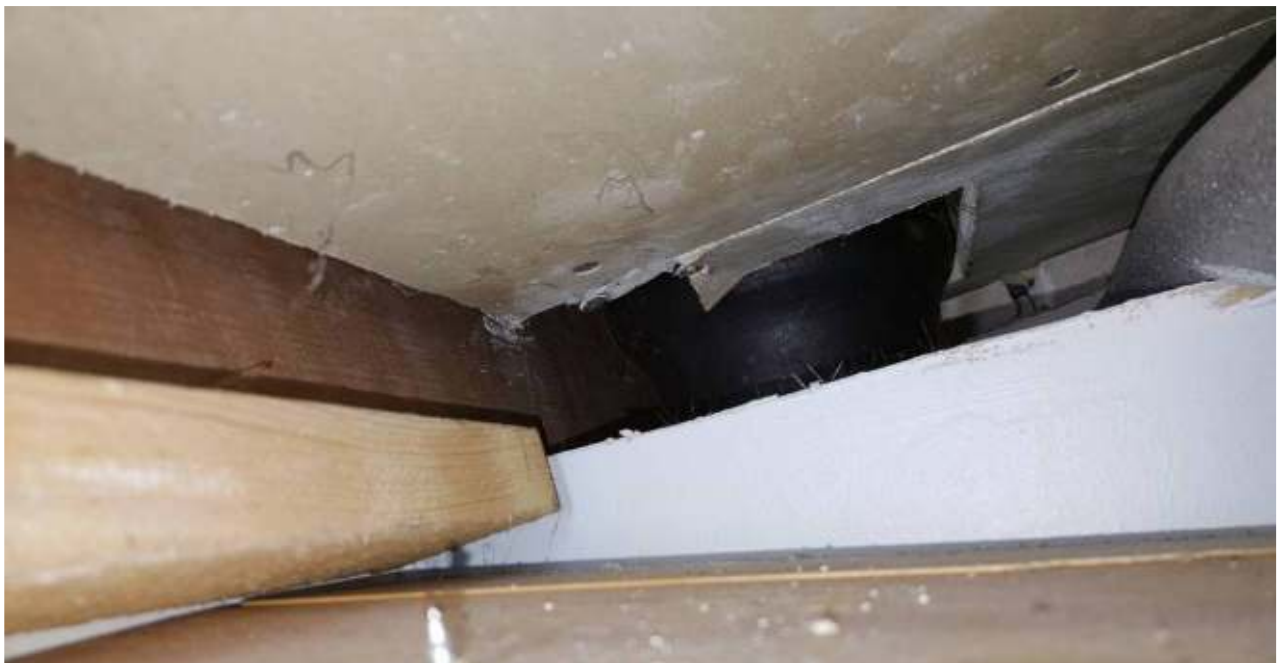
Kuva 16. Nurkassa on sadevesiviemärin poistoputki. Kipsilevyn reunassa on vesivuotojälkiä. Sadevesiviemärin läpiviennin kohdalta havaittiin voimakas ilmavirtaus luokkatilaan merkkisavun avulla.
