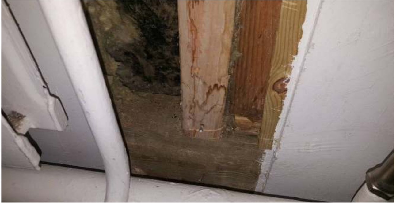
Kuva 2. Yleiskuva tutkimuspaikasta RA1. Pystyrunkopuussa on näkyvissä vesivuotojälkiä. Betonisokkelin taustapinnassa on bitumisively. Lämmöneristeet ovat kiinni betonisokkelissa.
