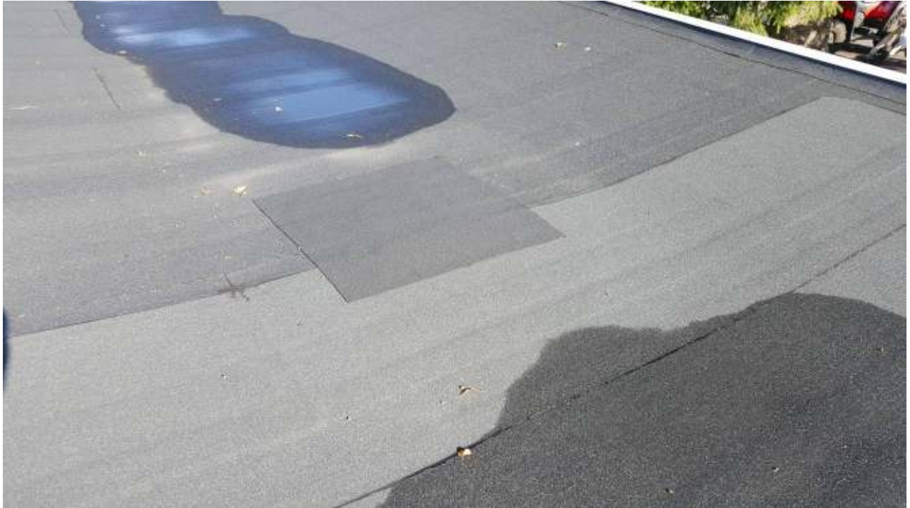
Kuva 29. Tuuletusputki on poistettu ja ko. kohta on paikkakorjattu. Suositellaan tuuletusputken asentamista yläpohjan tuuletuksen toimivuuden varmistamiseksi.
