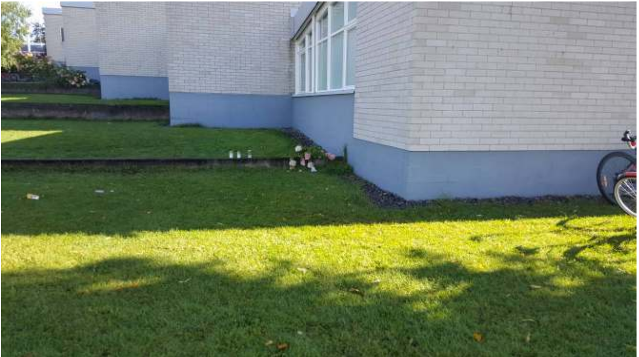
Kuva 33. Rakennus sijaitsee rinteessä, tilojen lattiapinnat ovat paikoin maanpinnan tasossa/hieman maanpintaa alempana. Maanpinnan kallistukset ovat paikoin puutteellisia. Betonisokkeli ulottuu ikkunoiden alareunan tasolle.
