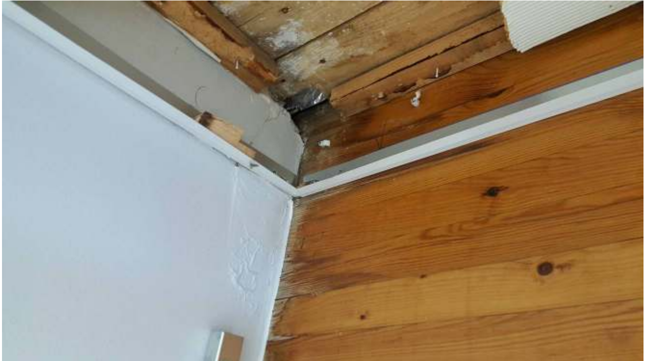
Kuva 19. Yleiskuva tutkimuspaikasta. Yläpohjan koolauspuut ovat kosteus- ja mikrobivaurioituneet liimapuupalkin vierustalla. Seinän maalipinta on vaurioitunut vuotovesien johdosta.
