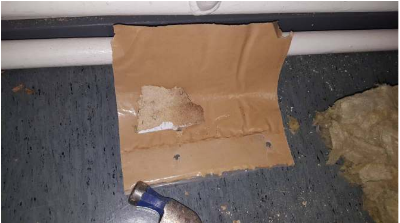
Kuva 7. Ilmansulkupaperin taustassa on vesivuotojälkiä. Lastulevyn taustassa on kosteus- ja mikrobivaurio.
