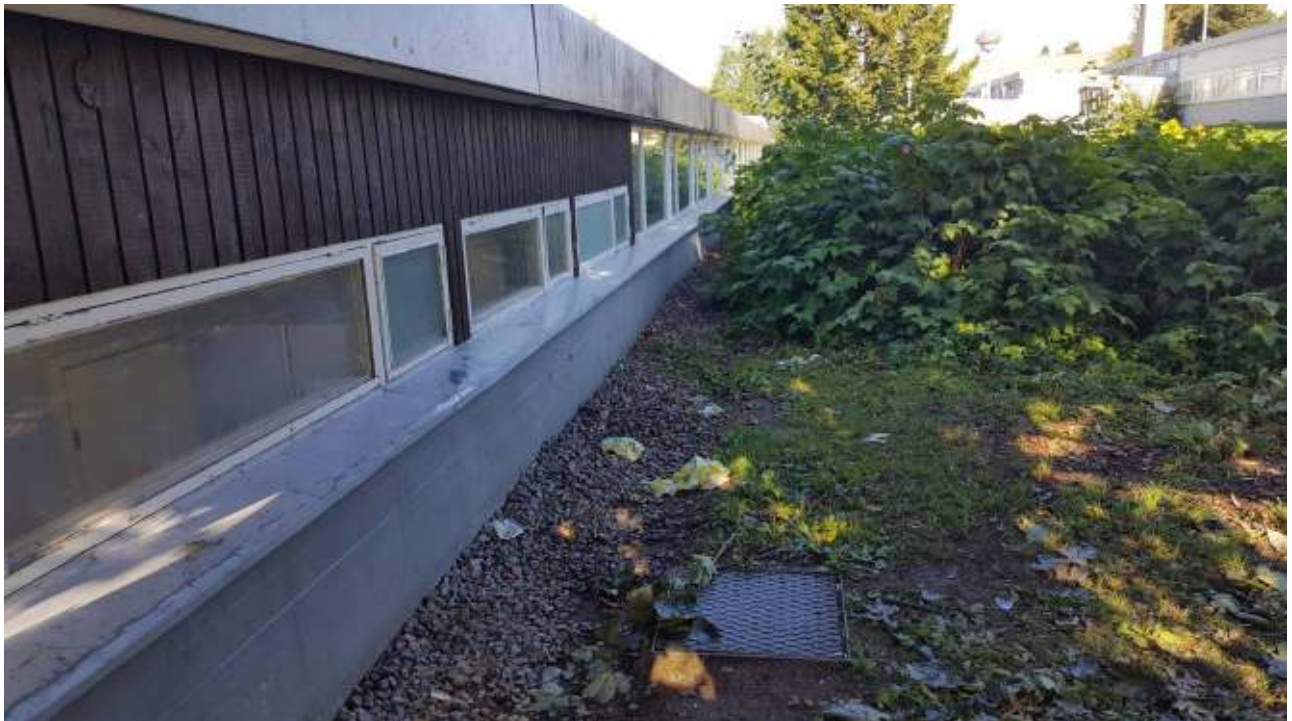
Kuva 35. Kuva ylärinteen puolelta (opetus-/luokkatilat 179-186 kohdalta). Maanpinnan kallistukset ovat paikoin puutteellisia. Betonisokkeli ulottuu ikkunoiden alareunan tasolle. Lattiataso on noin 2 metriä maanpinnan alapuolella. Sokkelin takana on levyverhottu pystypuurunko ja lämmöneristeet, rakenne on ns. riskirakenne.
