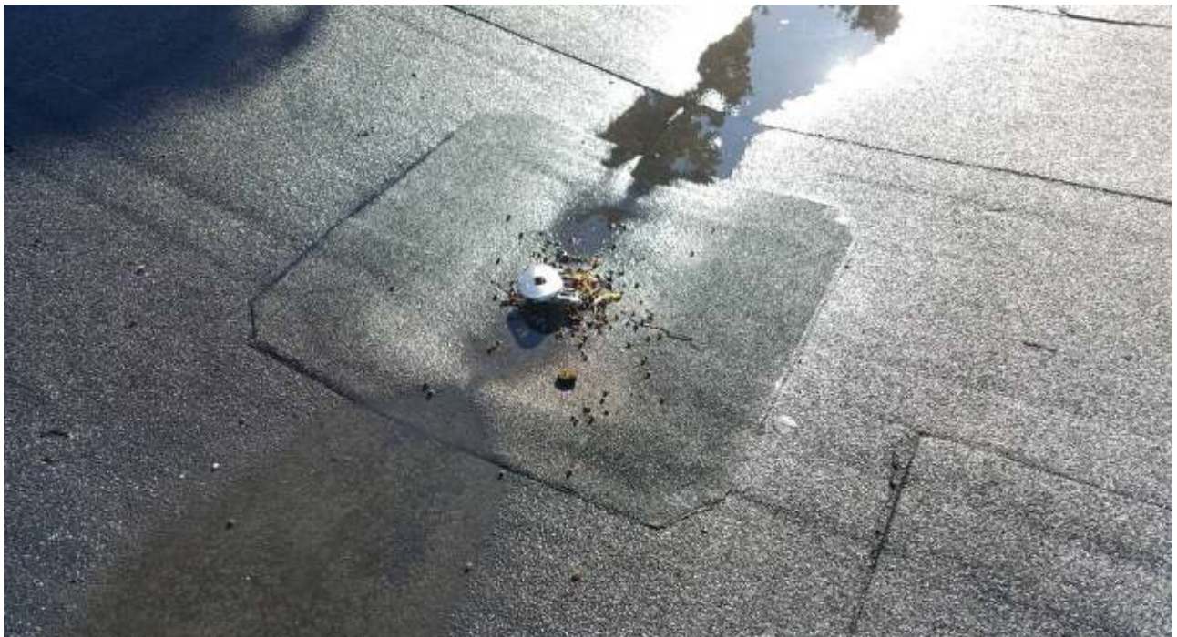
Kuva 26. Kattokaivon siivilä on vaurioitunut, siivilä tulisi uusia. Samalla tulee tarkistaa läpivientikapaleen tiiveys.
