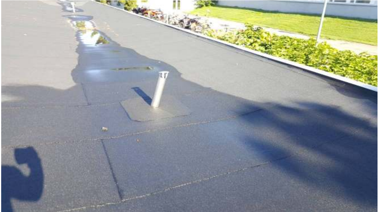
Kuva 27. Tuuletusputki on vääntynyt. Suositellaan putken uusimista, putkessa voi olla repeämä laipan alaosassa josta voi päästä vettä yläpohjaan.
