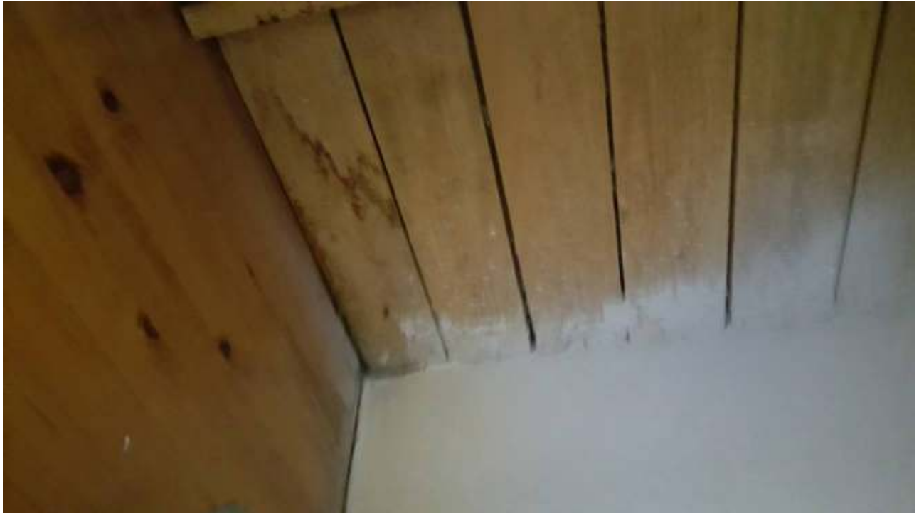
Kuva 23. Yleiskuva luokkatilan käytävän alaslaskutilasta. Yläpohjan koolauspuussa on vesivuotojälkiä.
