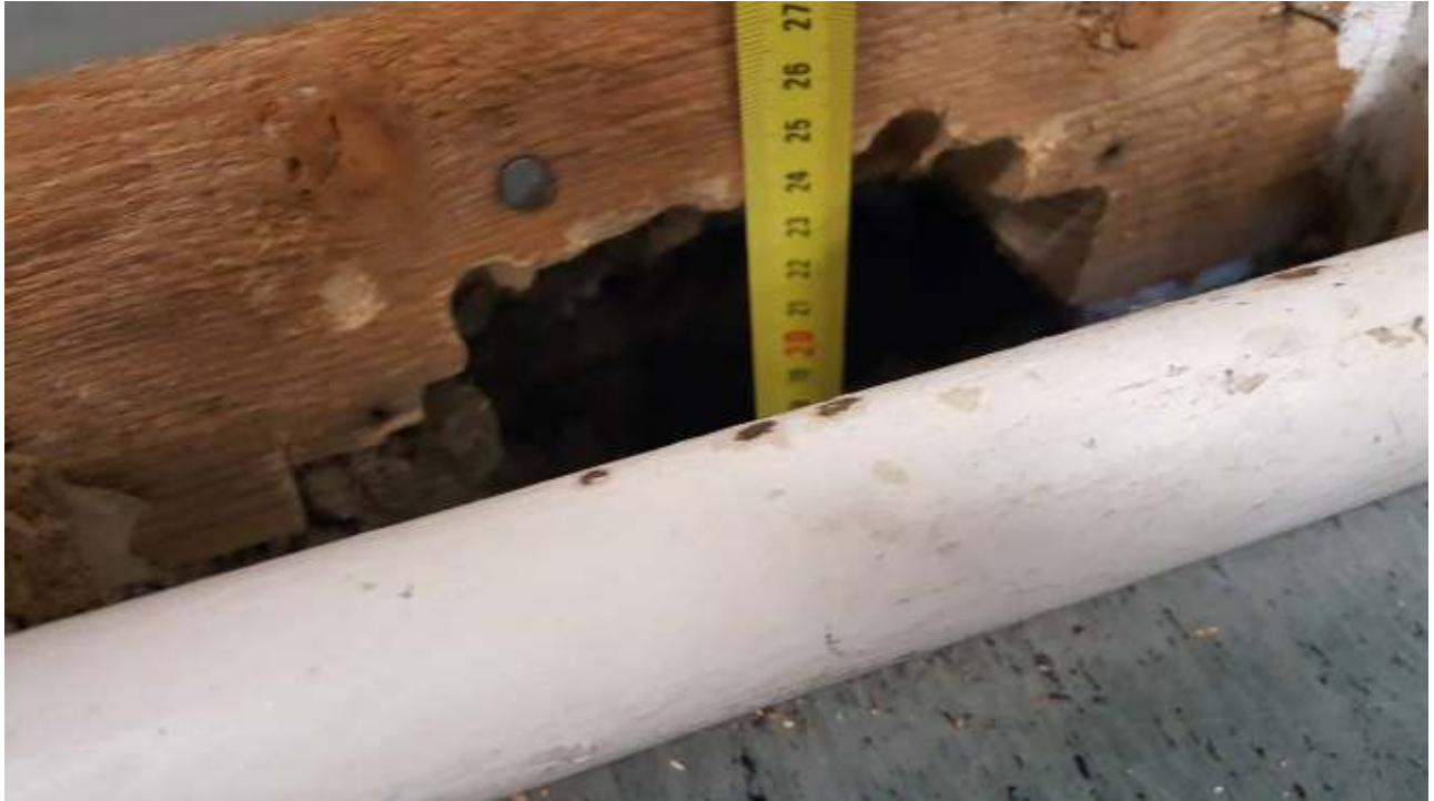
Kuva 8. Lämmöneristys jatkuu lattiapinnan alapuolelle.
