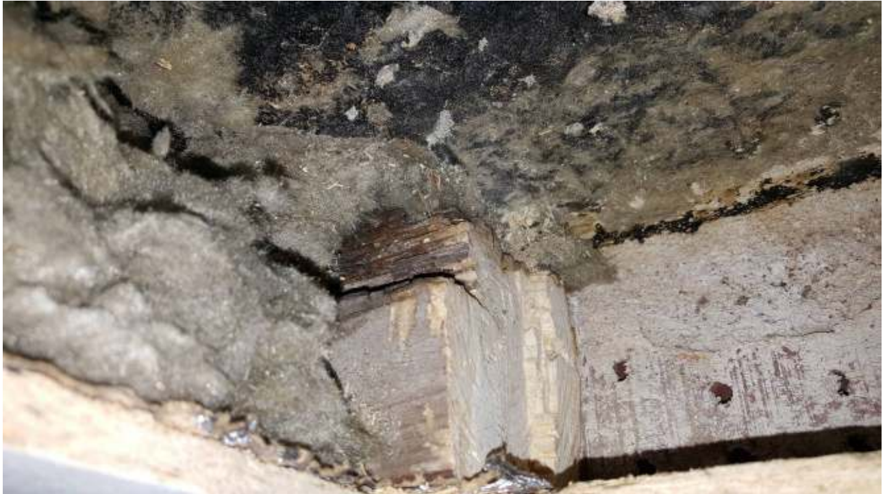
Kuva 10. Alaohjauspuun ulkopinta on lahovaurioitunut. Alaohjauspuiden alla on tiilimuuraus aiemmissa rakenneavauksista poiketen.
