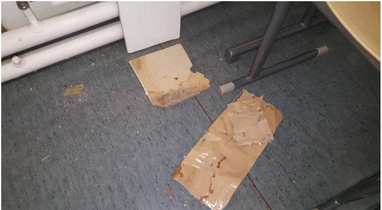
Kuva 3. Yleiskuva tutkimuspaikasta RA1. Ilmansulkupaperin taustassa on vesivuotojälkiä. Lastulevyn taustassa on kosteus- ja mikrobivaurio.
