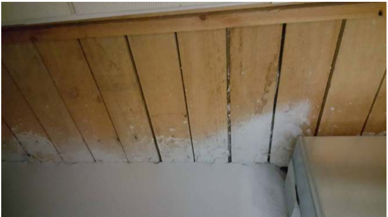
Kuva 24. Yleiskuva luokkatilan käytävän alaslaskutilasta. Yläpohjan koolauspuussa on vesivuotojälkiä.
