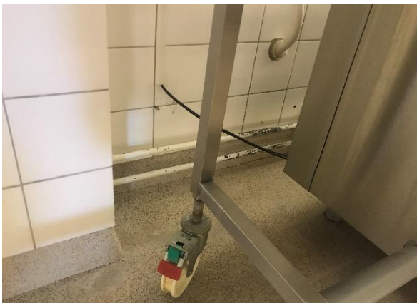
Kuva 45 Keittiön astianpesukonelinjan taustalla lattia- ja seinäliittymärajasuma on avoin ja seinässä on avoimia kiinnityspisteitä joista voi imeytyä kosteutta rakenteisiin.
