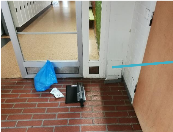
Kuva 66 Vanhan ulkoseinän rakennetta tarkasteltiin liikuntasalin ovien vierestä eteisaulan puolelta (VS1).
