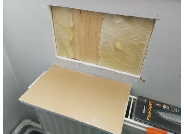
Kuva 56 Laajennetulla osalla lämmöneristeet vaikuttivat aistinvaraisesti arvioituna yleisesti hyväkuntoisilta (US13). Kipsilevyjen sisäpinnoissa ei havaittu aistinvaraisesti viitteitä vaurioista.
