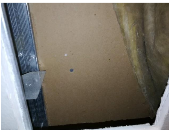
Kuva 70 Laajennusosan kevytrakenteisen väliseinät on toteutettu metallirangoilla (VS3).
