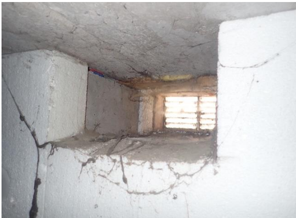
Kuva 26 Ryömintätilassa on poistoilmavaihto, korvausilma ryömintätilaan johdetaan sokkeliin tehtyjen tuuletusaukkojen kautta.
