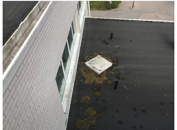
Kuva 81 Yleiskuva pukuhuone- ja pesuhuonetilojen päällä olevasta vesikatosta. Katteen pinnalla on jonkinverran sammalta.
