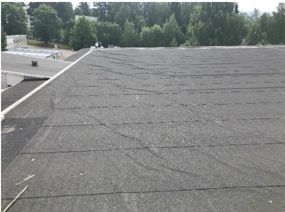
Kuva 82 Liikuntasaliosan vesikatteessa esiintyy melko runsaasti vesikatteen pussittamista.
