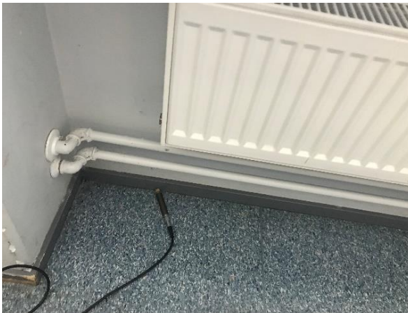
Kuva 63 Laajennetulla rakennuksen osalla havaittiin merkkiainekokeessa ilmavuotoja alapohja- ja ulkoseinäliittymissä.
