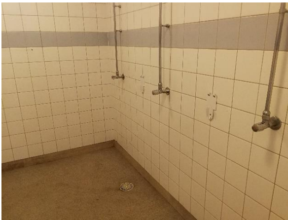
Kuva 74 Liikuntasalin pukuhuoneiden yhteydessä olevien märkätilojen latioissa vedeneristeenä toimii muovimatto. Seinien vedeneristeestä ei ole varmuutta.
