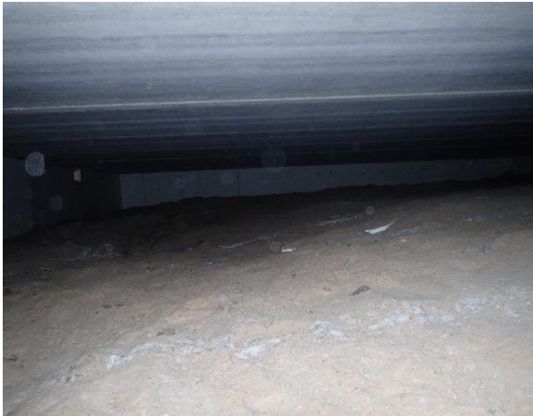
Kuva 24 Yleiskuvaa ryömintätilasta. Ryömintätilan maapohja on hienojakoista hiekkaa. Ryömintätilassa ei ole havaittavissa ulkopuolista kosteusrasitusta tai ryömintätilaan ei ole ohjautunut pinta/valumavesiä.
