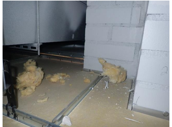
Kuva 91 Alakattojen päällä havaittiin paikallisesti kuitulähteitä.
