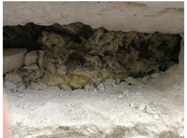
Kuva 38 Mineraalivilloissa on havaittavissa ilmavuotojen aiheuttamaa tummentumaa (US30). Julkisivuverhouksen ja eristeen välissä ei ole yhtenäistä tuuletusväliä.
