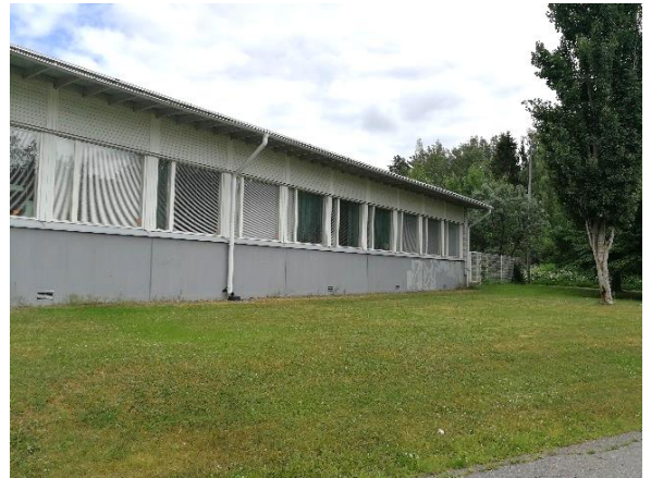
Kuva 5 Rakennuksen eteläpuolella maanpinta viettää rinteen mukaisesti rakennuksesta poispäin.
