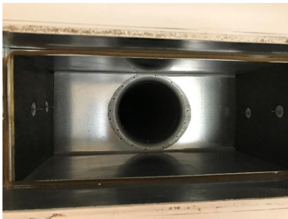
Kuva 96 Tuloilmakanavien ja päätelaitteiden puhtautta tarkasteltiin aistinvaraisesti.
