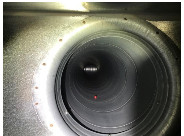
Kuva 97 Kanavissa tai päätelaitteissa ei havaittu pölyä.
