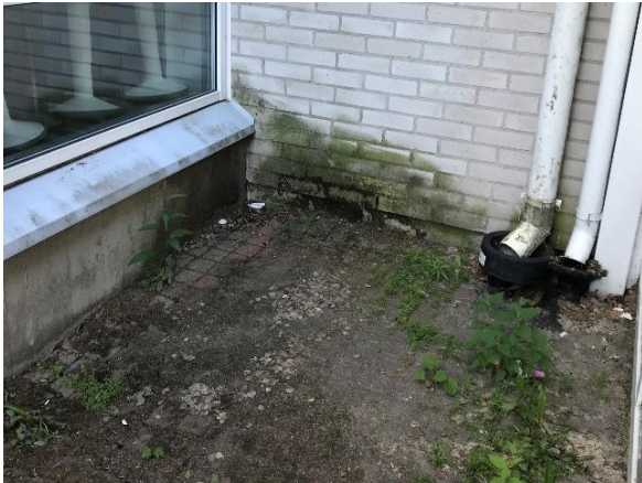
Kuva 13 Musiikkiluokan ja pääsisäänkäynnissä räystäs-kourun kallistuksissa on puutteita, suoraan räystäältä tippuva vesi pääsee kastelemaan seinärakenteita.
