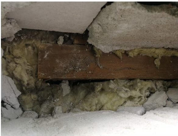
Kuva 39 Ikkunan alapuolinen rakenneavaus (US29).
