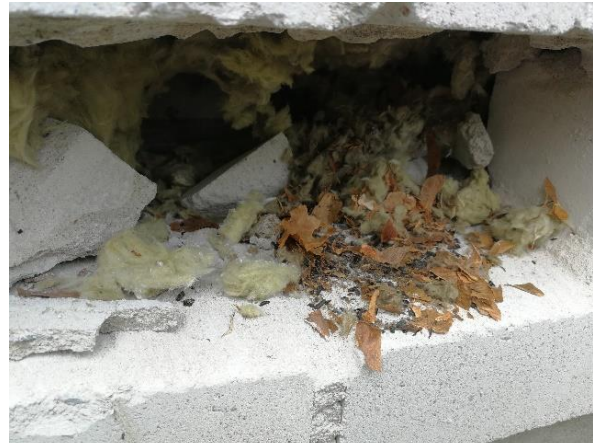
Kuva 42 Jyrsijöiden aiheuttamia jälkiä oli havaittavissa myös liikuntasalin pukuhuoneiden vastaisella ulkoseinällä (US28).
