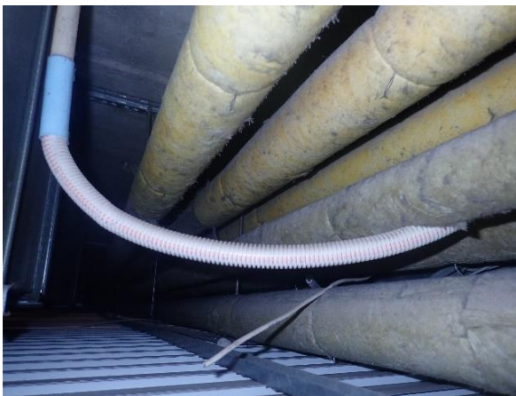
Kuva 92 Alakattojen päällä kulkee pinnoittamattomia, mineraalivillalla eristettyjä putkia, joista voi irrota mineraalikuituja sisäilmaan.
