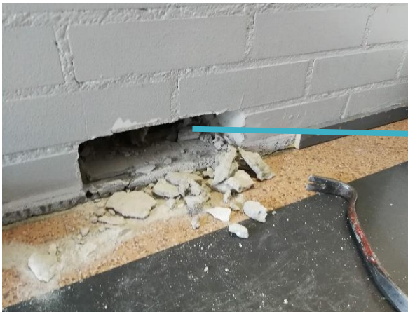
Kuva 68 Toinen vanhan ulkoseinän rakenneavaus tehtiin käytävään 71 (VS2). Näyteanalyysin tulos viittaa eristemateriaalin mikrobivaurioon.
