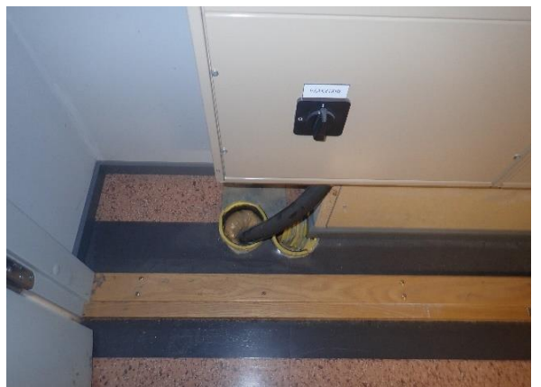
Kuva 29 Sähkökaapeleiden läpiviennit on tiivistetty polyuretaanilla.
