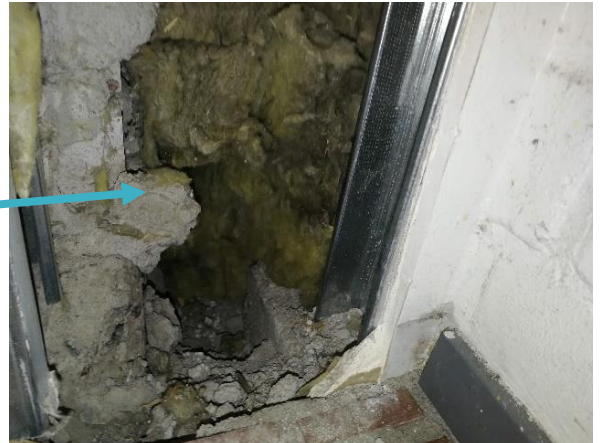
Kuva 67 Vanhan ulkoseinän mineraalivillaeristeissä todettiin voimakasta tummentumaa. Näyteanalyysin perusteella seinäeristeissä on vahva viite materiaalin mikrobivaurioista.
