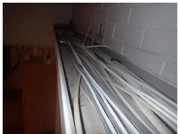
Kuva 95 Johtohyllyt tulisi puhdistaa.
