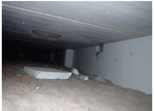
Kuva 27 Ryömintätilan sokkelipinnat on lämmöneristetty EPS-eristeellä ryömintätilan puolelta.
