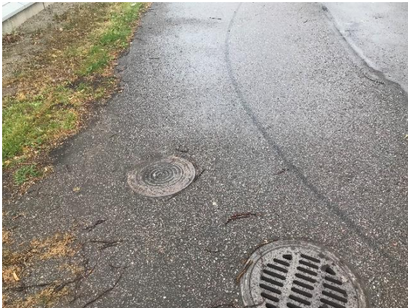
Kuva 15 Asfaltoidulla alueella pintavedet on johdettu ritaläkaivoihin.
