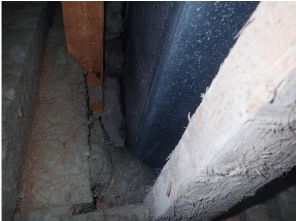
Kuva 88 Yläpohjasta keittiöön johtavien iv kanavaläpivienti ympäristöt ovat avoimia (liittymärakenteet tiivistettävä)
