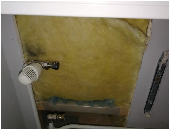
Kuva 57 Kotitalousluokkaan 1 (27) tehdyssä rakennearvauksessa havaittiin hieman ilmavuodon aiheuttamaa tummentumaa patterin termostaatin kohdalla (US12).
