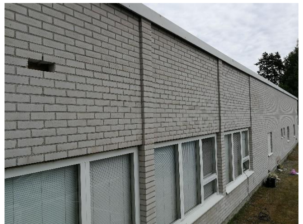
Kuva 52 Ruokasalin etelän puoleisella julkisivulla, ikkunoiden yläosissa lämmöneristeenä on käytetty uretaanilevyä.
