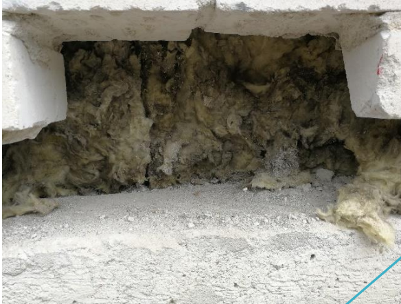
Kuva 47 Pesulinjaston kohdalle tehdyssä avauksessa havaittiin mineraalivillassa tummentumaa (US9). Mineraalivillasta otetussa näytteessä todettiin vahva viite vauriosta.
