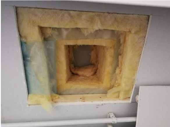
Kuva 55 Laajennetulla rakennuksen osalla ulkoseinien avaukset suoritettiin sisäkautta (US14). Höyrinsulkumuovi on sijoitettu kahden villakerroksen väliin.
