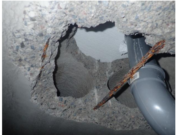
Kuva 25 Ryömintätilan läpivientien tulisi olla tiivistetty, muuten ilmuuodot ryömintätilasta sisäilmaan ovat mahdollisia.
