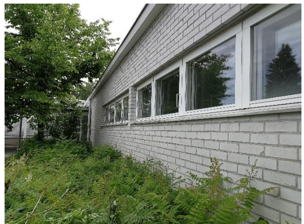
Kuva 7 Rakennuksen pohjoispuolella ulkoseinänvierustalla on kasvillisuutta, jotka lisäävät ulkoseinään kohdistuvaa kosteusrasitusta.
