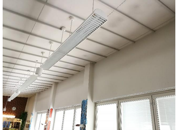
Kuva 54 Ruokasalissa ikkunoiden yläpuolella on betoninen sisäkuori.
