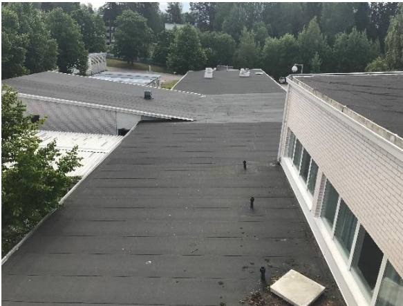
Kuva 80 Yleiskuva rakennuksen alkuperäisen osan vesikatolta musiikkiluokkalaajennuksen vesikatolle.
