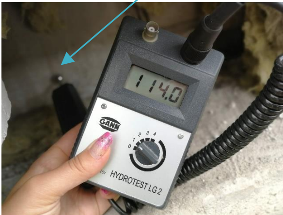
Kuva 49 Avauskohdan pilarissa havaittiin kosteusvaurioon viittaavaa kalkkihärmää (US9). Myös tiilissä esiintyy värjäytymää.
