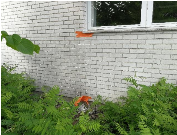
Kuva 37 Rakennuksen julkisivuun tehtiin rakenneavauksia ikkunoiden alapuolelle sekä ulkoseinärakenteiden alaosiin (US29, US30).
