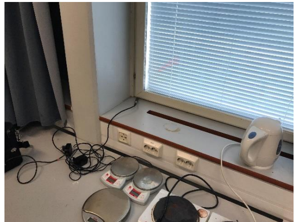
Kuva 64 Laajennetulla rakennuksen osalla havaittiin merkkiainekokeissa ilmavuotoja ikkunaliittymissä.
