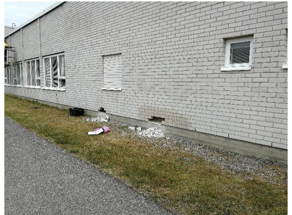
Kuva 44 Keittiön pesulinjaston vastaisella seinustalla oli ulkopuolella havaittavissa kosteusvaurioon viittaavia jälkiä. Molempiin kohtiin tehtiin rakenneavaukset. Pesulinjaston kohdalla ulkoseinän sisäpinnassa havaittiin pintakosteusmittarilla viitteitä kohonneesta kosteudesta.
