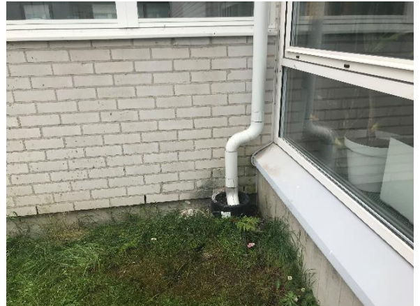
Kuva 14 Musiikkiluokan ja ruokalan välisessä kulmauksessa syöksytorstista on päässyt roiskumaan vettä myös sokkeli – ja seinäpinnalle.
