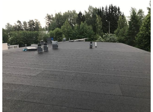
Kuva 79 Yleiskuva rakennuksen v 1998 laajennusosan vesikatoilta. Vesikatteet ovat yleisesti hyväkuntoisia.
