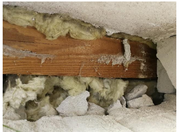
Kuva 40 Ikkunan alapuolinen rakenneavaus (US3).
