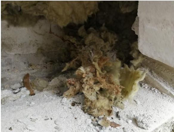
Kuva 41 Musiikkiluokan ja pääsisäänkäynnin väliin tehdyssä ulkoseinän rakenneavauksessa havaittiin eristetilassa jyrsijöiden jälkiä (US1).
