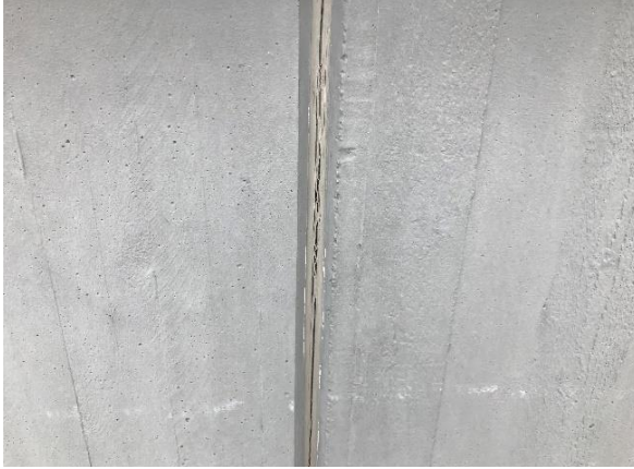
Kuva 20 Sokkelin elementtisaumat ovat halkeilleet.
