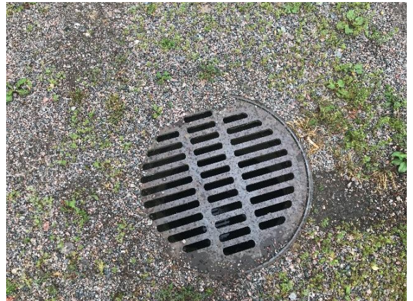
Kuva 16 Sora-alueella pintavedet on johdettu ritaläkaivoihin.
