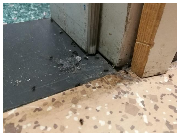
Kuva 71 Laajennusosan maantieto-biologia-luokkien vastaisella väliseinällä havaittiin keväällä runsaasti muurahaisia.
