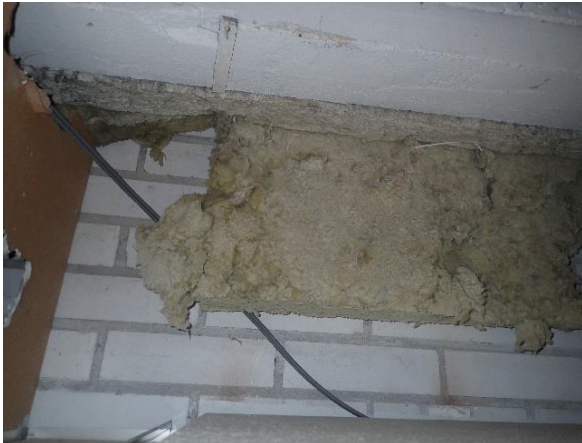
Kuva 90 Liikuntasalin ovien yläpuolella vanhan ulkoseinärakenteen ulkokuori on purettu, mutta vanhat eristeet on jätetty avoimena rakenteeseen.
