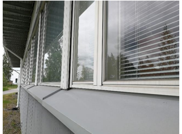
Kuva 60 Laajennetulla osalla ikkunat ja pellitykset ovat pääosin hyväkuntoiset.
