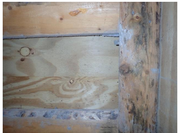
Kuva 93 Fysiikka-kemia-luokkien viereisen käytävän ja pääovilta tulevan käytävän risteyskohdassa alakattojen päällä on vanerinen kotelointi, jossa on havaittavissa selvää mikrobikasvua.
