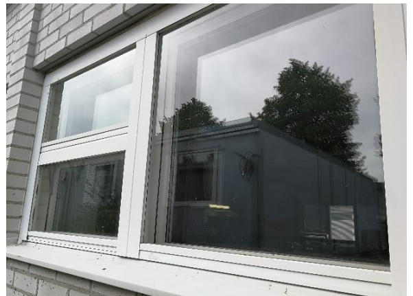
Kuva 62 Alkuperäisen rakennuksen osan ikkunat ovat hyväkuntoiset.
