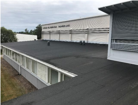
Kuva 78 Yleiskuva rakennuksen v 1998 laajennusosan vesikatoilta. Vesikatteet ovat yleisti hyväkuntoisia.
