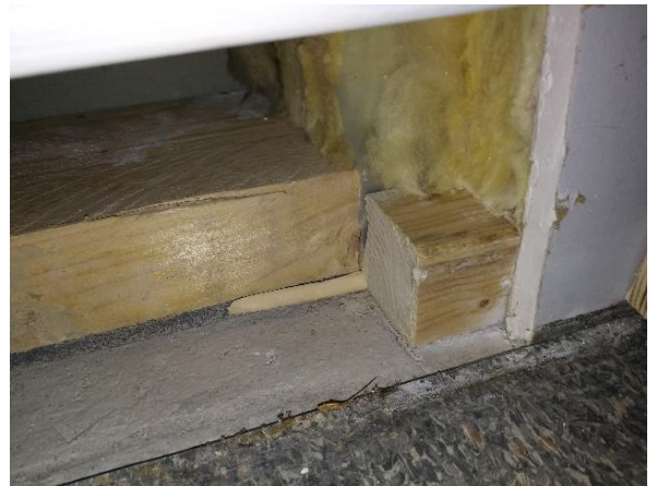
Kuva 58 Alaohjauspuun alla on käytetty talotiivistettä (US12). Höyrinsulun alareuna on käännetty alaohjauspuun alle, jolloin rakenne on saatu tiiviiksi.
