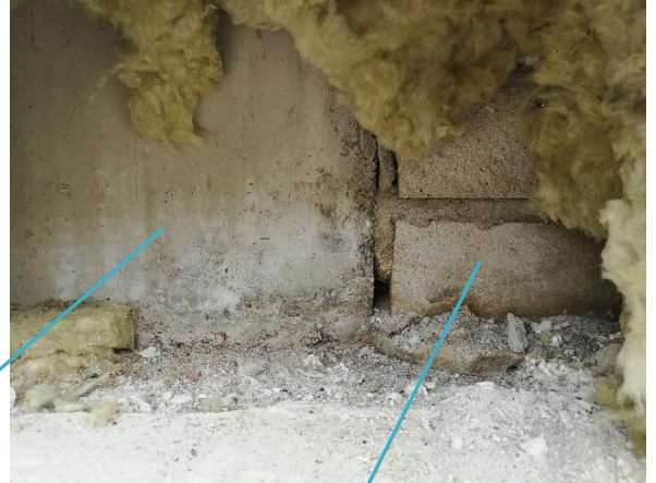
Kuva 48 Avauskohdan pilarissa havaittiin kosteusvaurioon viittaavaa kalkkihärmää. Myös tiilissä esiintyy värjäytymää.
