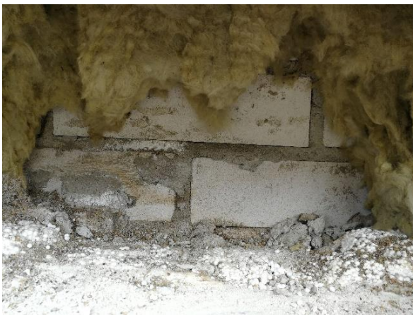
Kuva 51 Keittiön pesulinjaston kohdalle tehdyssä rakeneavauksessa havaittiin tiilisaumoissa kosteusvaurioon viittaavaa kalkkihärmää (US8).
