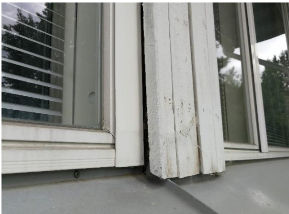
Kuva 61 Ikkunan väliset peitelaudat tulisi kiinnittää uudelleen.
