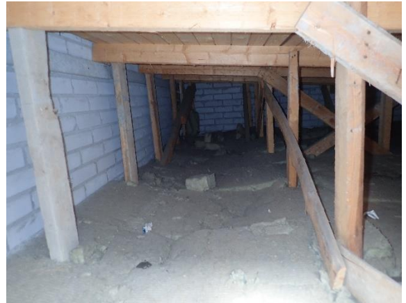
Kuva 89 Yleiskuva pukuhuonetilojen päällä olevasta yläpohjasta. Yläpohjarakenne on tuulettuva ja toimiva. Vesikate tai läpivientivuodoista aiheutuvia kosteusjälkiä ei havaittu.
