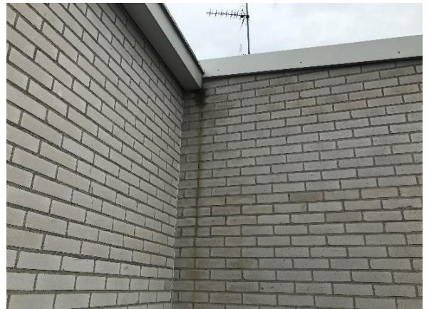
Kuva 83 Rästaskourun kallistus on puutteellinen ja katovedet pääsevät valumaan ulkoseinärakennetta pitkin (liikuntahalliosaa vasten oleva seinäkulmaus)
