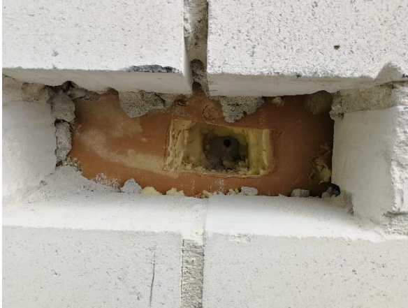
Kuva 53 Polyuretaanilevy on kiinnitetty suoraan betoniin sisäkuoreen.
