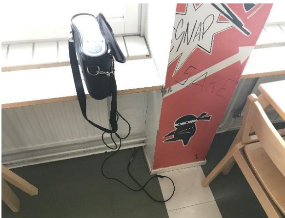
Kuva 65 Alkuperäisellä rakennuksen osalla havaittiin merkkiainekokeissa ilmavuotoja niin alapohja- ja ulkoseinäliittymissä.
