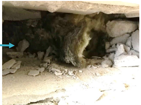
Kuva 69 Vanhan ulkoseinän mineraalivillaeristeissä todettiin voimakasta tummentumaa rakenteen läpi tapahtuneiden ilmvuotojen johdosta.
