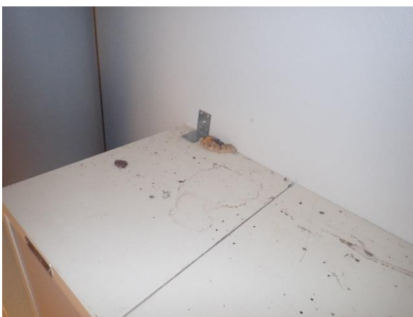
Kuva 94 Yläpölyjä esiintyi kaappien päällä paikoitellen runsaasti.
