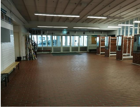
Kuva 72 Yleiskuvaa alkuperäisen rakennuksen osan sisäänuloaulasta. Lattiapinnoitteena on käytetty tiililaattaa.
