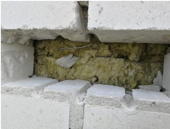
Kuva 43 Liikuntasalin päädyssä, ulkoseinän yläosaan tehty rakenneavaus (US23). Mineraalivillaeriste on kiinni julkisivuverhouksessa, jolloin eristetilä ei pääse tuulettumaan.
