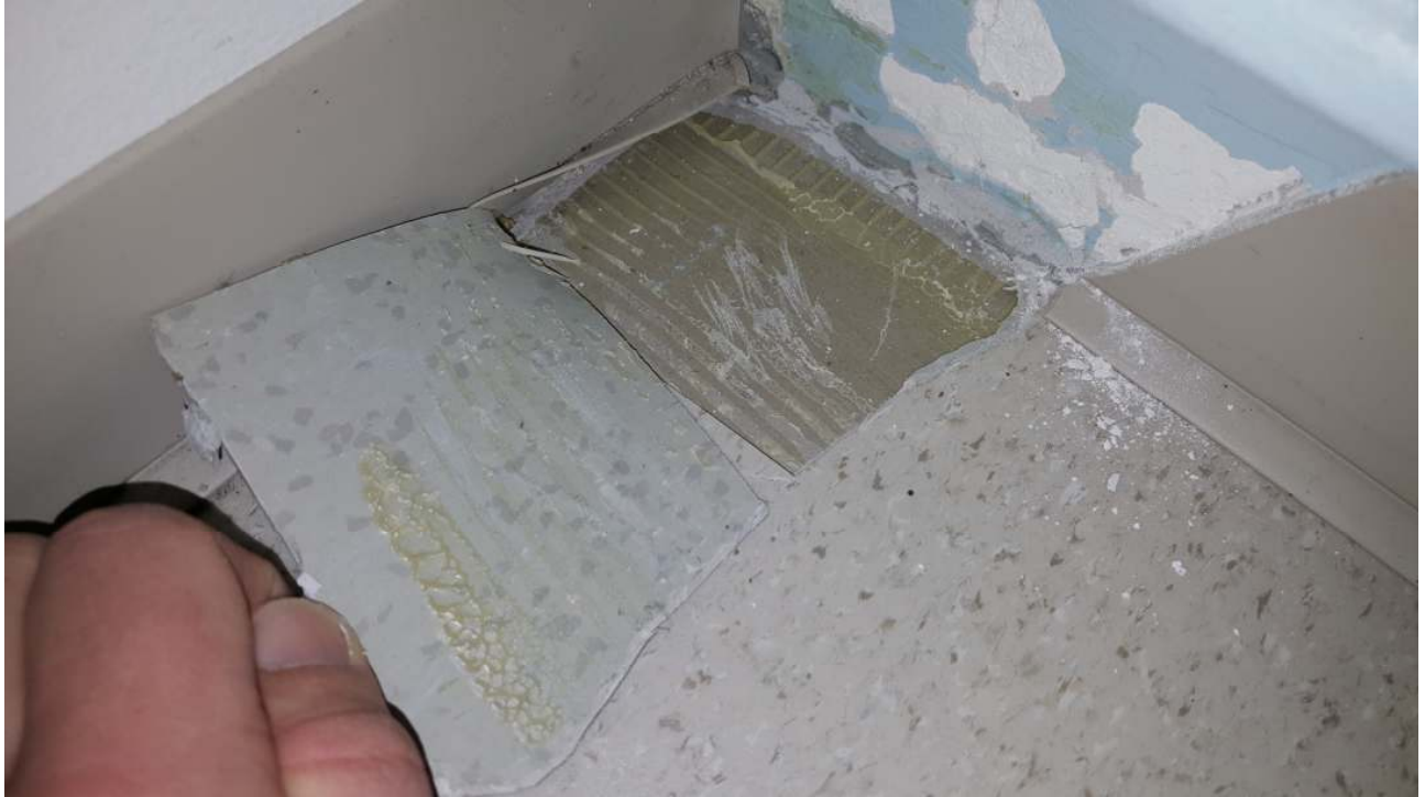
Kuva 5. Vertailuna valokuva vaurioitumattomasta kohdasta mittapisteiden 6 ja 7 kohdalta.
