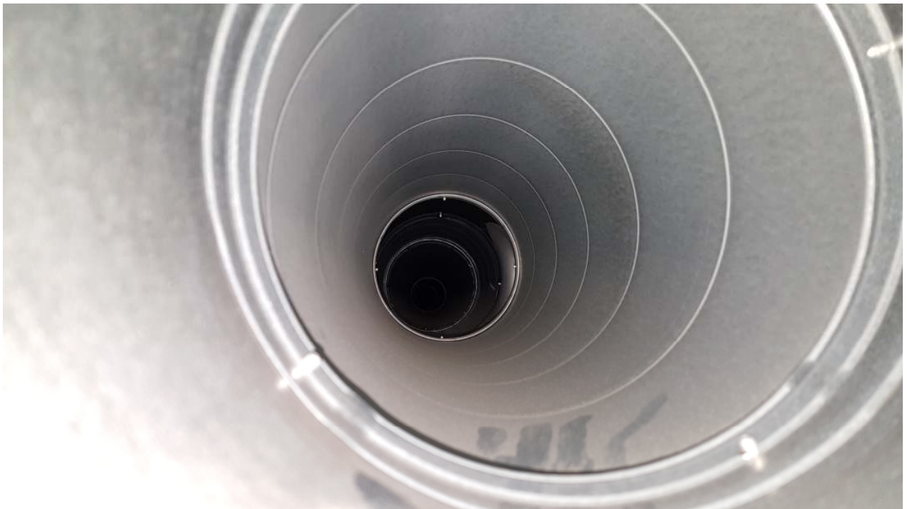
Kuva 24. Tuloilman runkokanavassa on pölyä.
