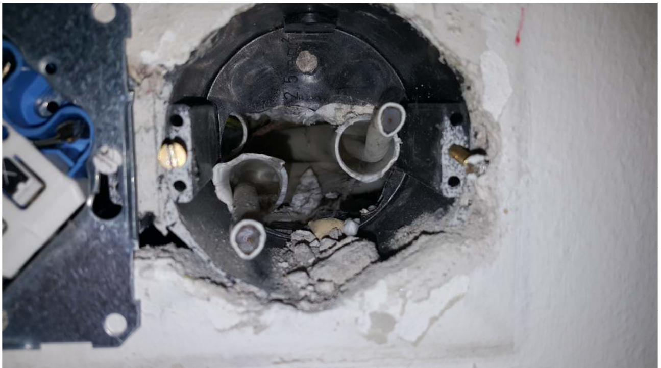
Kuva 33. Ulkoseinällä sijaitsevasta pistorasiasta havaittiin voimakas ilmavuoto huonetilaan päin. Ilmavuodon mukana tuli voimakas mikrobiperäinen haju /homeen haju. Rasian pohjasta on suora yhteys ulkoseinän eristetilaan.
