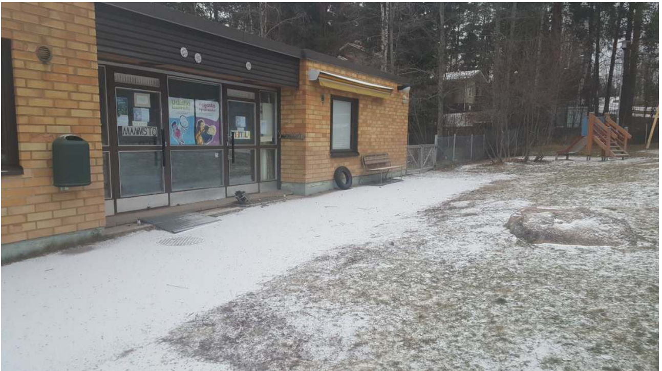
Kuva 17. Rakennuksen päädyssä sokkelin korkeus nousee, sokkelin yläreuna on noin 200 mm lattiaa ylempänä. Ulkonurkalla maanpinta on lattiapinnan kanssa samalla tasolla.
