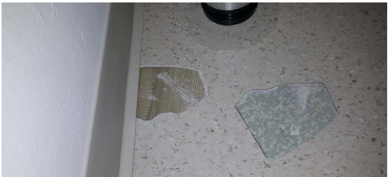
Kuva 4. Mittapisteiden 10 ja 11 kohdalta irroitettu muovimatto, kohdassa on matto-/liimavaurio.
