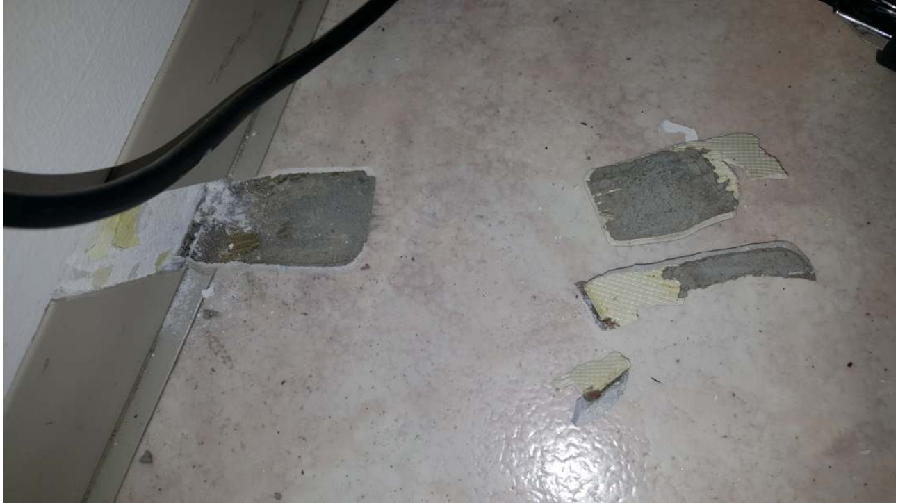
Kuva 15. Näytteenottopaikka MB11 ja MB12. Lattiatasoite irtosi näytepalan mukana helposti.
