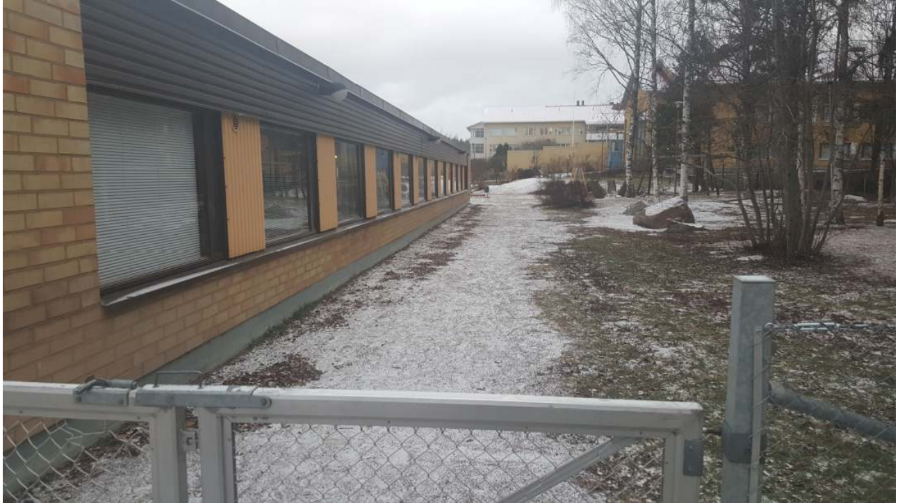
Kuva 18. Takapihan puolella sokkelin yläreuna on noin 200 mm lattiaa ylempänä. Maanpinta on lattiapinnan kanssa samalla tasolla/paikoin hieman lattiapintaa ylempänä ja viettää loivasti rakennusta päin.
