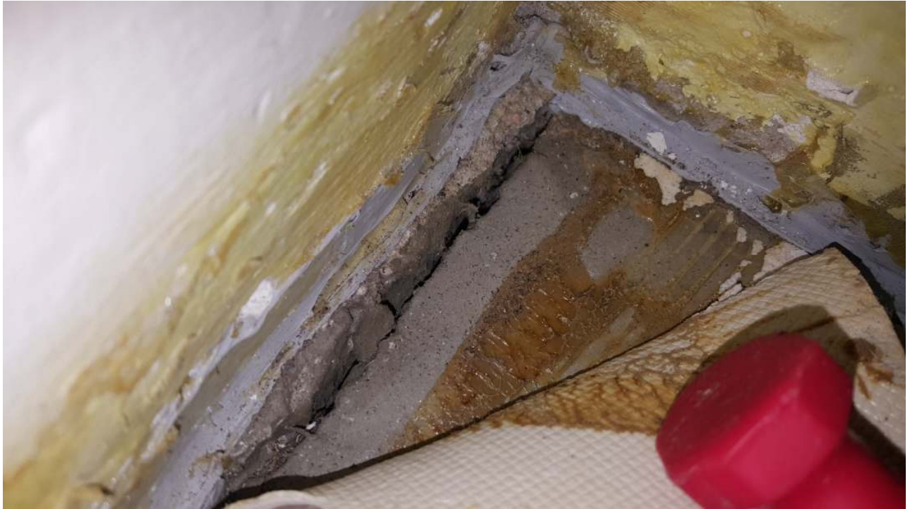
Kuva 28. Alapohjan ja seinän liittymässä on selkeä rako, josta havaittiin ilmavuotoa merkkisavun avulla. Liitosta on pyritty jollain aikavälillä tiivistämään. Ko. paikassa havaittiin mikrobiperäinen haju/homeen haju.
