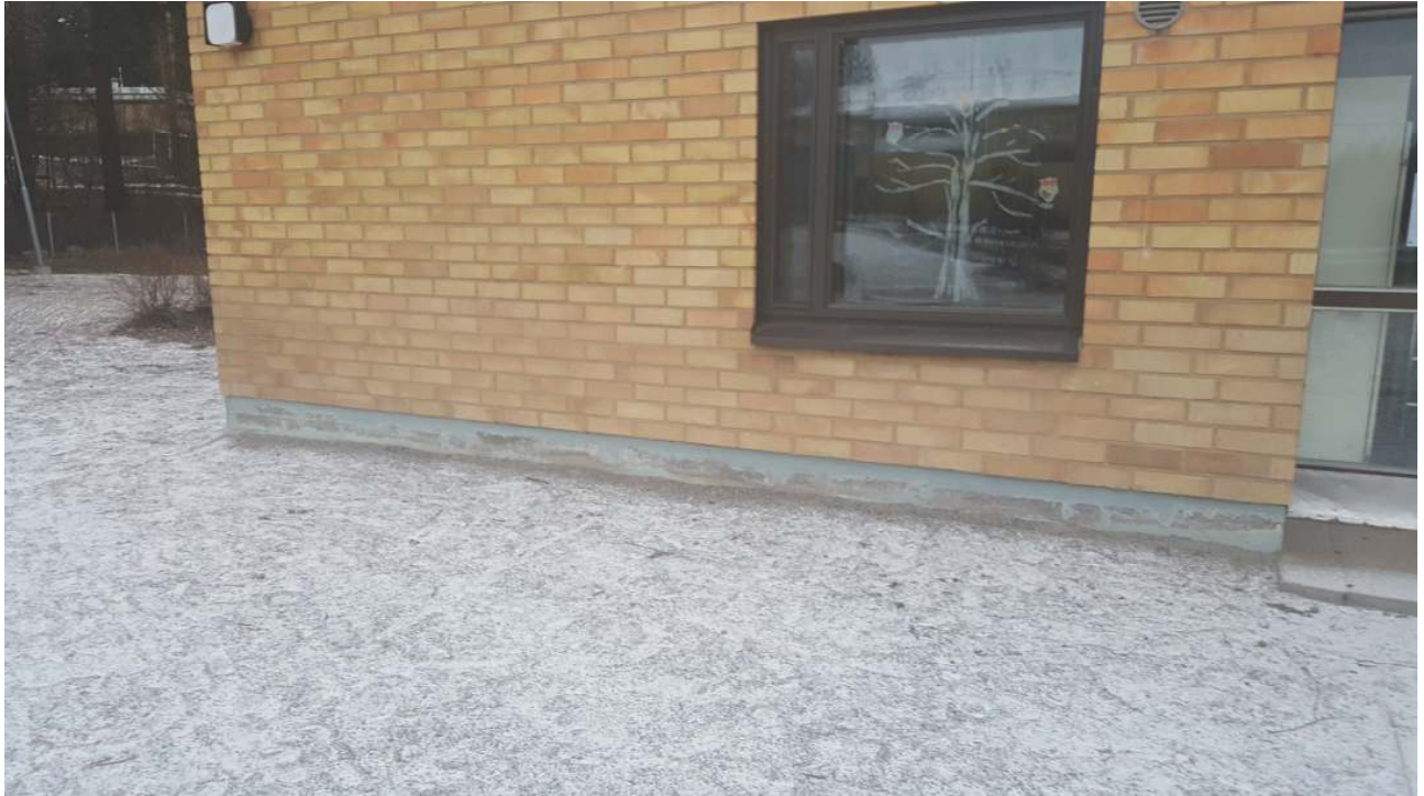
Kuva 20. Toisessa päädyssä sokkelin yläreuna on noin 200 mm lattiaa ylempänä. Maanpinta on lattiapinnan kanssa samalla tasolla.
