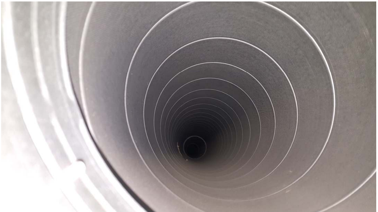
Kuva 26. Tuloilman runkokanavassa on pölyä.
