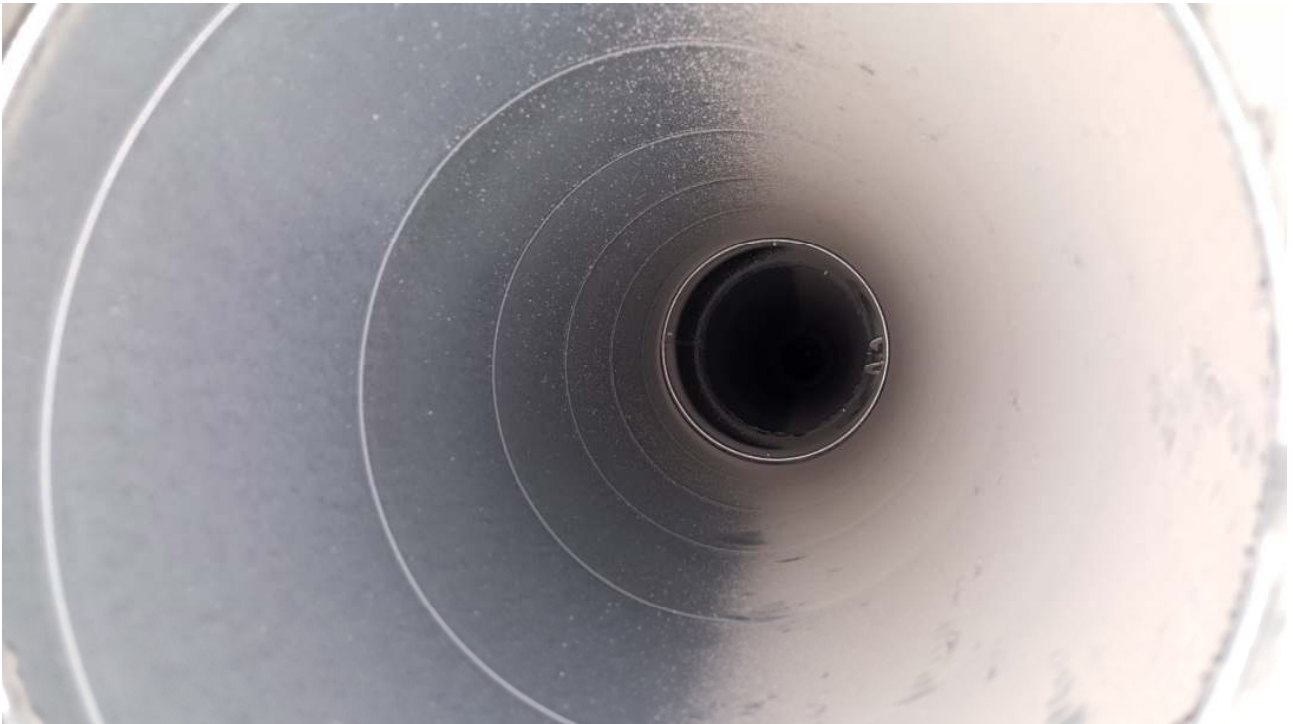
Kuva 22. Poistoilmakanavassa on runsaasti pölyä.
