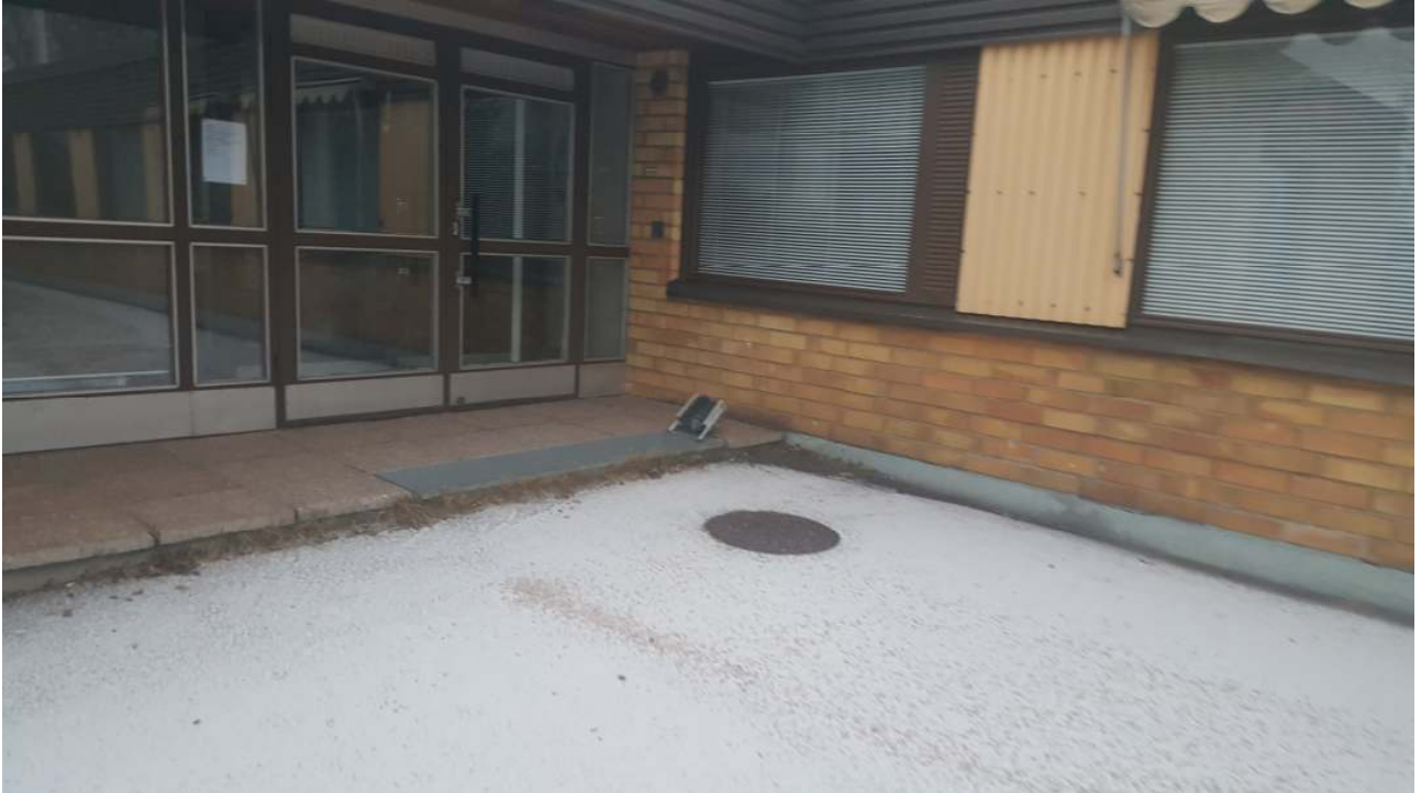
Kuva 16. Pääsisäänkäynnin kohdalla sokkelin yläreuna on lattian kanssa samalla tasolla, maanpinta on noin 200 mm lattiapintaa alempana.
