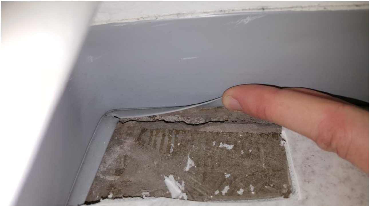
Kuva 27. Alapohjan ja seinän liittymässä on selkeä rako, josta havaittiin ilmavuotoa merkikisavun avulla. Ko. paikassa havaittiin mikrobiperäinen haju/homeen haju.
