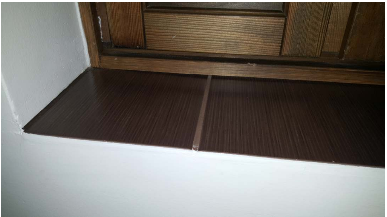
Kuva 29. Ulkoseinän ja ikkunan liittymästä havaittiin ilmavuotoa huonetilaan päin merkkisavun avulla.
