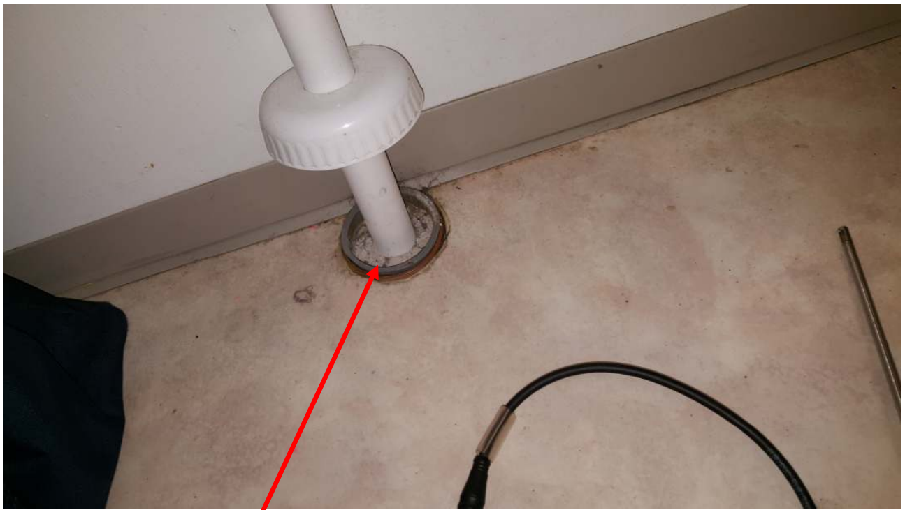
Kuva 35. Vientolan ryhmätilan käsienvesualtaan viemäriputkien liitoksesta havaittiin ilmavuotoa huonetilaan päin. Ilmavuodon mukana tuli viemäriin hajua.
