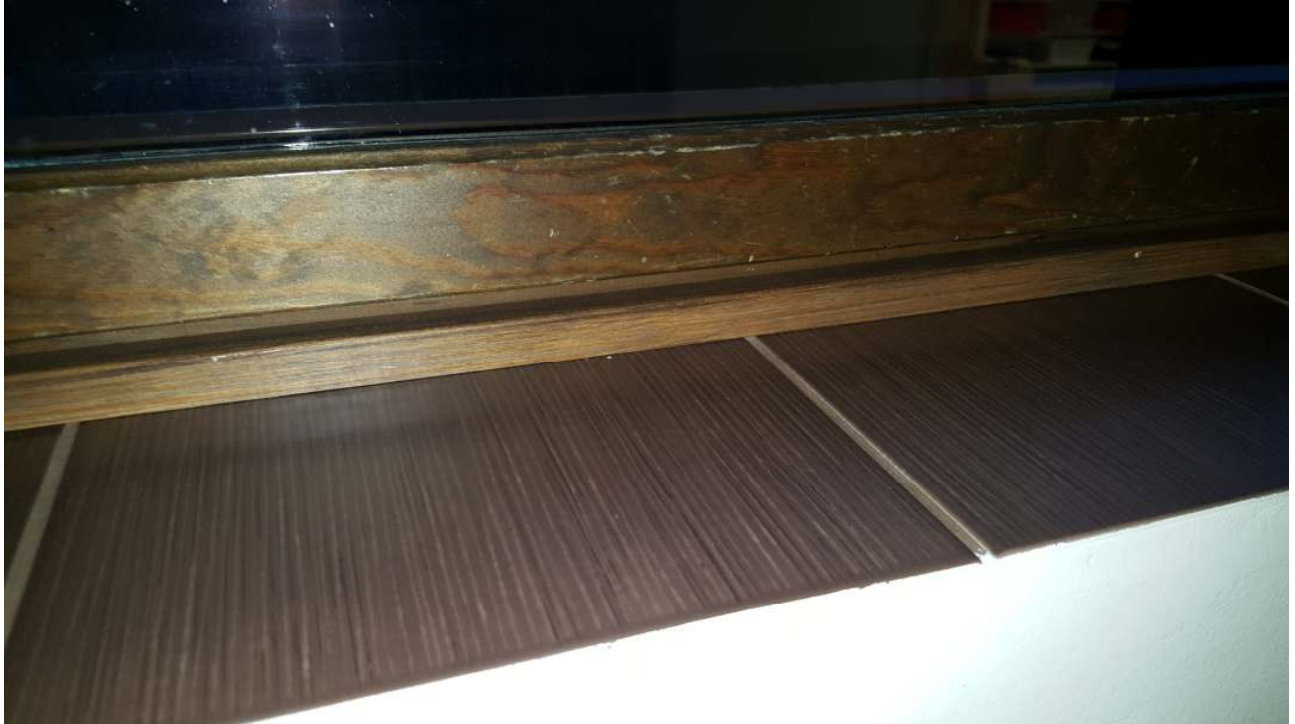
Kuva 30. Ulkoseinän ja ikkunan liittymästä havaittiin ilmavuotoa huonetilaan päin merkkisavun avulla.
