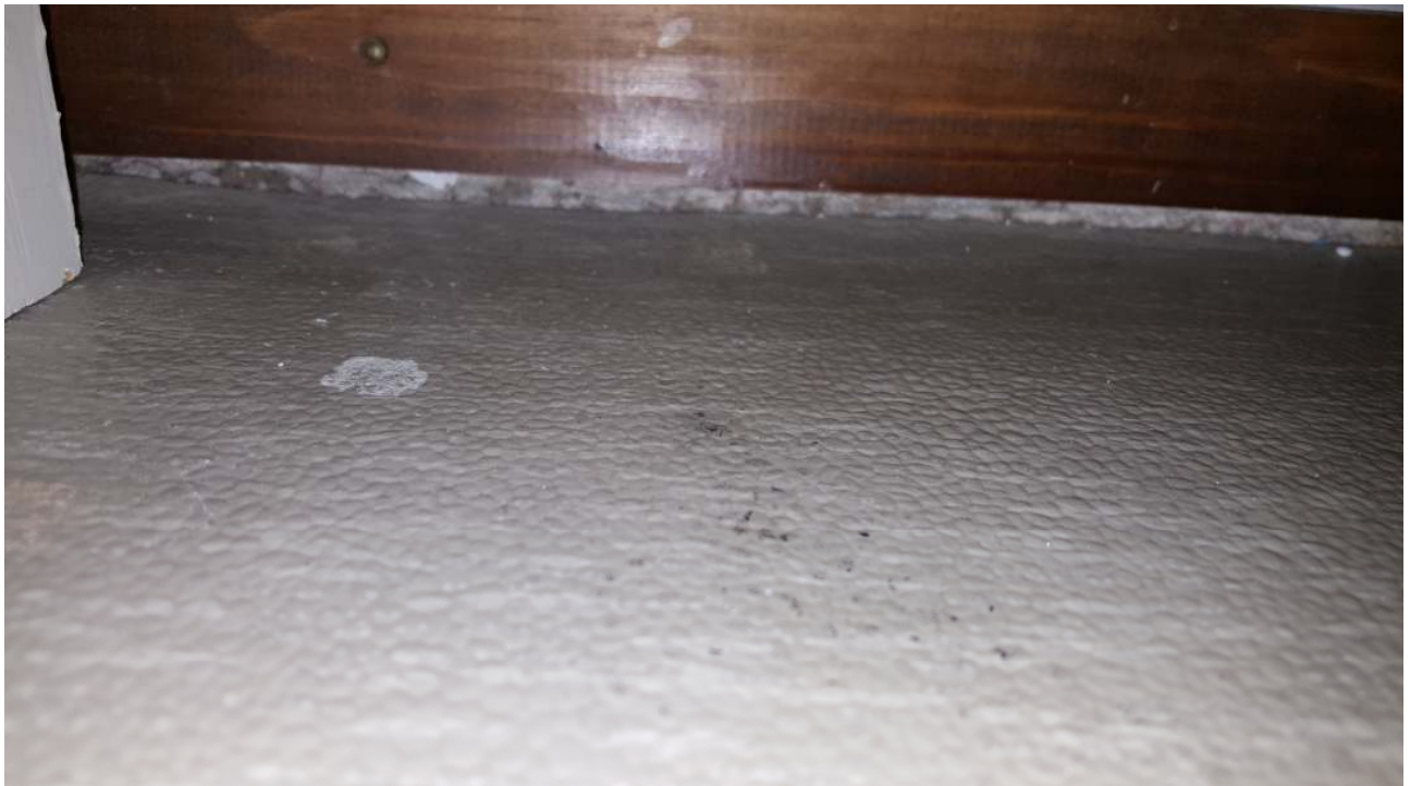
Kuva 31. Lattian ja jalkalistan välissä on selkeitä rakoja. Ko. paikoista havaittiin ilmavuotoa huonetilaan päin merkkisavun avulla.
