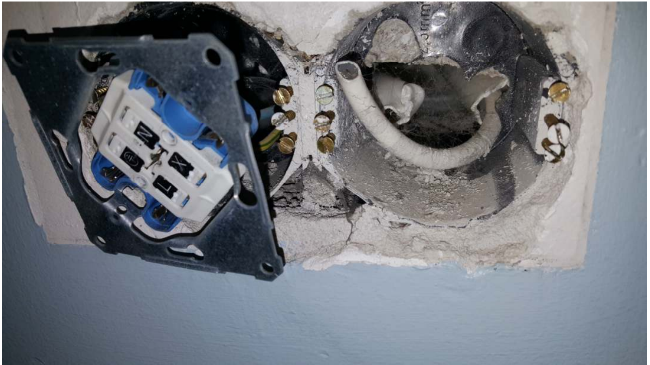
Kuva 34. Ulkoseinällä sijaitsevasta pistorasiasta havaittiin voimakas ilmavuoto huonetilaan päin. Ilmavuodon mukana tuli voimakas mikrobiperäinen hajuhomeen hajua. Rasian pohjasta on suora yhteys ulkoseinän eristetilaan.
