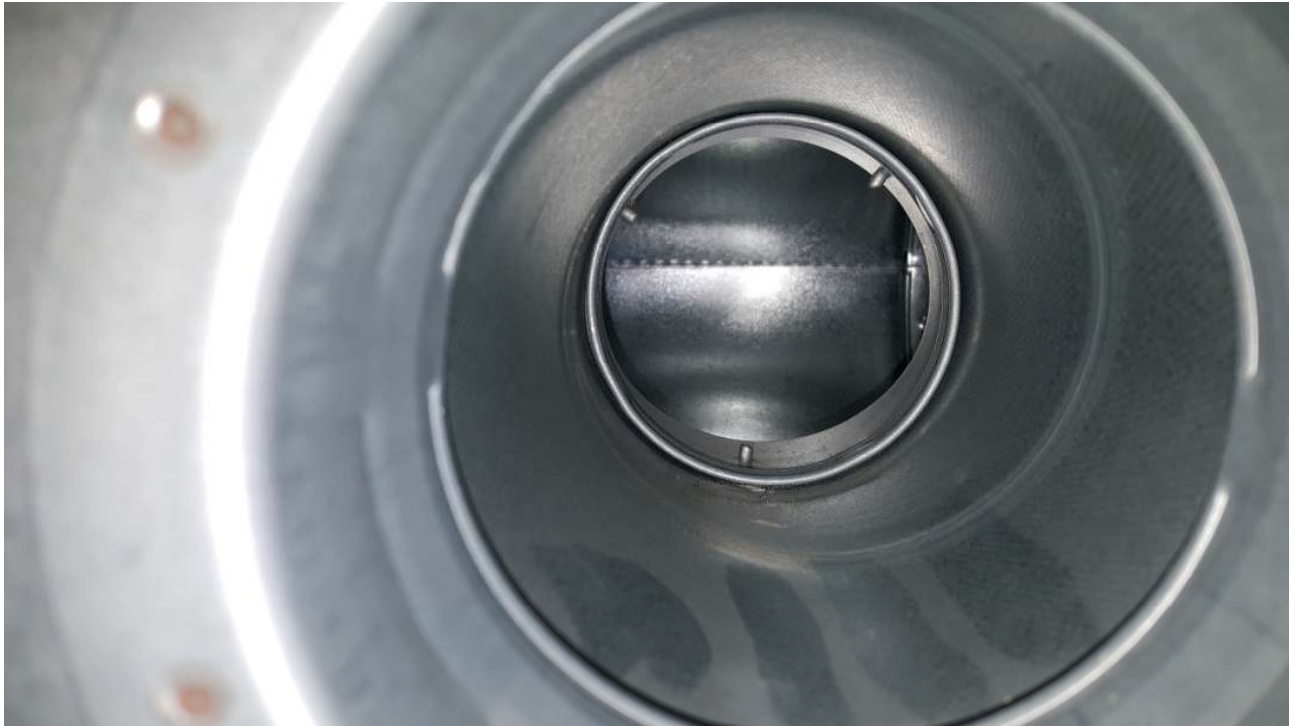
Kuva 23. Tuloilman haarakanavassa on jonkin verran pölyä.
