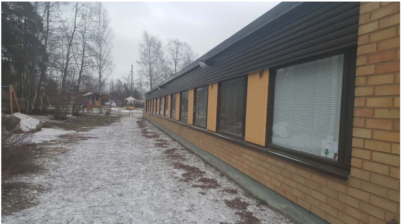
Kuva 19. Takapihan puolella sokkelin yläreuna on noin 200 mm lattiaa ylempänä. Maanpinta on lattiapinnan kanssa samalla tasolla/paikoin hieman lattiapintaa ylempänä ja viettää paikoin loivasti rakennusta päin.
