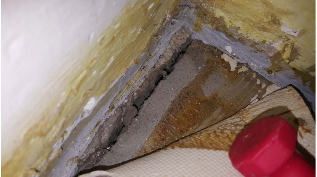
Kuva 13. Näytteenottopaikka MB9. Alapohjan ja seinän liittymässä on selkeä rako, josta havaittiin ilmavuotoa merkkisavun avulla. Liitosta on pyritty jollain aikavälillä tiivistämään. Ko. paikassa havaittiin mikrobiperäinen haju/homeen haju.
