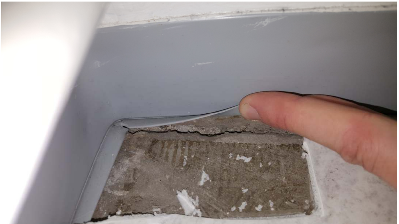
Kuva 12. Näytteenottoaikka MB7 ja MB8. Alapohjan ja seinän liittymässä on selkeä rako, josta havaittiin ilmavuotoa merkkisavun avulla. Ko. paikassa havaittiin mikrobiperäinen haju/homeen haju.
