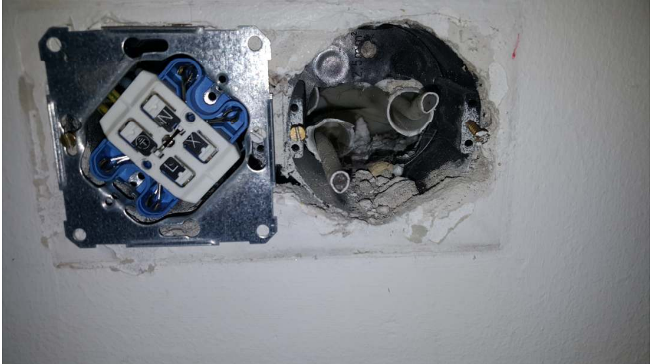
Kuva 32. Ulkoseinällä sijaitsevasta pistorasiasta havaittiin voimakas ilmavuoto huonetilaan päin. Ilmavuodon mukana tuli voimakas mikrobiperäinen haju /homeen haju.
