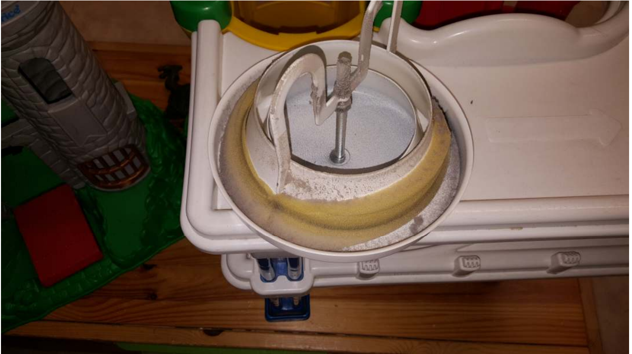
Kuva 21. Poistoilmaventtiilissä on runsaasti pölyä.
