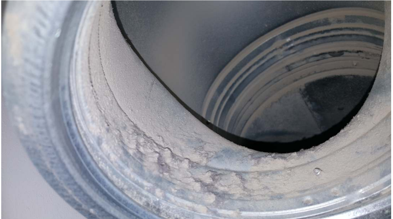
Kuva 25. Poistoilmakanavassa on runsaasti pölyä.
