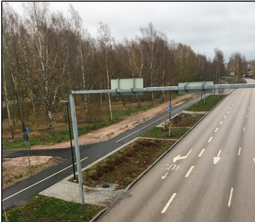
Kuva 8. Biosuodatuspainanne Espoon Merituulentiellä. (kuva L. Harilainen, Sitowise)
