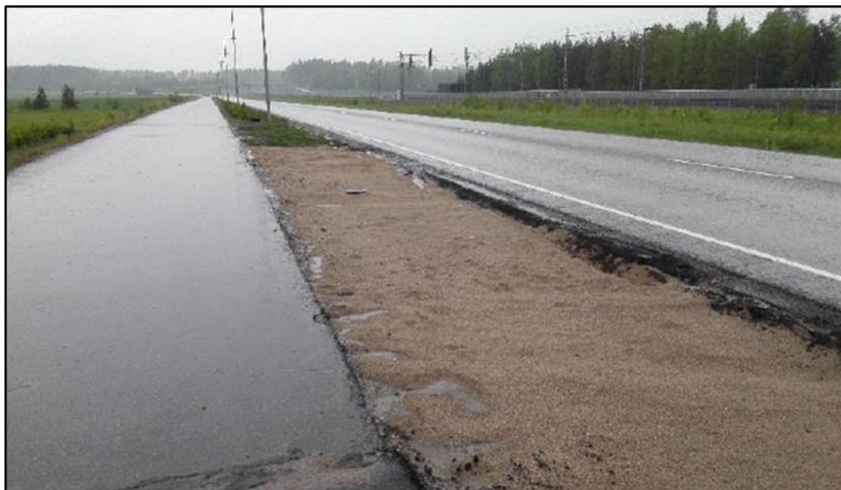
Kuva 10. Vantaan Tikkurilantien suodatusrakenteen, jonka toinen puolisko on hiekkapäällysteinen ja toinen puolisko hiekka-biohiilipäällysteinen. 4
