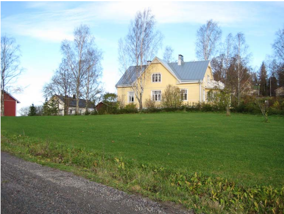
Kuva 23. Kihin tilan pihamaata, taustalla nykyinen päärakennus. Lounaasta. Kuv. K. Vuoristo.
