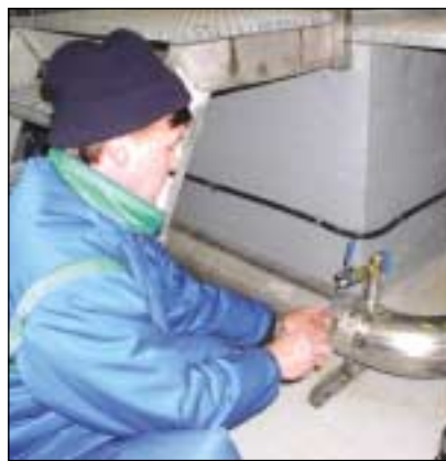
Verkkoon johdettavasta vedestä otetaan viisi erilaista näytettä, mm rauta- ja hiilidioksidipitoisuudesta.
